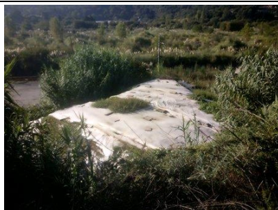
Acopio de tierra vegetal cubierto
