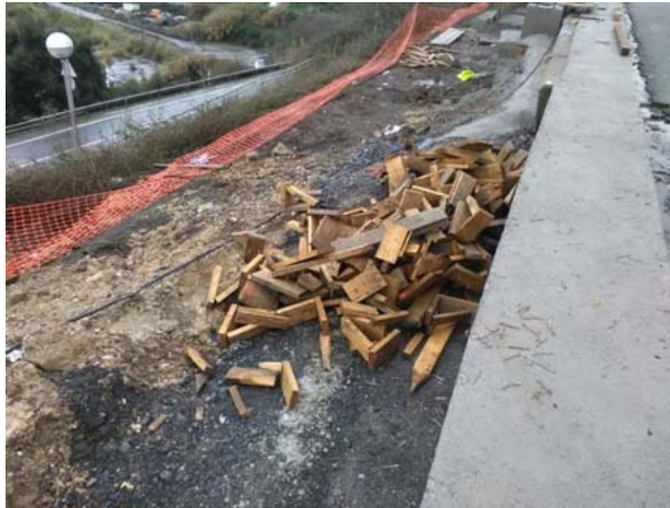
Madera acopiada para su retirada (31/01/19)
