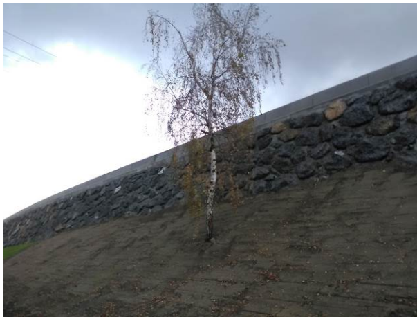
Ejemplar que se ha protegido a lo largo de la obra (09/01/19)
