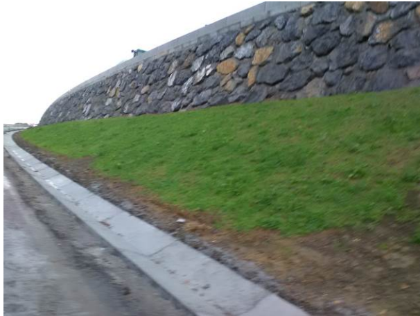
Talud en la bajada hacia Playabarri (09/01/19)
