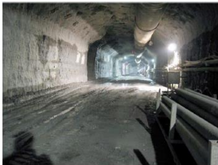
Figura 3: Túnel excavado en la extensión de la L2 del Metro de Montreal
