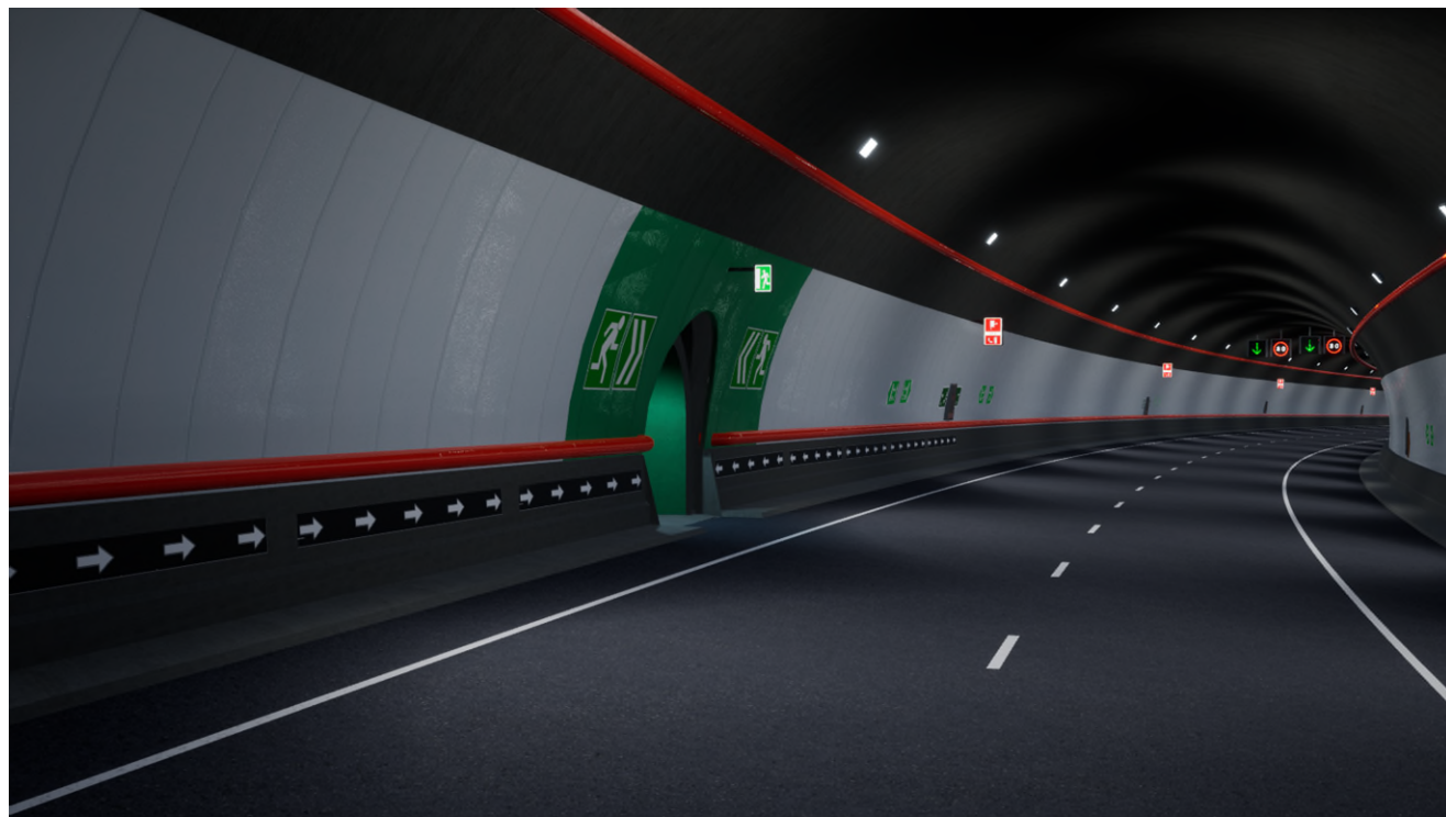
Figura 9: Interior de un túnel principal
