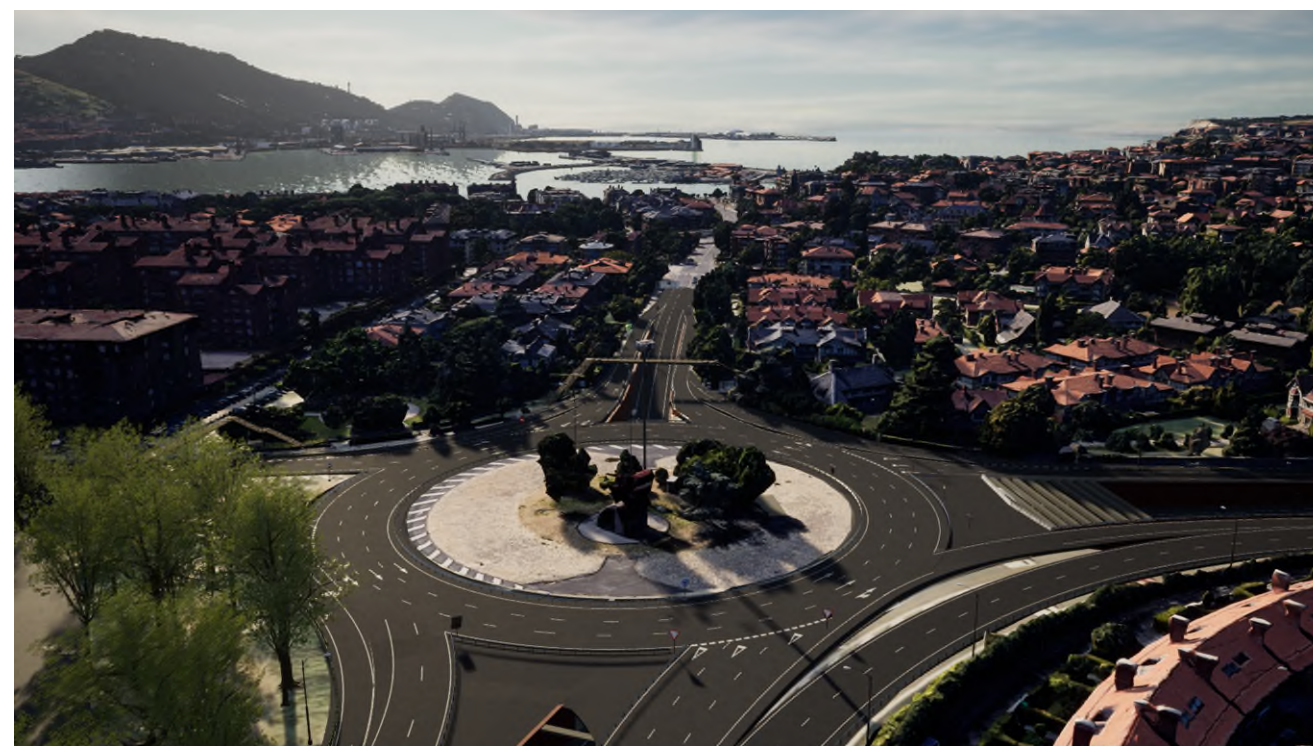
Figura 12: Vista general desde la Avanzada
