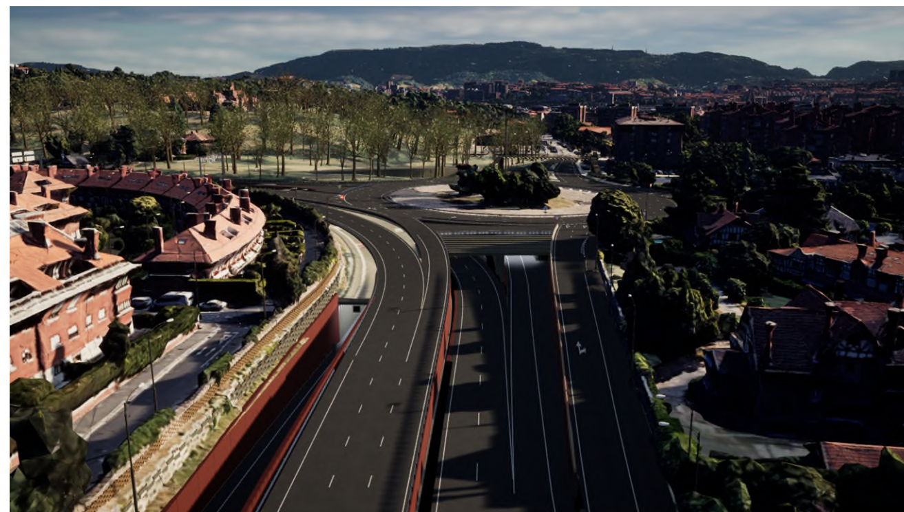
Figura 11: Vista desde Uribe Kosta
