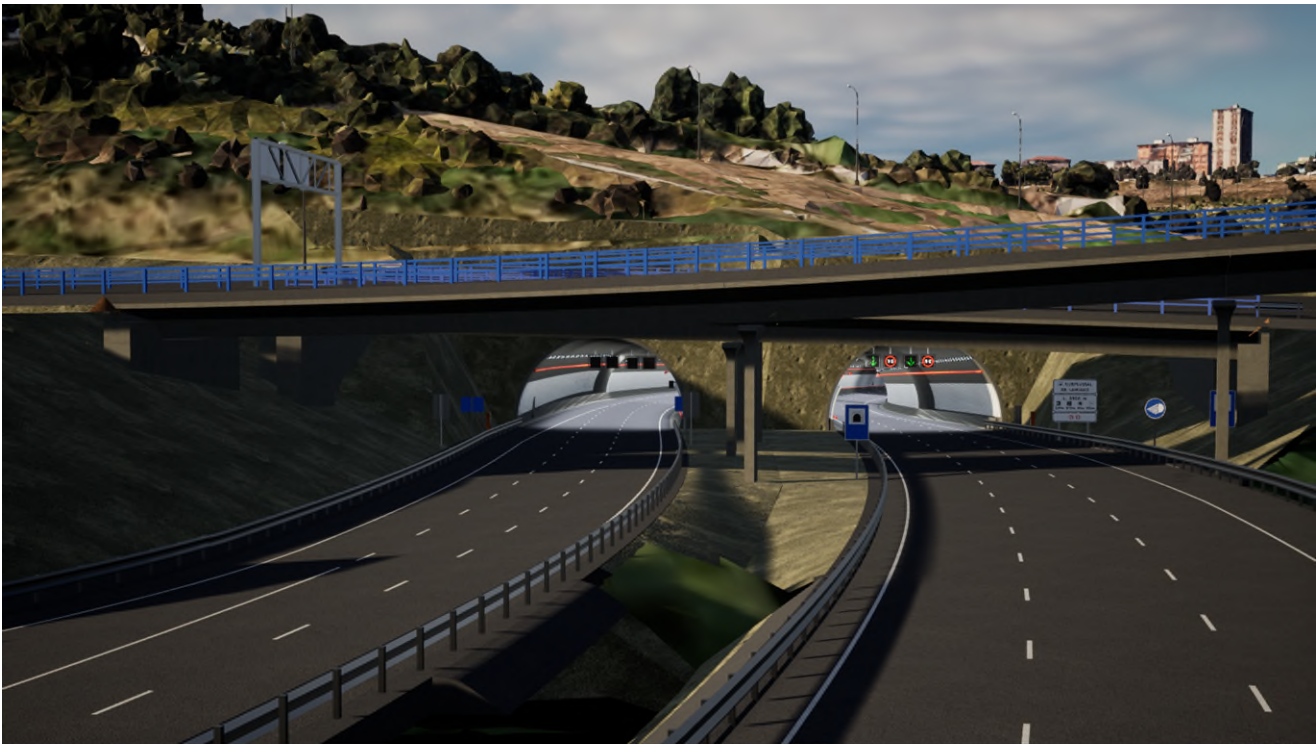
Figura 14: Emboquille de los túneles principales en la zona de Ballonti
