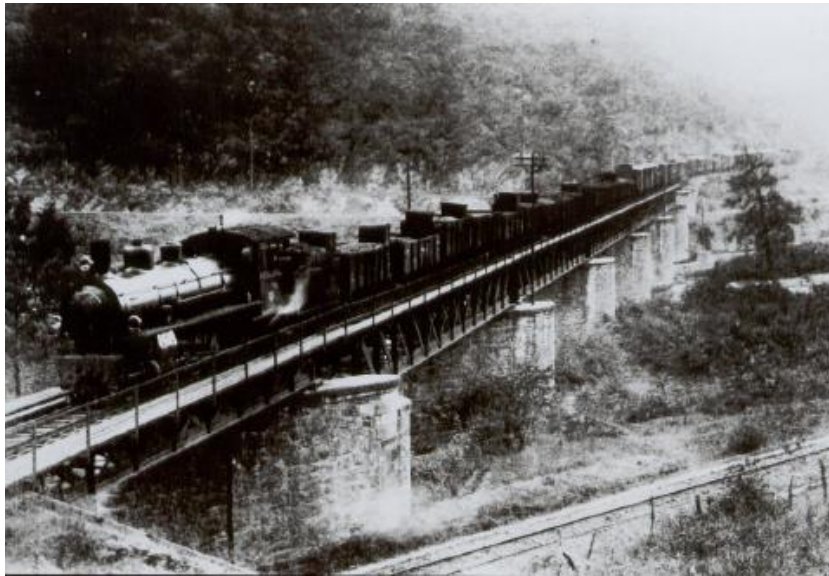
Imagen 4: Vista del antiguo puente.
