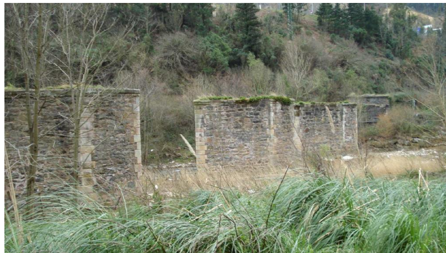
Imagen 5: Pilas existentes del antiguo puente de ferrocarril sobre el río Kadagua
