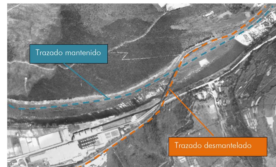
Imagen 3: Doble trazado ferroviario y antiguo puente sobre el Kadagua. Año 1956
