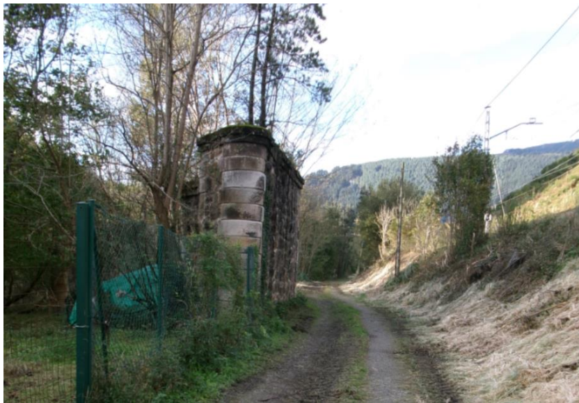
Imagen 8: Antigua pila y talud de la plataforma ferroviaria en servicio
