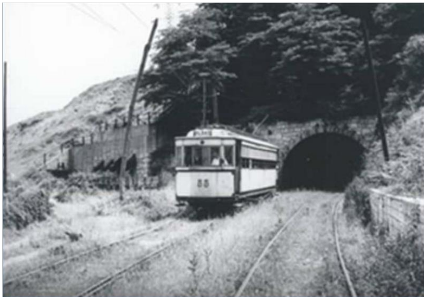
Imagen 5: Tranvía saliendo del túnel de El Boquete, en su boca sentido Bolueta
