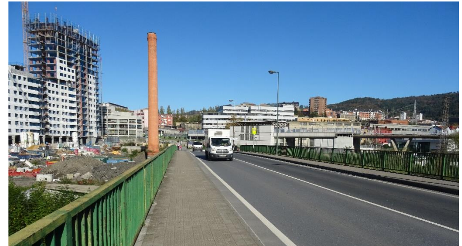
Imagen 12: Puente de Zubialde. Vista hacia Bolueta
