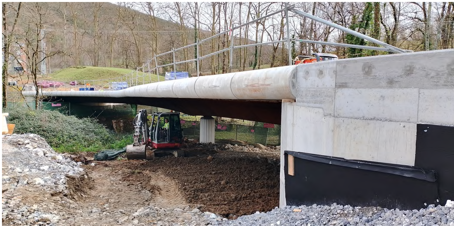
ACONDICIONAMIENTO BAJO ESTRUCTURA ETXEBERRIA
