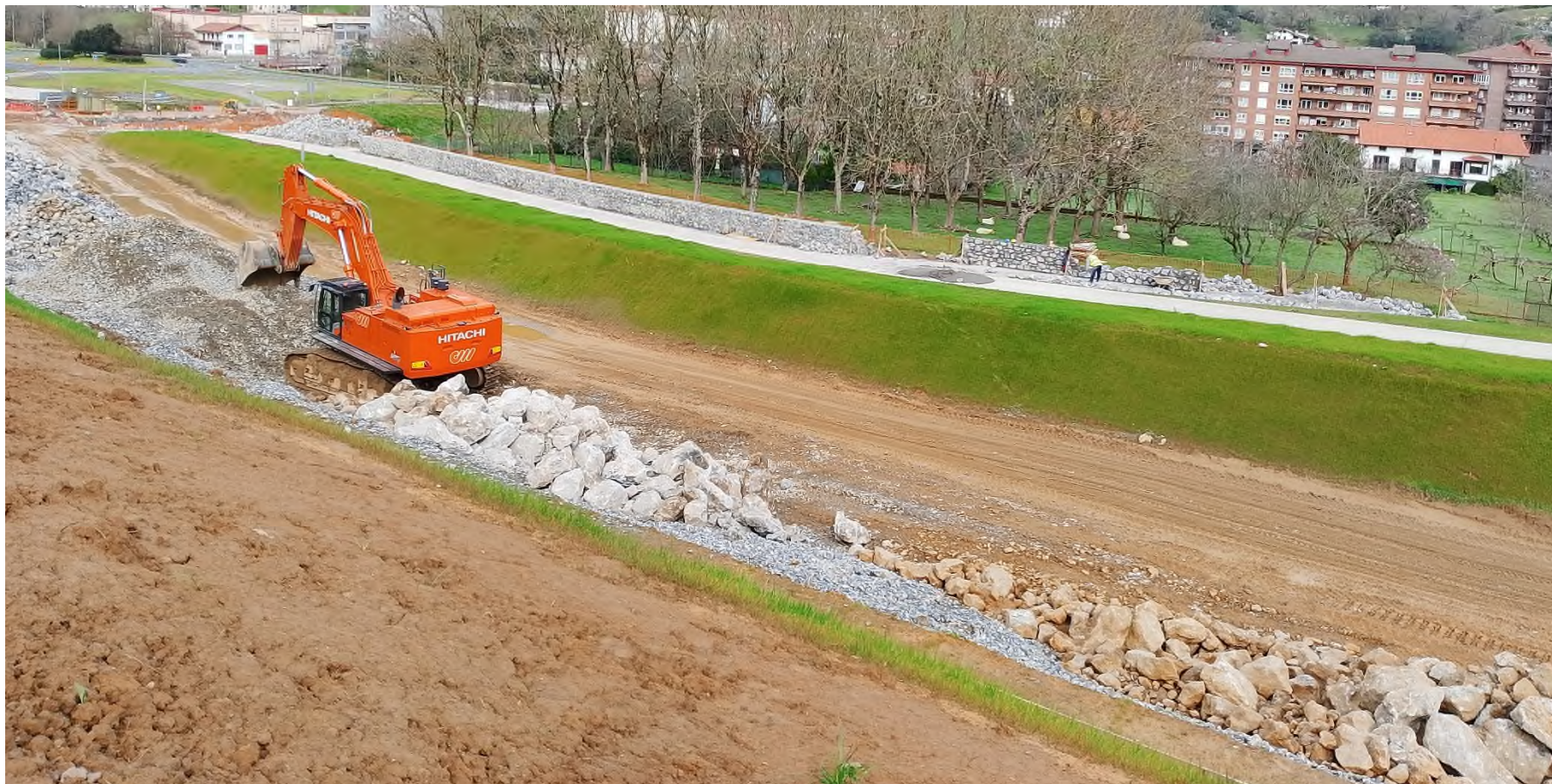
EJE-21 Y MURO MAMPOSTERIA EJE-19
