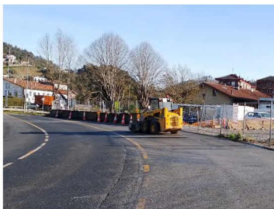
Foto nº29: Resguardo de la balsa mediante murete de hormigón
