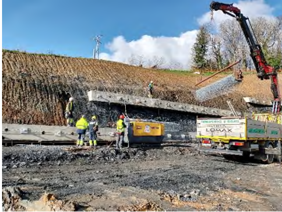
Foto nº5: Colocación mallas emboquille
