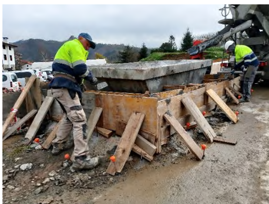
Foto nº26: Resguardo de la balsa mediante murete de hormigón
