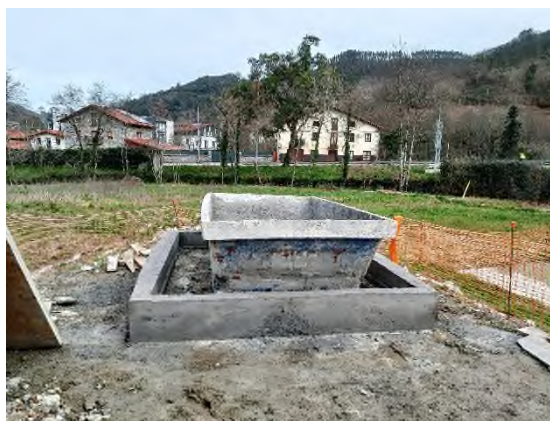
Foto nº25: Limpieza de canaletas en Markina
