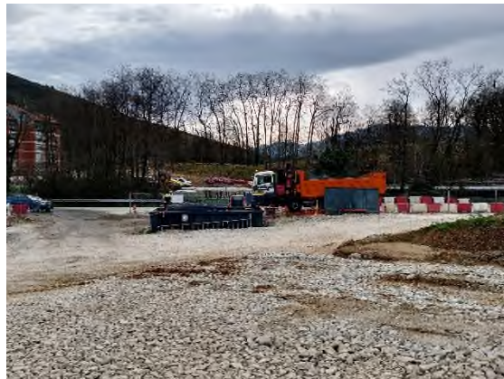
Foto nº23: Uso correcto del lavarruedas en la zona de Etxebarria
