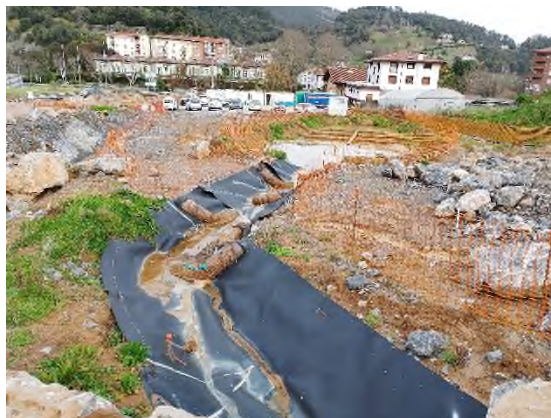
Foto nº19: Barreras habilitadas previo vertido a la balsa Eje-19
