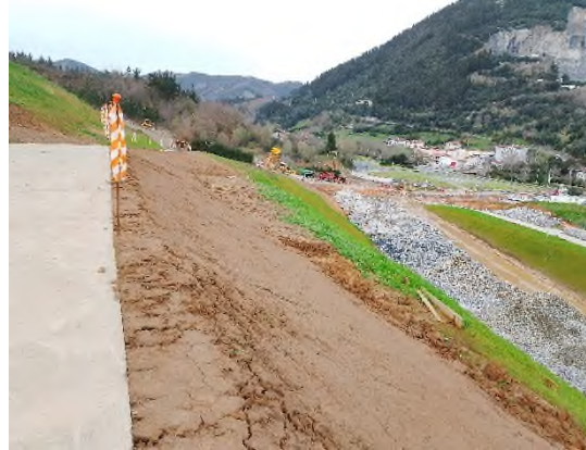
Foto nº4: Extendido de tierra vegetal eje-24
