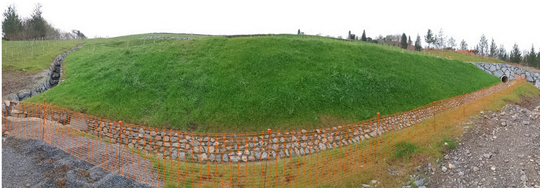
DIQUE DEPOSITO SOBRANTES
