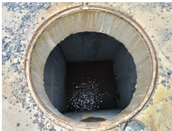
Foto nº35: Salida del dren de fondo
