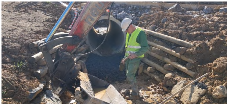
Foto nº34: Ejecución krainer ODTC-04.
