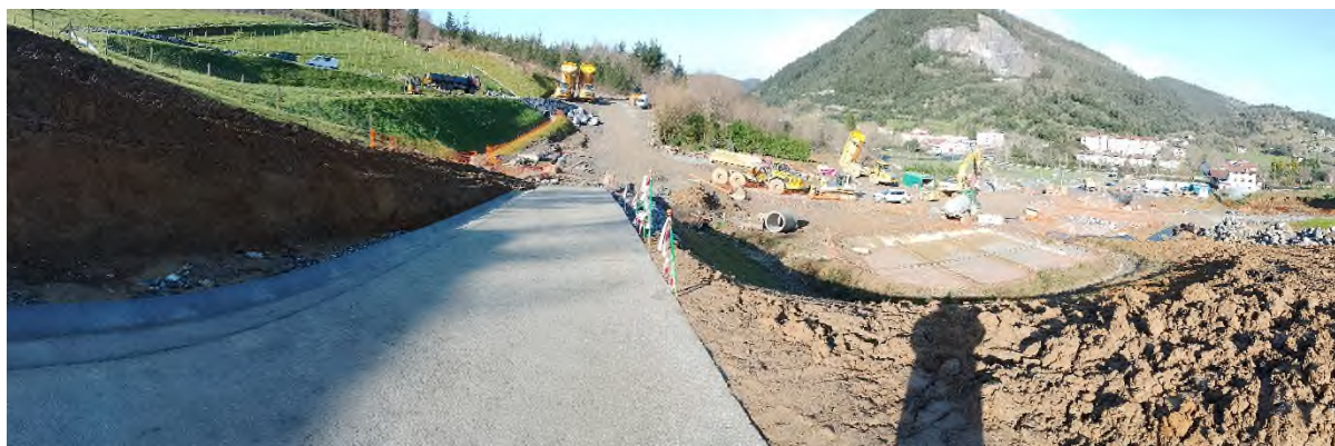
Foto nº37: Vista general de la situación de la balsa de decantación
