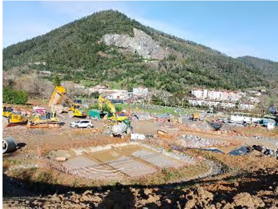
Foto nº20: Mantenimiento balsa del DS.
