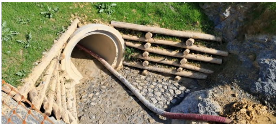
Foto nº33: Ejecución krainer ODTC-02.
