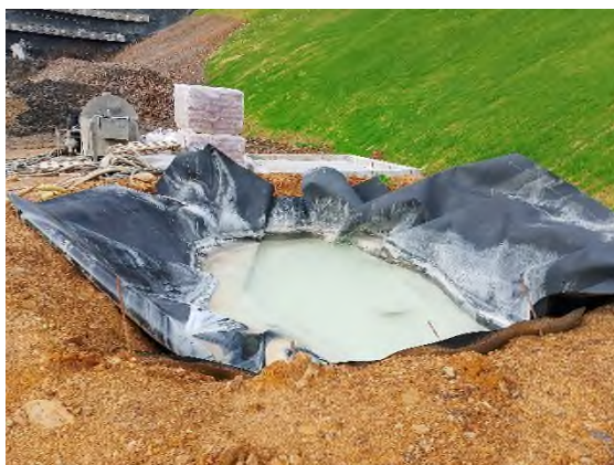
Foto nº24: Lavado de canaletas en Etxebarria
