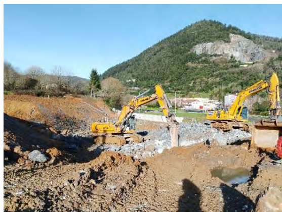
Foto nº1: Excavación en Eje-4
