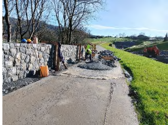
Foto nº6: Eje 19. Muro mampostería
