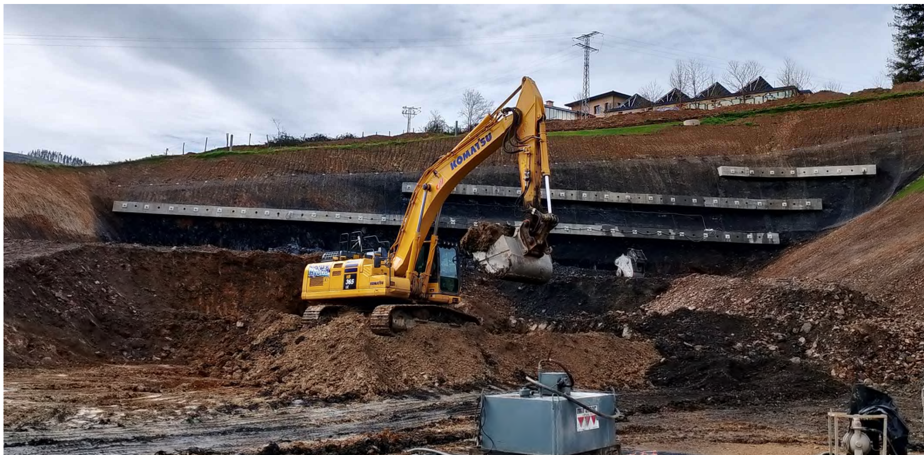
MOVIMIENTO TIERRAS EMBOQUILLE ETXEBARRIA
