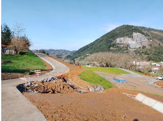
Foto nº3: Extendido de tierra vegetal eje-24. Pendiente restituir los Kraineres de la ODT-04 aguas arriba.
