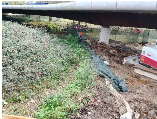
Foto nº32: Retirada malla opaca entorno a la regata Muniberreka.
