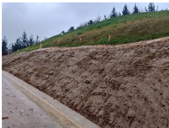
Foto nº3: Extendido de tierra vegetal eje-24
