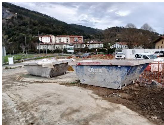
Foto nº25: Limpieza de canaletas en Markina
