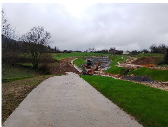
Foto nº5: Vista general emboquille lado Markina
