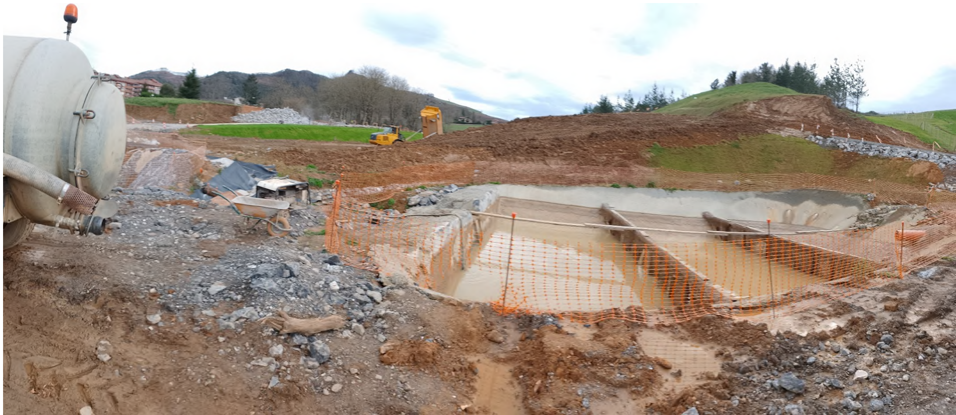
BALSA DECANTACIÓN DEL DEPÓSITO DE SOBRANTES
