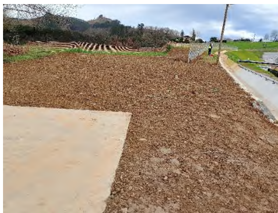
Foto nº4: Extendido de tierra vegetal eje-19
