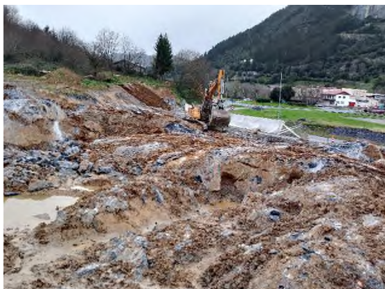
Foto nº1: Excavación en Eje-4
