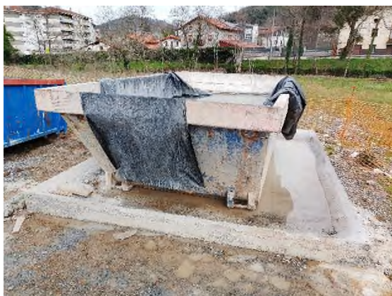
Foto nº24: Lavado de canaletas en Etxebarria
