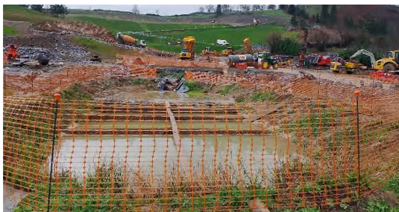
Foto nº34: Vista general de la zona baja del depósito conectada a las balsas de decantación
