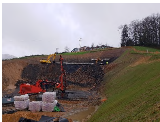
Foto nº7: Emboquille lado Etxebarria
