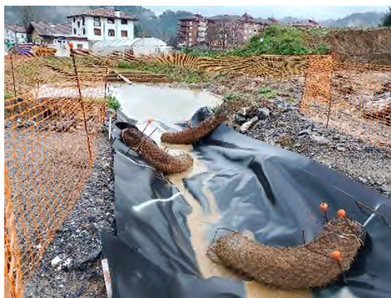
Foto nº20: Biorrollos habilitados en las cunetas
