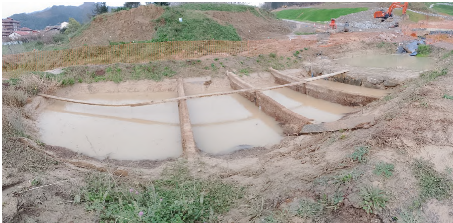
BALSA DE DECANTACIÓN EJE-19
