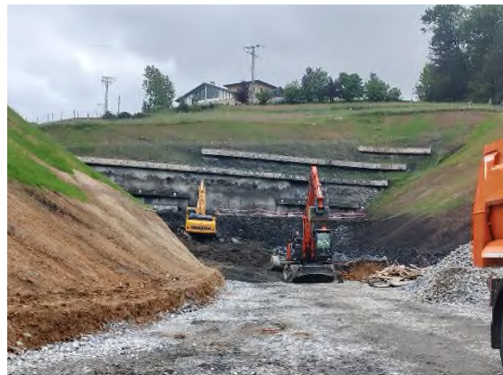
Foto nº4: Excavación Eje-21 Etxebarria.
