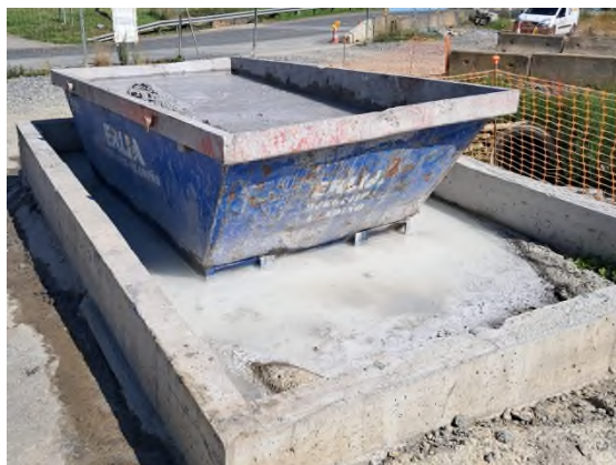
Foto nº7: Limpieza de canaletas en Markina
