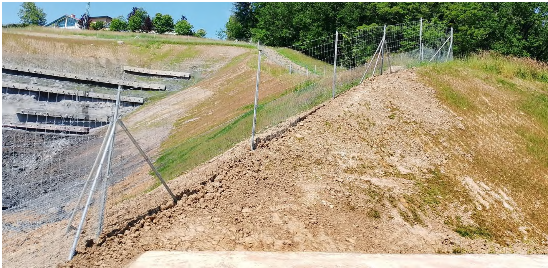
CERRAMIENTO EMBOQUILLE ETXEBARRIA
