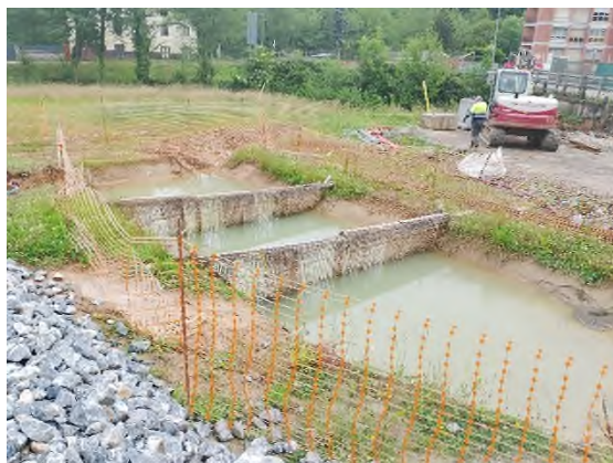
Foto nº1: Balsa decantación Etxebarria
