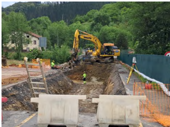
Foto nº3: Excavación estribos Etxebarria
