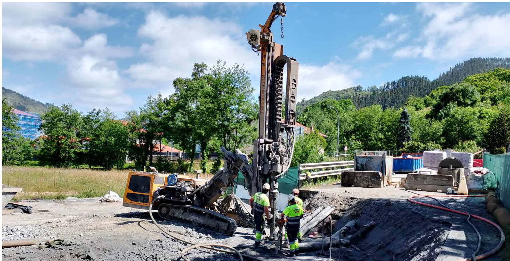
MICROPILOTES ESTRUCTURAS ETXEBERRIA
