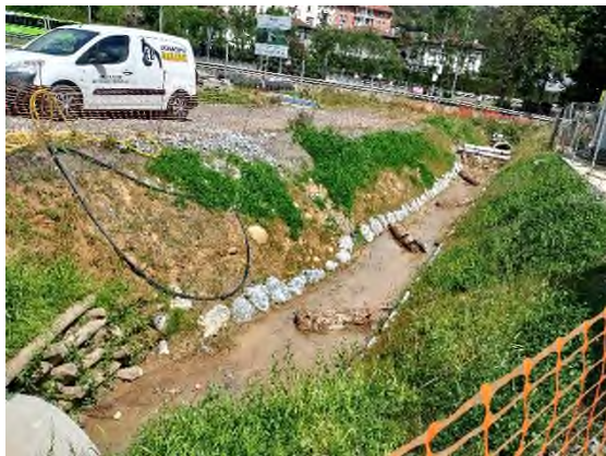
Foto nº11: Biorrollos en ODTC-02
