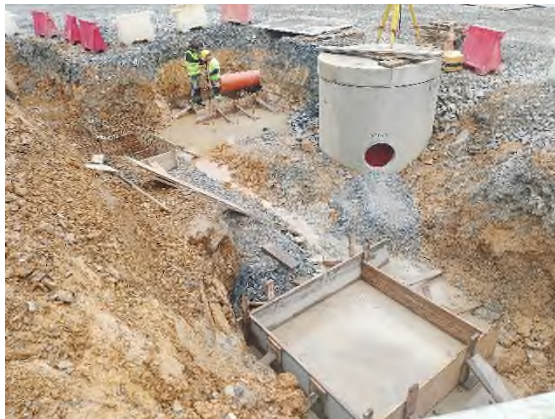
Foto nº7: montaje SH-2, colectores y arquetas
