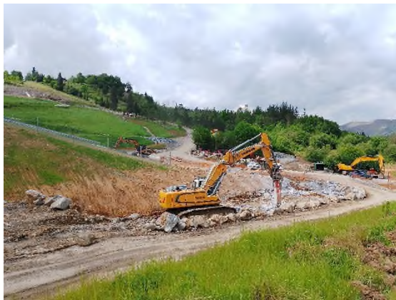
Foto nº1: Excavación eje-19 Markina
