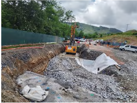
Foto nº8: Balsa junto a la zona de actuación
