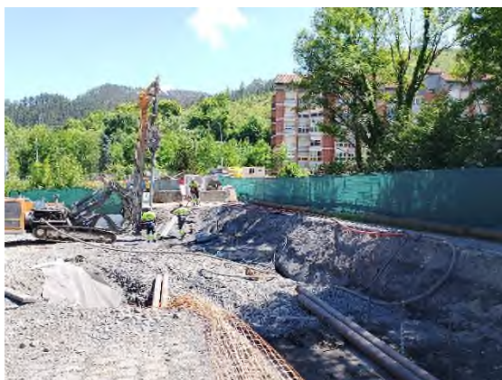
Foto nº15: Valla opaca zona antiguo vial
