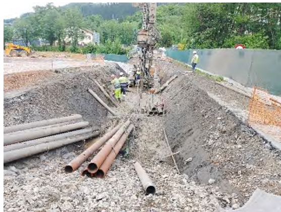
Foto nº8: Eje 21. Micropilotaje E-2 y E-3 Etxebarria
