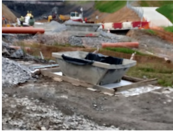
Foto nº9: Limpieza de canaletas de los estribos
