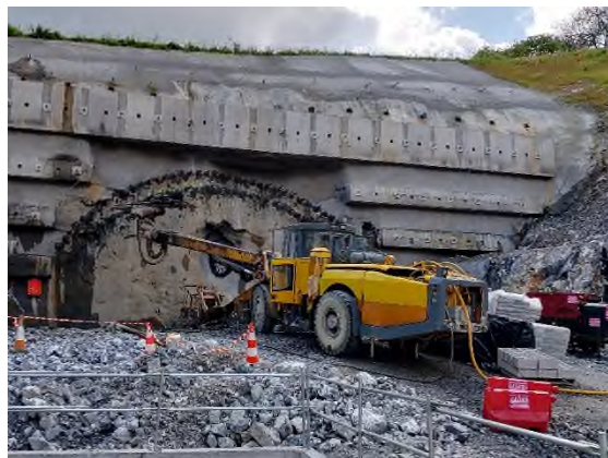
Foto nº10: Labores emboquille túnel
