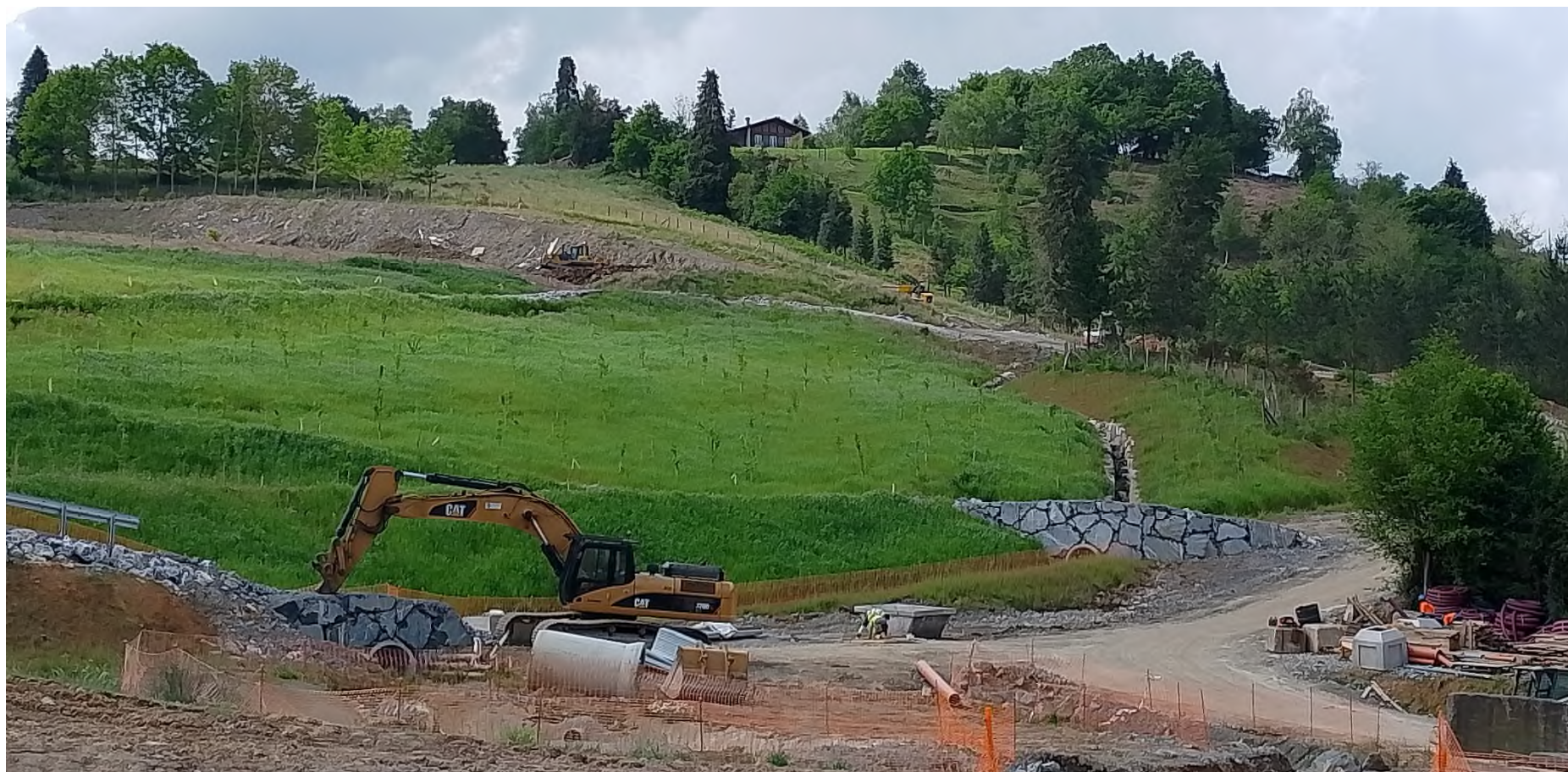
DEPOSITO DE SOBRANTES
