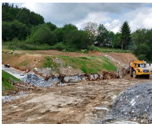
Foto nº5: Extendido de tierra vegetal ODT-C01
