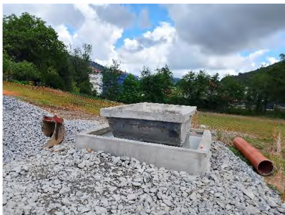
Foto nº6: Lavado de canaletas en Etxebarria
