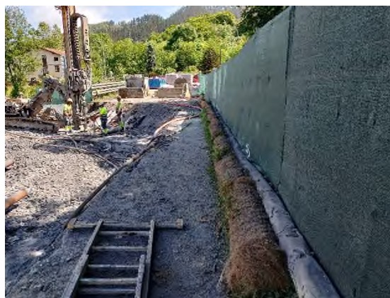
Foto nº16: Valla opaca, biorrollos y geotextil zona antiguo vial.
