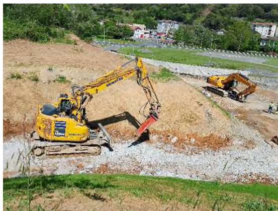
Foto n°1: Excavación zona rotonda Markina
