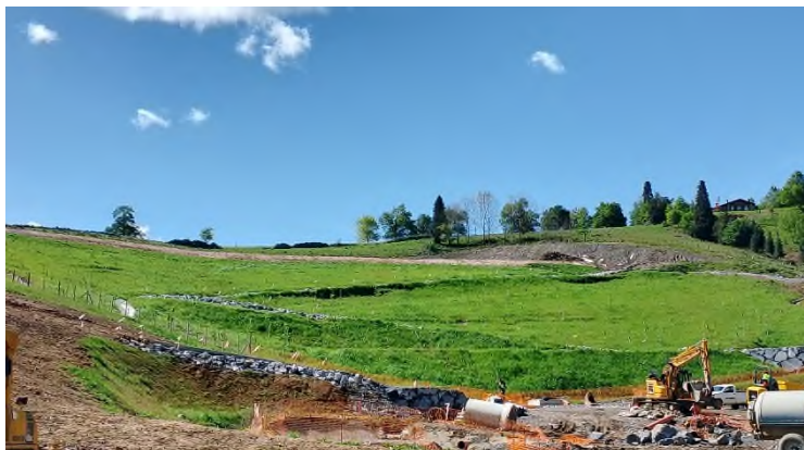
Foto n°26: Vista general DS
