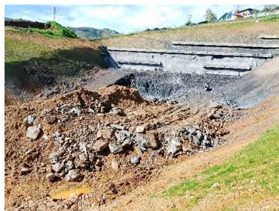
Foto nº9: Zona Balsa de limpieza en Etxebarria desmantelada
