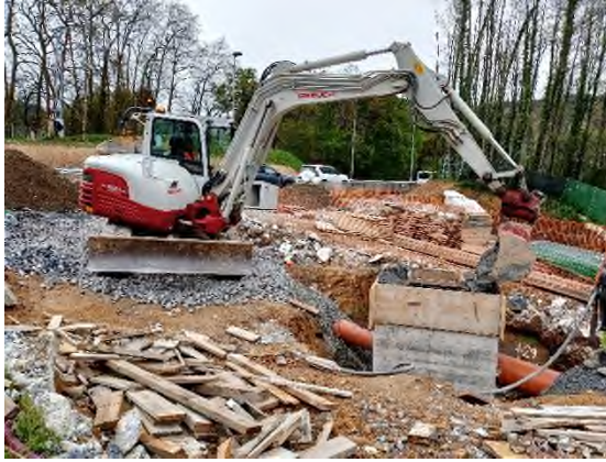
Foto n°5: Servicios en estructura-1
