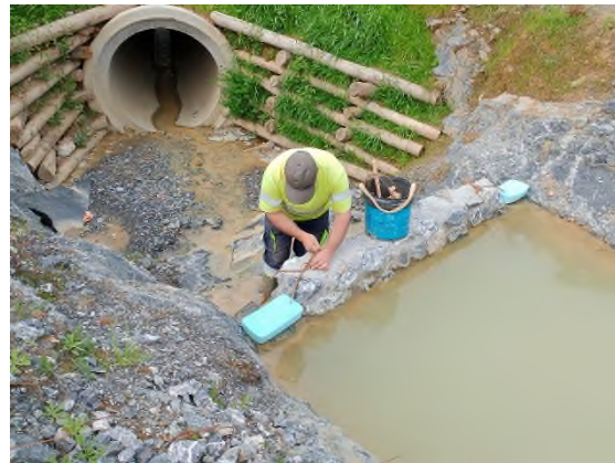
Foto nº13: instalación pastillas floculantes en represa de la ODTC-02
