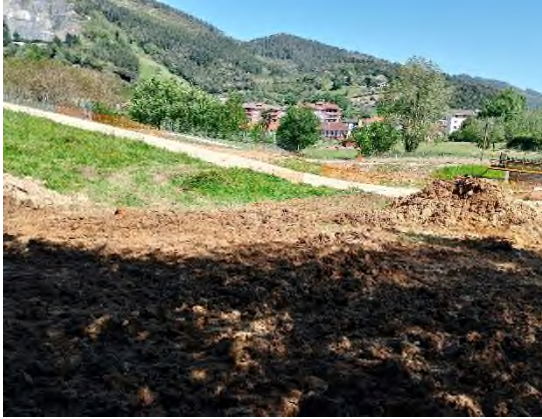
Foto nº3: Extendido de tierra vegetal Eje 24
