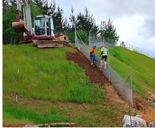
Foto nº4: Extendido de TV cerramiento
