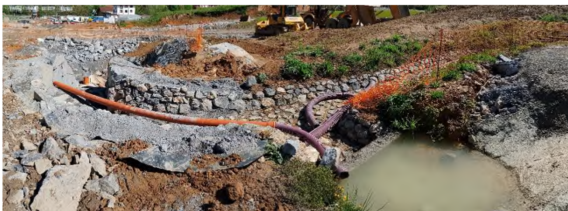
Foto nº23: Canalización de las aguas hacia la ODTC-02
