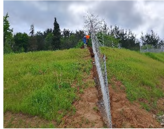
Foto n°6: Eje 21. Cerramiento Markina
