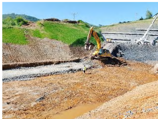
Foto n°2: Excavación Eje-21 Etxeberria
