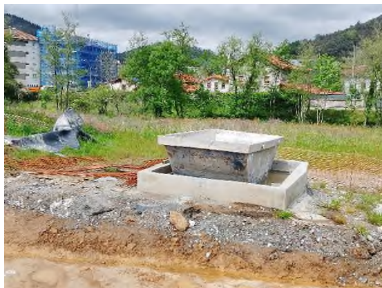
Foto nº6: Lavado de canaletas en Etxeberria
