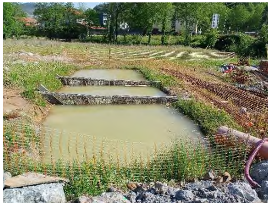
Foto n°1: Balsa decantación Etxebarria
