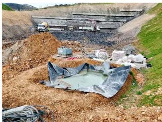
Foto nº8: Punto de acopio aislado hidráulicamente en Etxebarria
