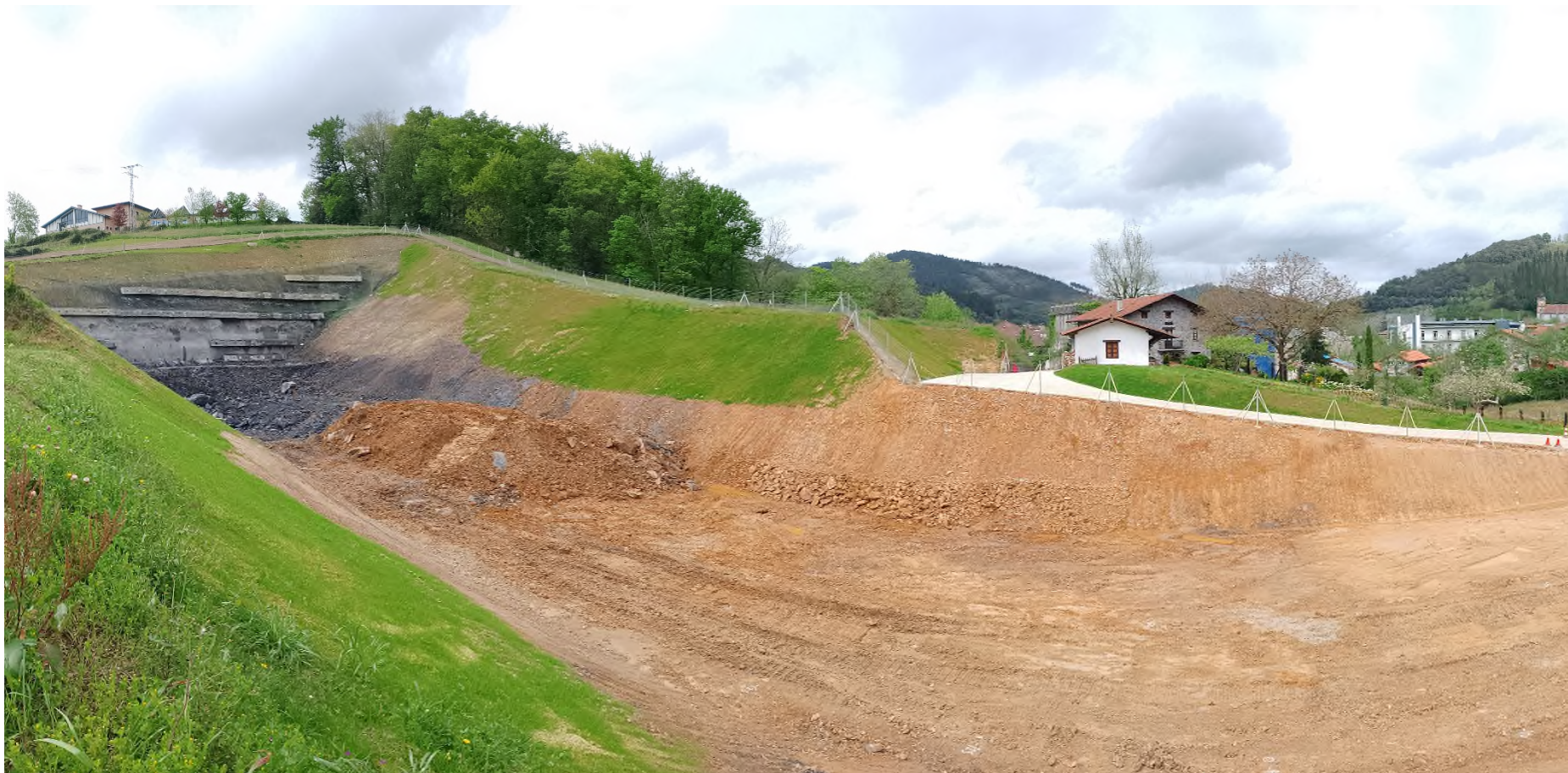
EMBOQUILLE ETXEBERRIA TRAS EXCAVACION
