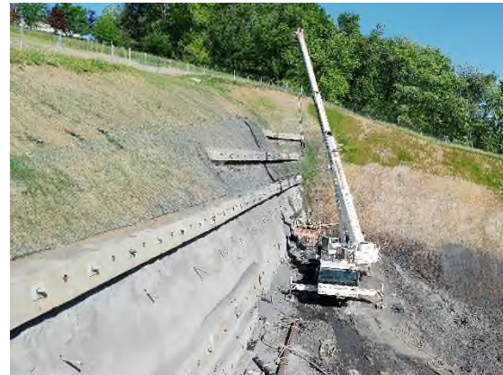
Foto n°8: Eje 21. Sostenimiento Etxeberria
