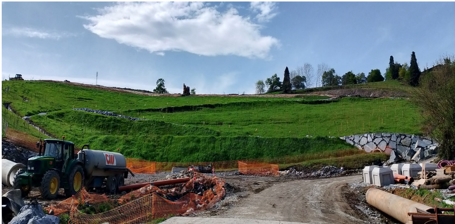
DEPOSITO DE SOBANTES
