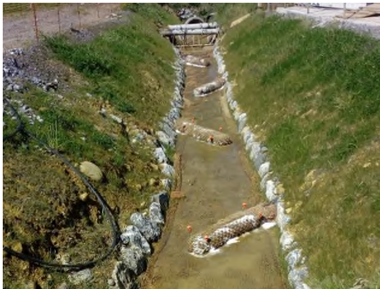
Foto nº12: Biorrollos en ODTC-02
