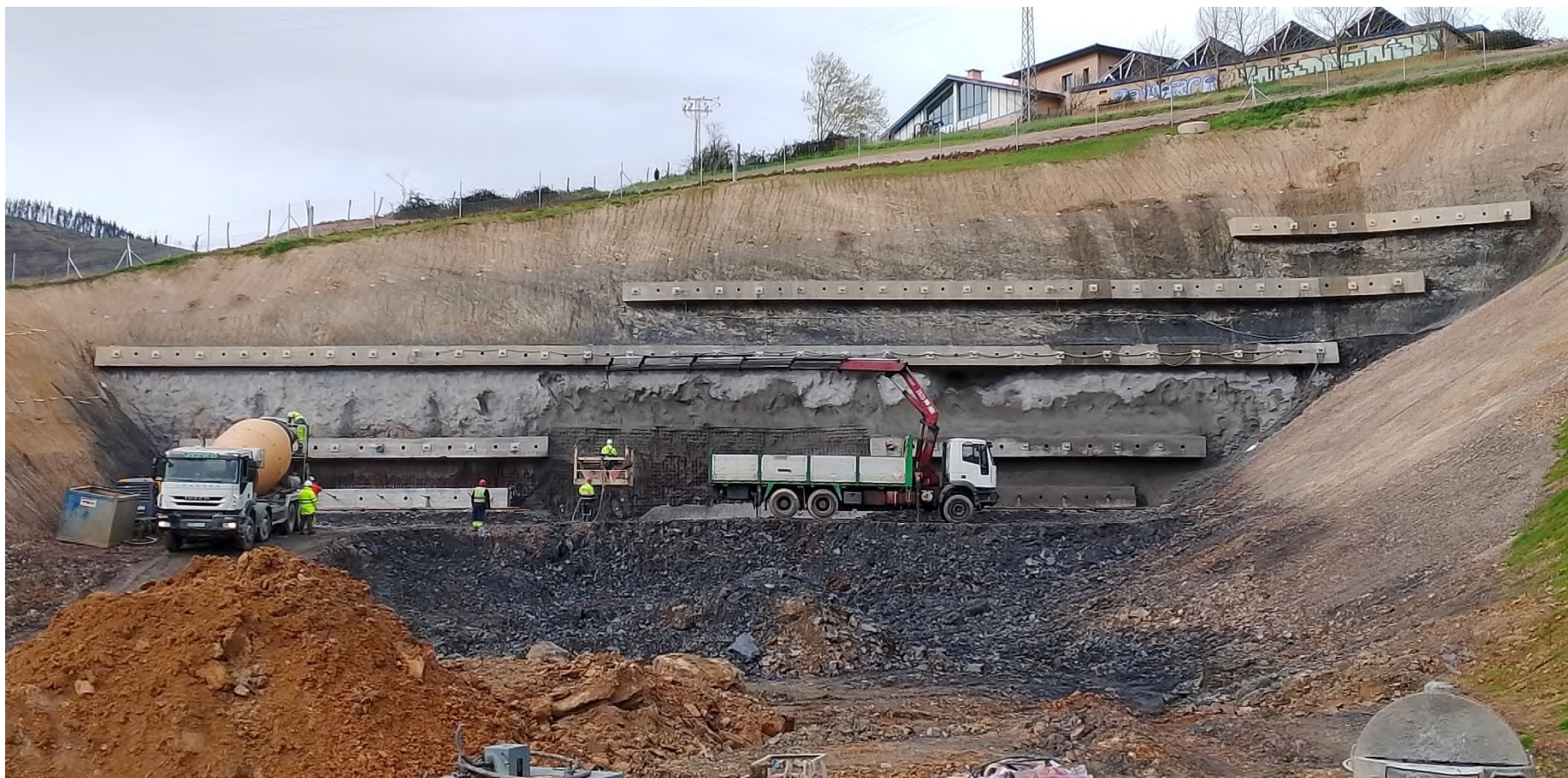
SOSTENIMIENTO EMBOQUILLE ETXEBARRIA
