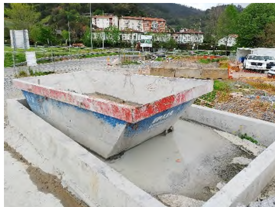
Foto nº7: Limpieza de canaletas en Markina
