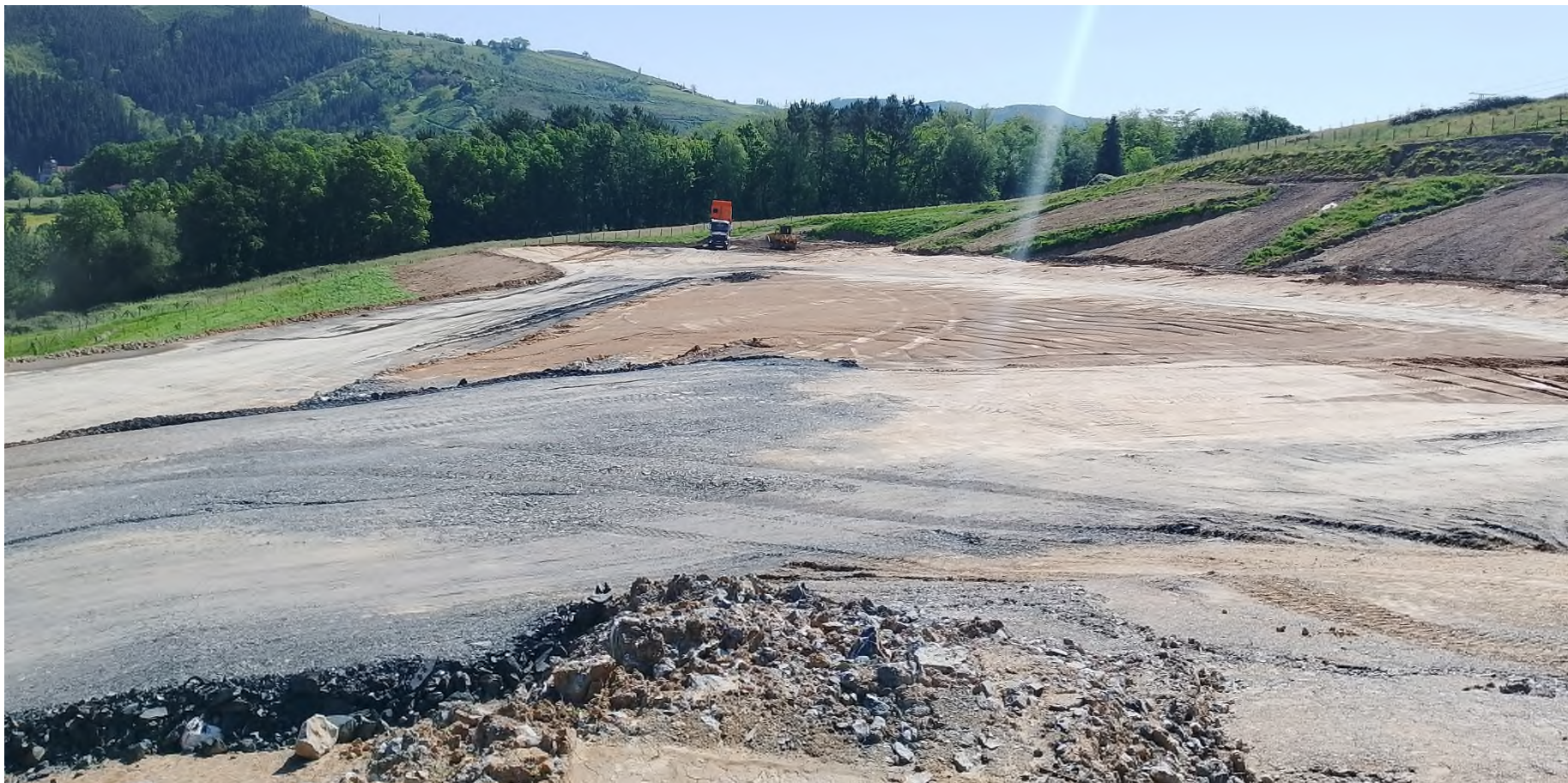
EXPLANADA RELLENO DEPOSITO DE SOBRANTES
