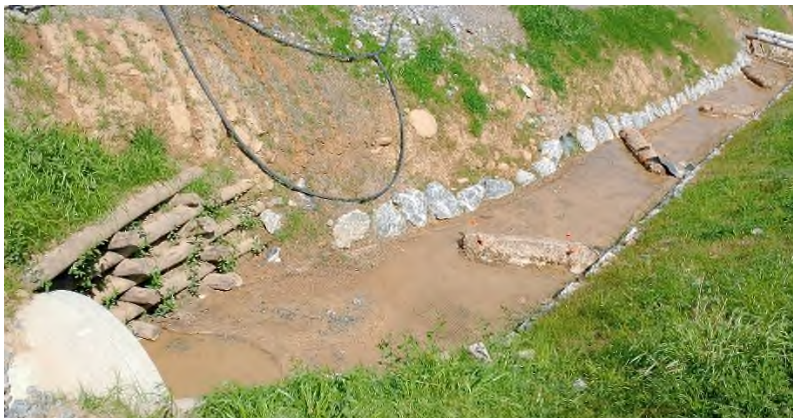
Foto n°25: Biorollos en el cauce de la ODTC-02
