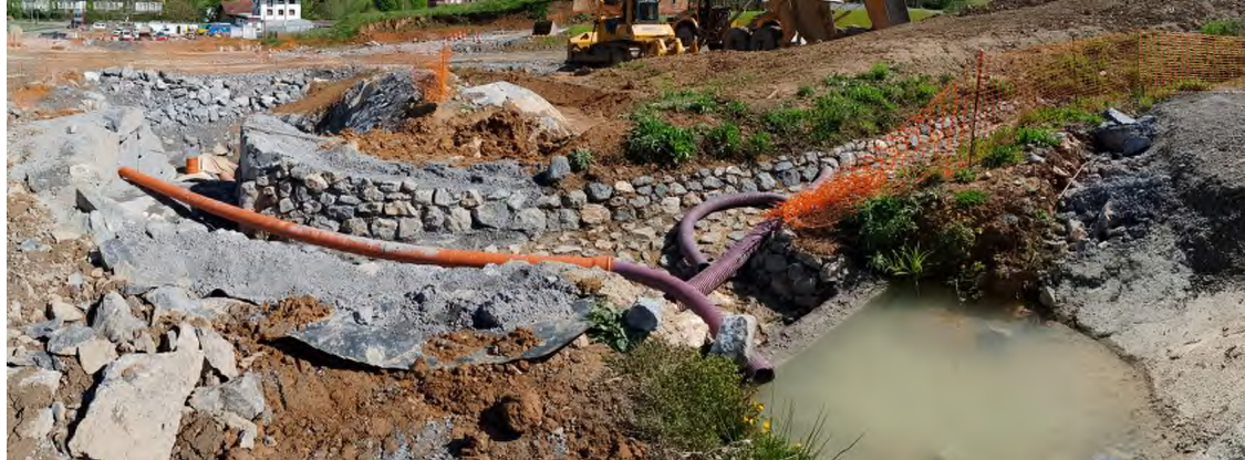
Foto nº3: Conducción de la balsa de decantación hacia la ODT-02
