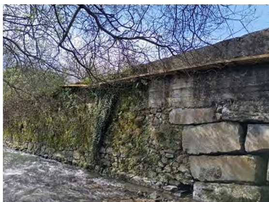
Foto nº47: Balda de madera aguas abajo en el margen derecho.
