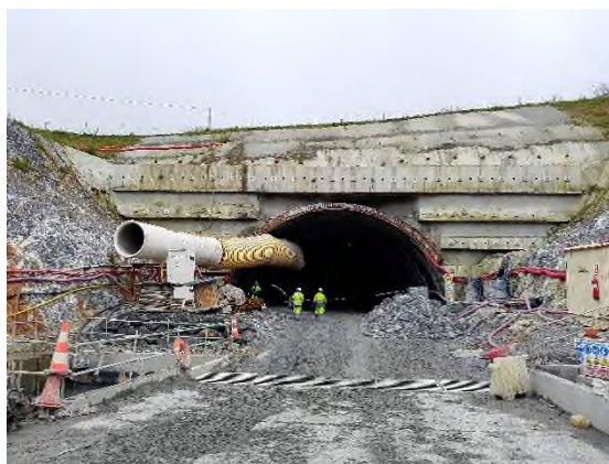
Foto nº2: Emboquille de túnel en la boca oeste
