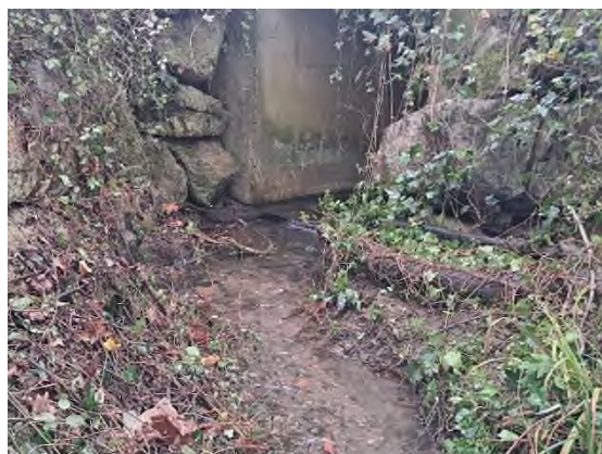
Foto nº34: Emboquille tras el desbroce realizado.
