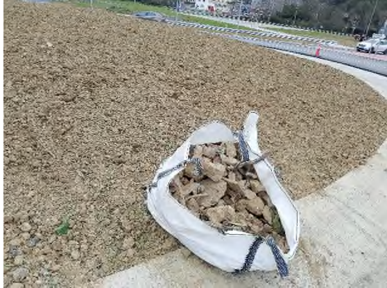
Foto nº9: Despedregado de la zona de la rotonda de Markina.
