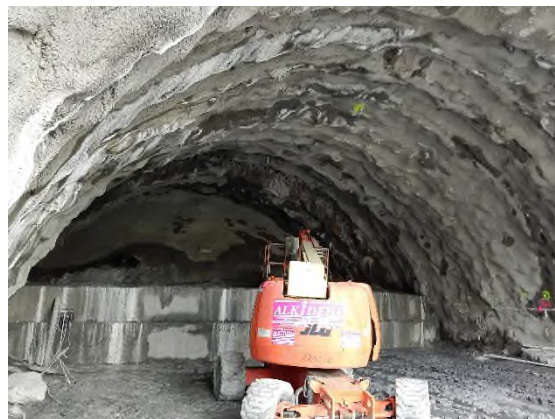
Foto nº23: Labores de estabilización en Etxebarria.
