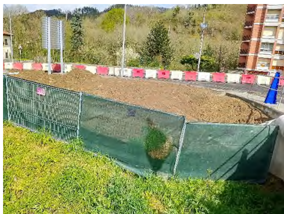
Foto nº23: Detalle vallado opaco acondicionado entorno al E-3
