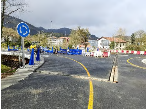
Foto nº19: Juntas dilatación y vallado E2 y E3
