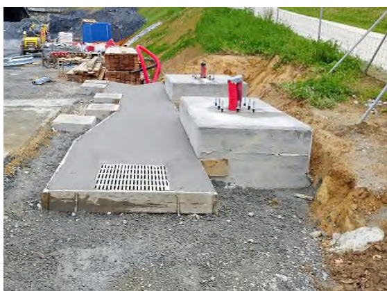
Foto nº17: Cunetas y señalización en el eje-21 Etxebarria
