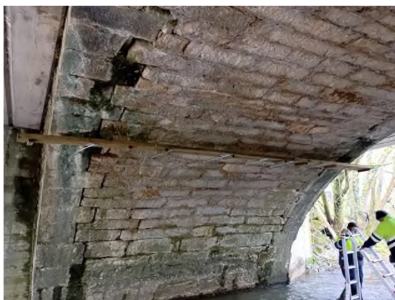
Foto nº43: Operarios instalando balda de madera en el túnel margen izquierda.
