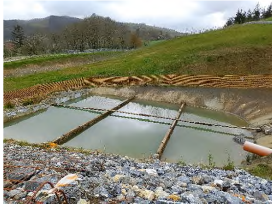
Foto nº3: Balsa de decantación del DS
