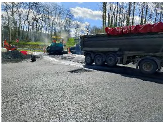
Foto nº15: Estructura-3 y accesos, asfaltado.
