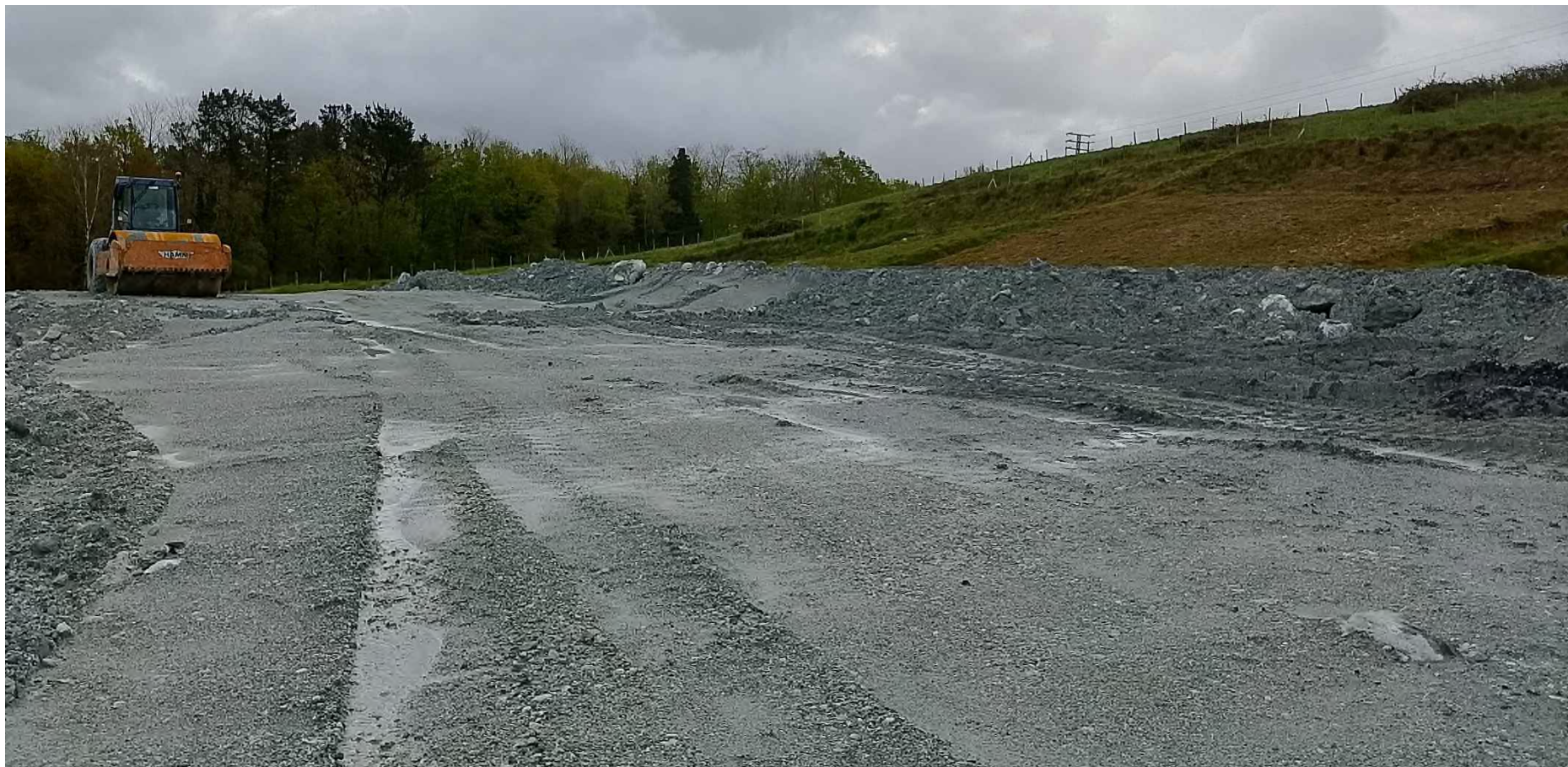
EXPLANADA DEPOSITO DE SOBRANTES
