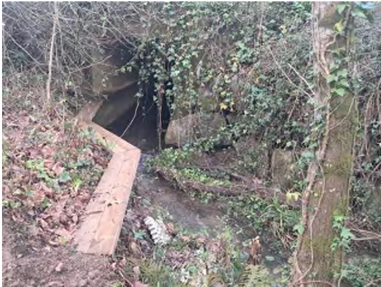
Foto nº37: Balda acondicionada en la galería aguas abajo de la galería.
