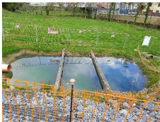
Foto nº33: Balsa de decantación Atain
