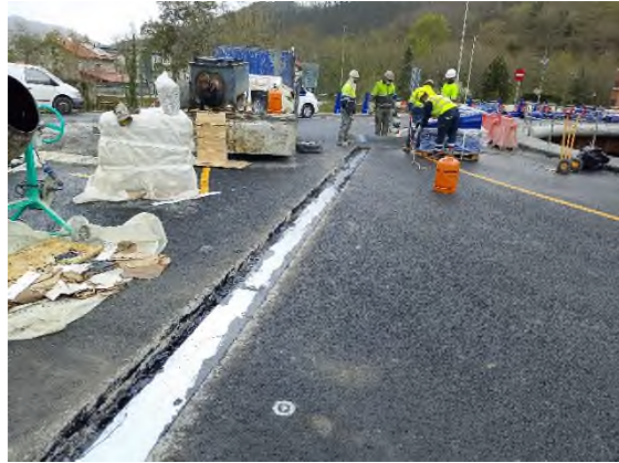
Foto nº20: Impermeabilización E-3 Etxebarria.
