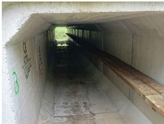
Foto nº41: Balda acondicionada en el interior de la ODT.
