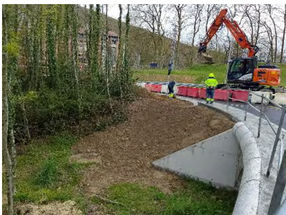
Foto nº7: TV en la parte interior de la rotonda del estribo_2.
