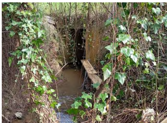
Foto nº35: Instalación de balda de madera aguas arriba de la galería
