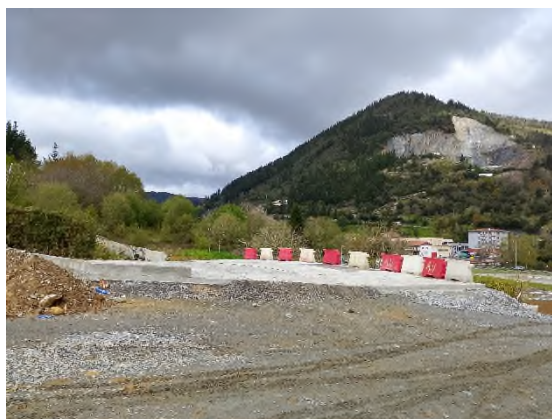
Foto nº16: Eje 30: plataforma transferencia materiales excavación externos a obra
