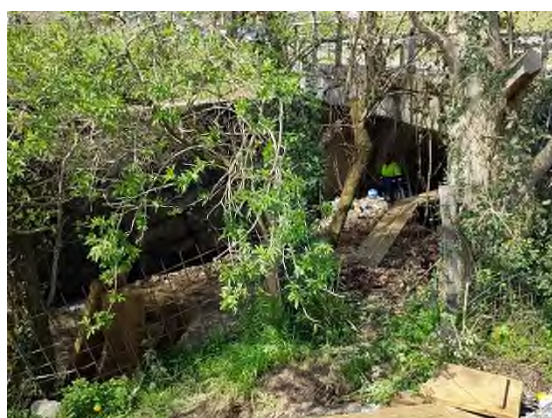
Foto nº48: Salida de la balda a la campa en el margen izquierdo.
