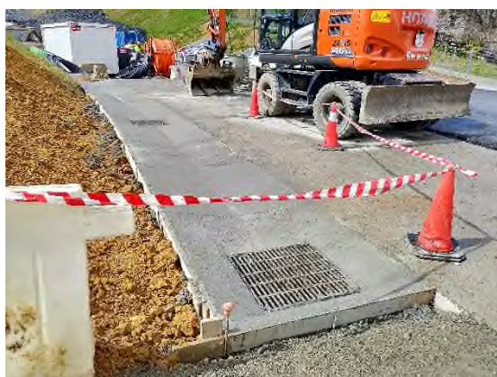
Foto nº18: Eje-21 Etxebarria, cunetas
