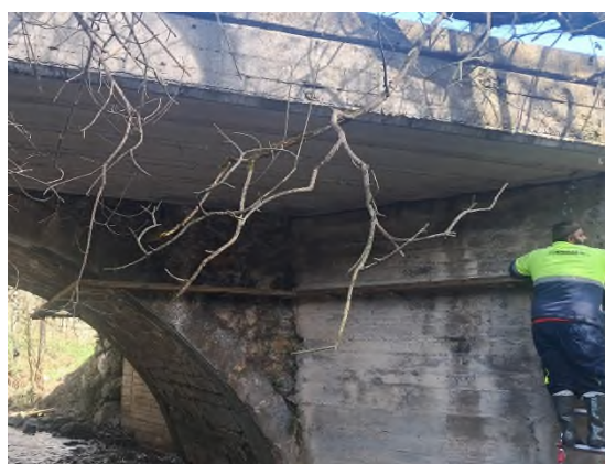
Foto nº44: Balda de madera en el margen izquierdo aguas abajo.
