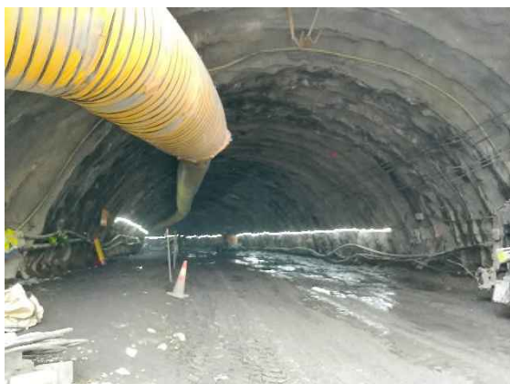
Foto nº1: Excavación de túnel en la boca oeste
