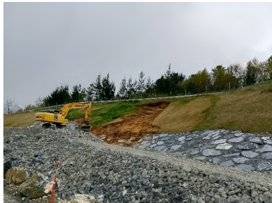
Foto nº22: Eje-21 piel de escollera.
