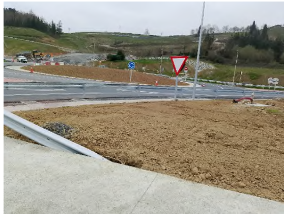
Foto nº12: Vista general de la rotonda desde el helipuerto.
