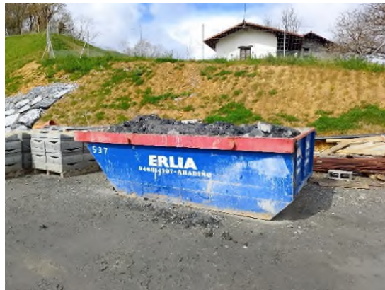
Foto nº22: Contenedores de Asfalto en Etxebarria
