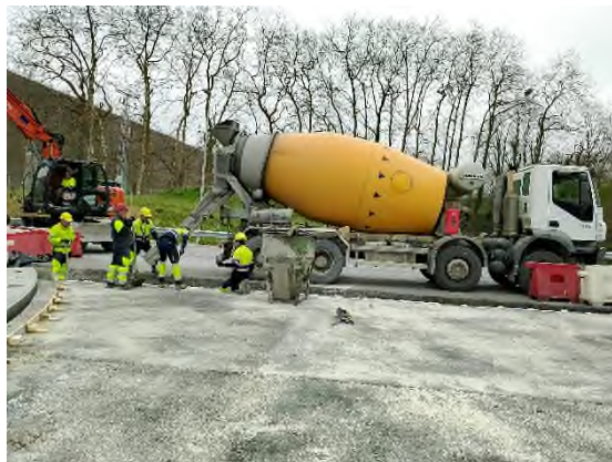
Foto nº14: Hormigonado en zona estructura-2
