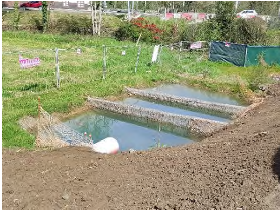
Foto nº2: Balsa decantación Etxebarria
