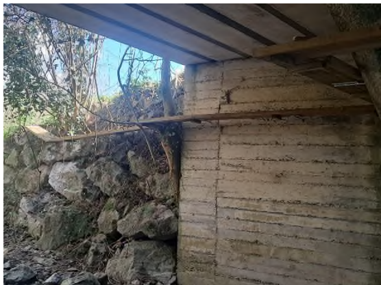
Foto nº45: Balda de madera en el túnel margen izquierda, aguas arriba.
