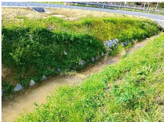
Foto nº15: Biorrollos en ODTC-02
