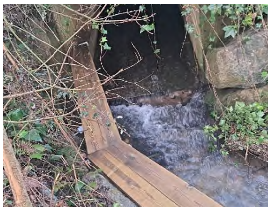
Foto nº36: Instalación de balda de madera aguas arriba de la galería
