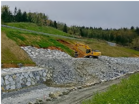
Foto nº21: Recrecido escollera eje-21 Markina
