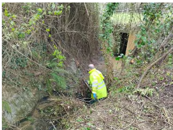
Foto nº33: Personal realizando desbroce en el emboquille de la ODT
