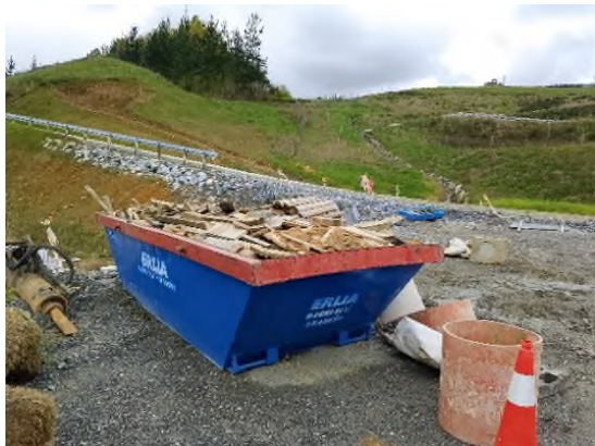
Foto nº21: Contenedor madera entre en eje-30 y eje-24
