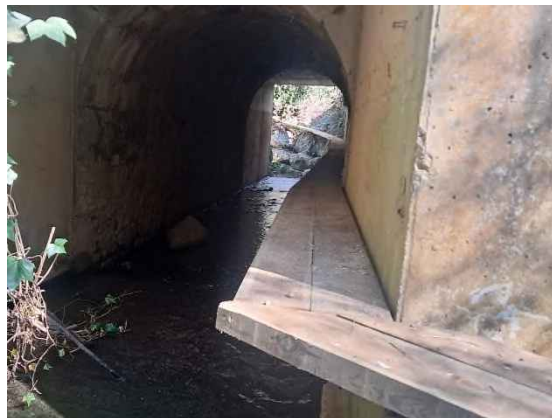
Foto nº38: Detalle de la balda de madera instalada en el interior de la galería.
