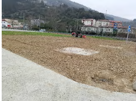
Foto nº10: Laboreo mediante medios mecanicos de la zona del helipuerto
