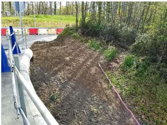
Foto nº5: TV en la parte interior de la rotonda del estribo_3.
