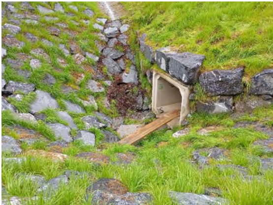
Foto nº39: Balda acondicionada aguas arriba de la galería
