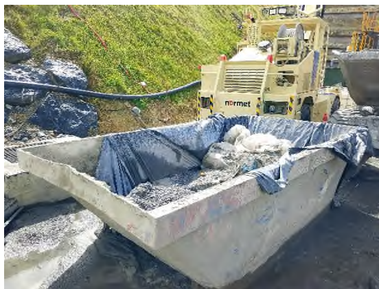
Foto nº9: Limpieza de canaletas en S-5
