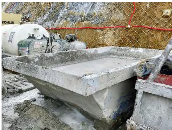
Foto nº8: Limpieza de canaletas en S4
