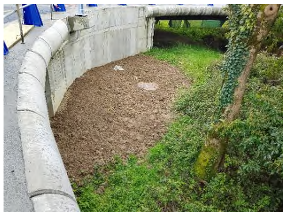
Foto nº8: Aporte de TV entre el estribo_1 y estribo_2.
