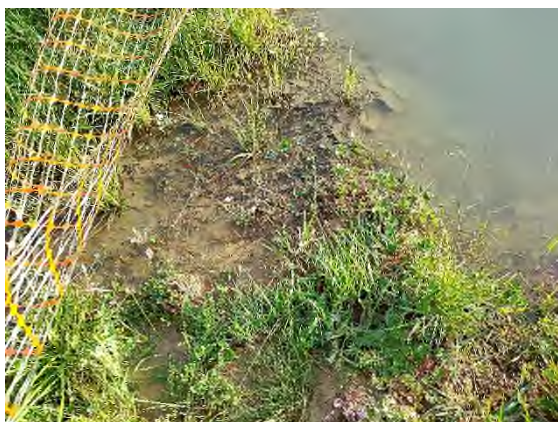
Foto nº32: Zona de vertido de la balsa de Atain
