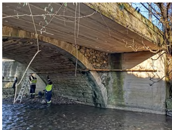
Foto nº46: Instalación de balda de madera en el margen derecho.
