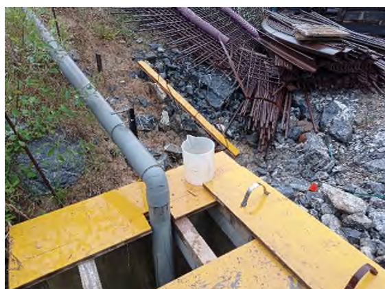
Foto nº12: Vertido depuradora de Markina
