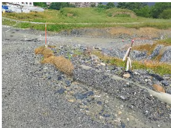
Foto nº25: Balas de Yute acondicionadas en la cuesta hacia el DS
