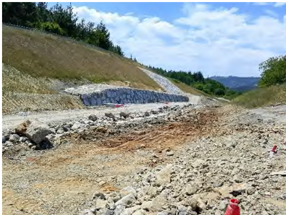
Foto nº3: Eje 21 rasante calzada izquierda
