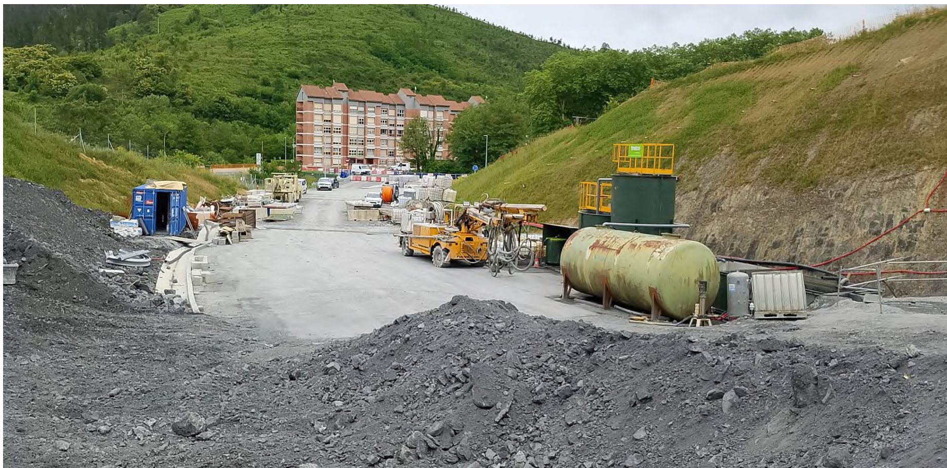
ZONA AUXILIAR ETXEBARRIA – S5
