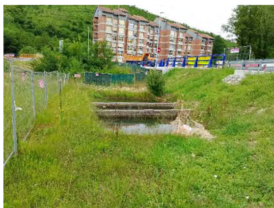
Foto nº27: Balsa decantación Etxebarria
