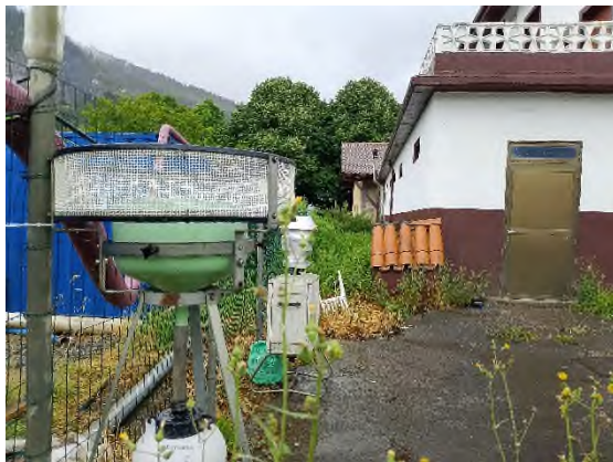
Foto nº20: Equipos en la Rotonda de Markina.
