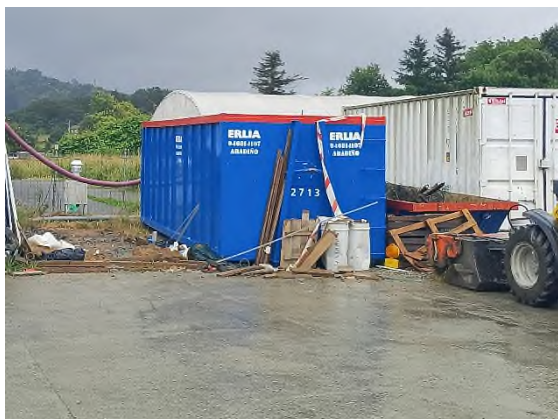
Foto nº41: Contenedores de RNPs habilitados zona casetas de obra Markina.
