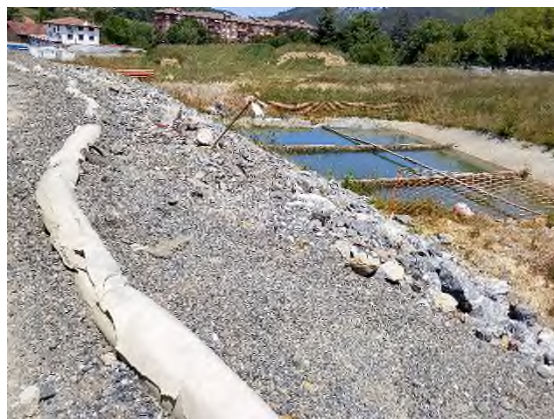
Foto nº26: Barrera de geotextil en el eje 30
