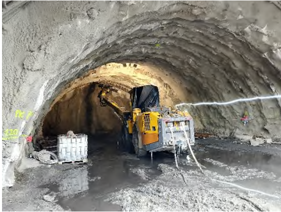
Foto nº1: Trabajos estabilización boca este.
