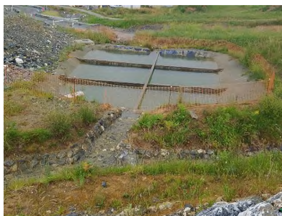
Foto nº28: Balsa de decantación del DS
