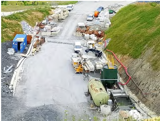
Foto nº37: Instalaciones auxiliares S5
