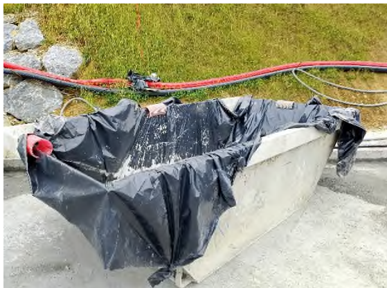
Foto nº33: Contenedor en S4 para la limpieza de canaletas.
