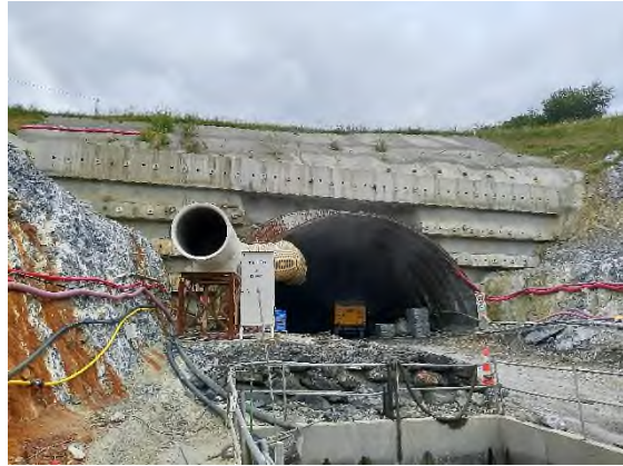
Foto nº2: Perforación en el túnel de Markina.
