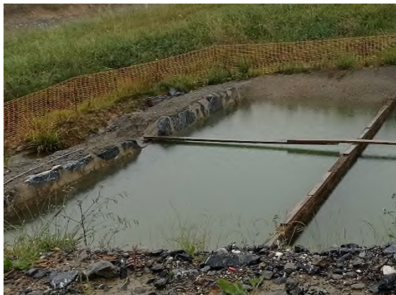
Foto nº14: Zona de vertido de la balsa del DS
