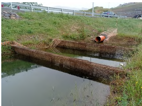
Foto nº16: Balsa de decantación Atain
