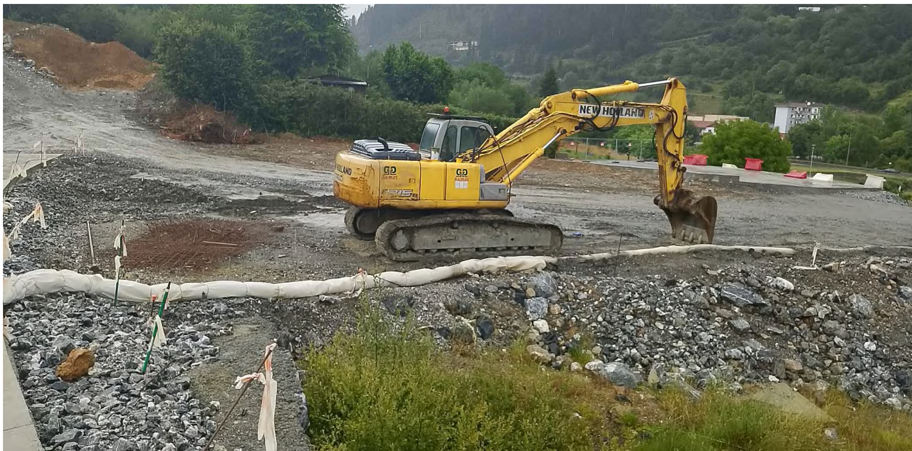
ZONA DE ACOPIO DE MATERIAL DE GAIMAZ PREVIO A LA SUBIDA AL DEPOSITO Y BARRERAS DE RETENCIÓN INSTALADAS
