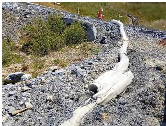
Foto nº46: Barreras habilitadas al pie del depósito
