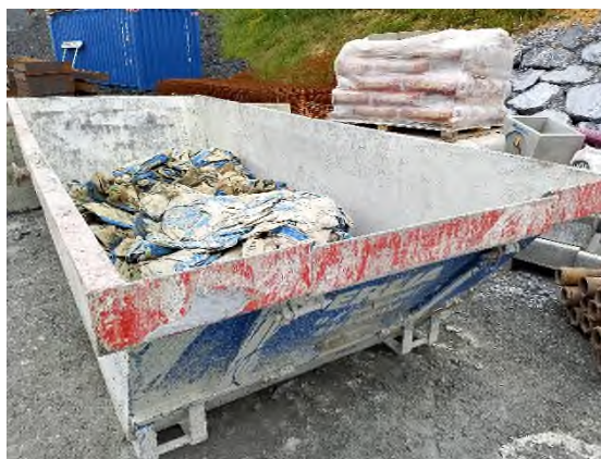
Foto nº40: Contenedor de restos de sacas de hormigón en S5, Etxebarria
