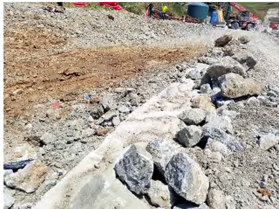
Foto nº4: Eje 21: dren y colector
