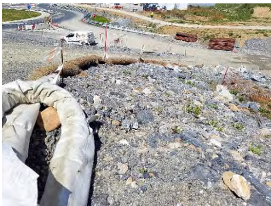
Foto nº28: Balas de Yute acondicionadas en la cuesta hacia el DS
