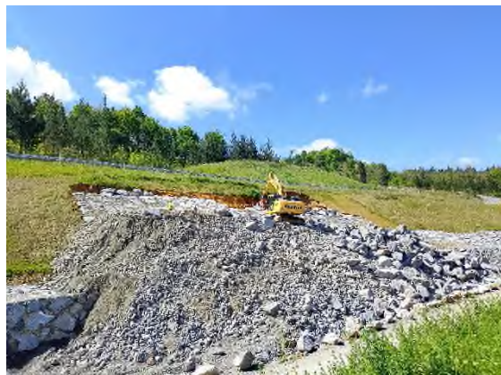
Foto nº12: Eje-21 piel de escollera.
