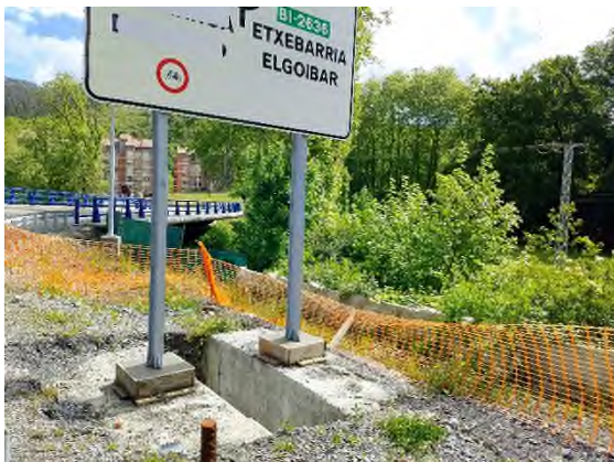
Foto nº7: Accesos a Etxebarria, señalización.
