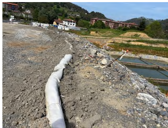
Foto nº29: Barrera de geotextil en el eje 30
