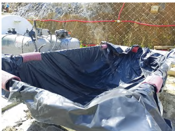
Foto nº39: Reposición de contenedor en S4 para la limpieza de canaletas.
