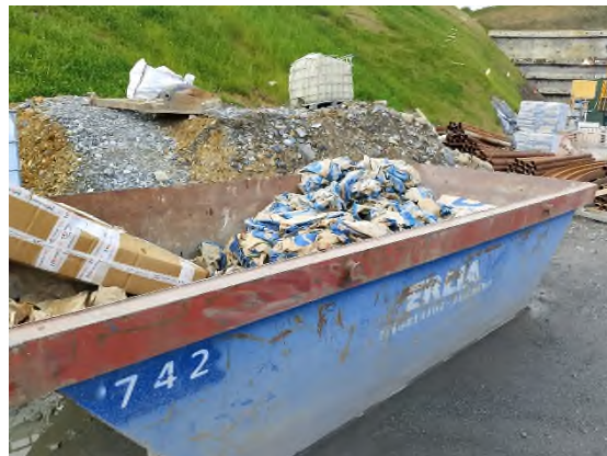
Foto nº54: Contenedores de papel en Etxebarria
