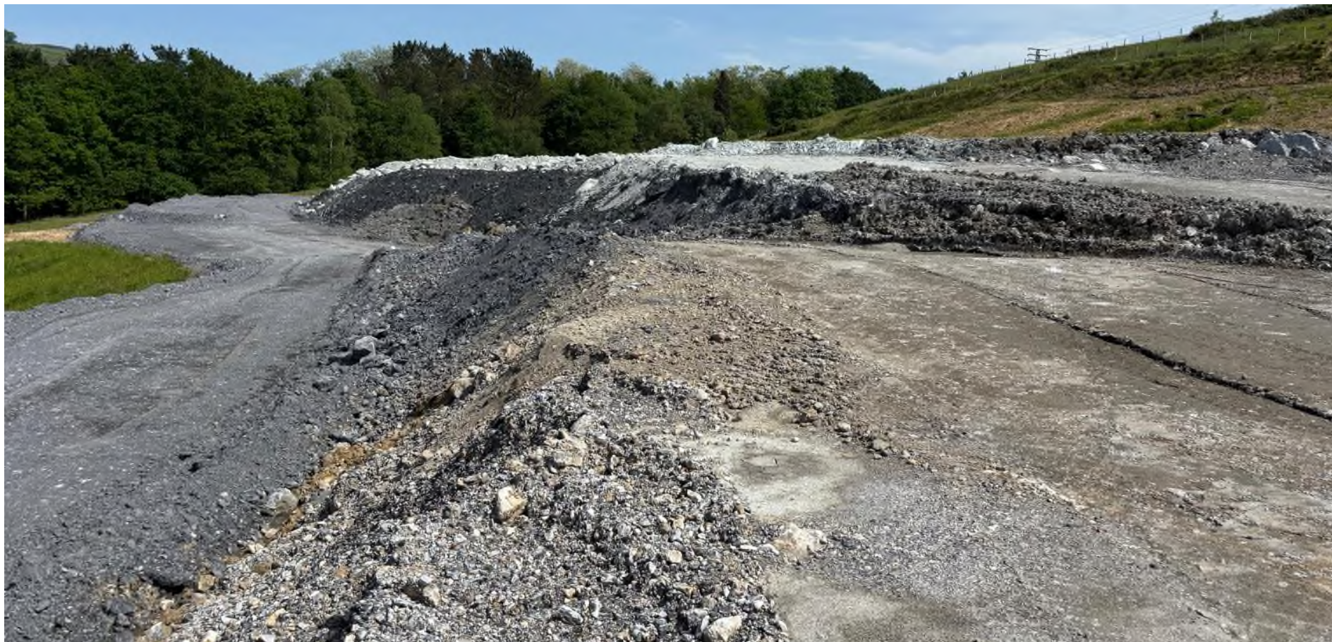
EXPLANADA DEPOSITO DE SOBRANTES
