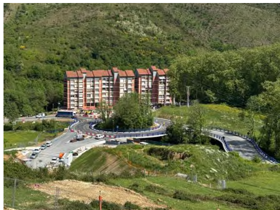
Foto nº8: Puesta en servicio rotonda Etxebarria
