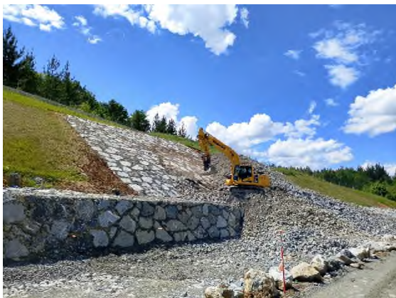
Foto nº11: Recrecido escollera eje-21 Markina
