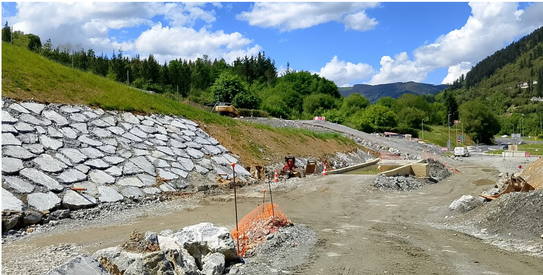
LAVARRUEDAS CANADIENSE Y ACCESO AL DEPOSITO DE SOBRANTES
