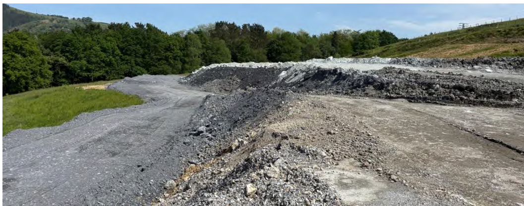
Foto nº57: Vista de explanada del depósito de sobrantes.
