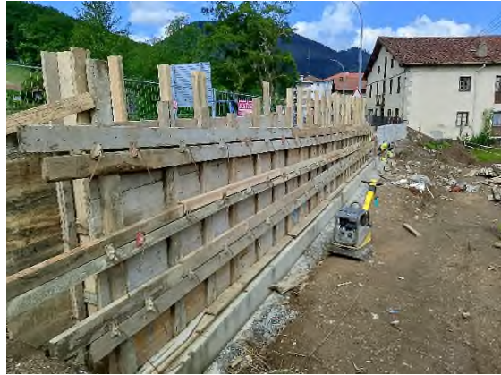
Foto nº10: Bidegorri: muro y urbanización.
