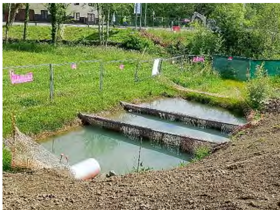
Foto nº31: Balsa decantación Etxebarria
