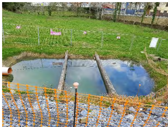
Foto nº23: Balsa de decantación Atain
