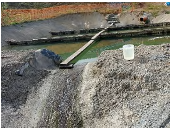
Foto nº58: Punto de vertido de la balsa de decantación del DS
