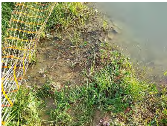
Foto nº22: Zona de vertido de la balsa de Atain
