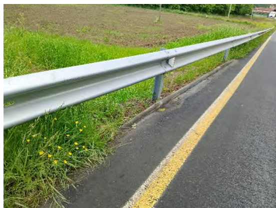
Foto nº62: Vista del bordillo instalado
