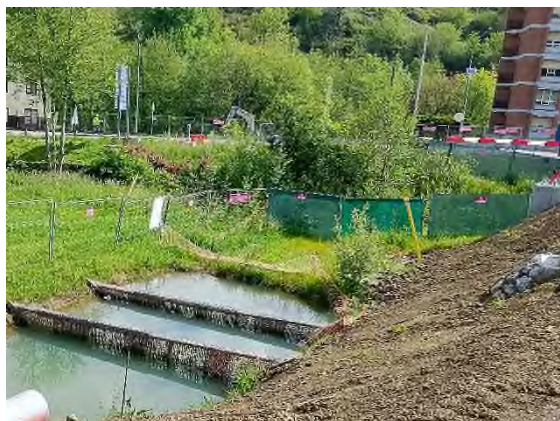
Foto nº55: Detalle vallado opaco acondicionado entorno al E-3
