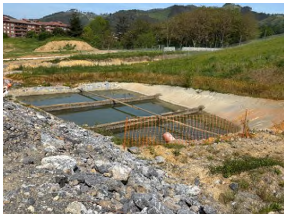
Foto nº32: Balsa de decantación del DS
