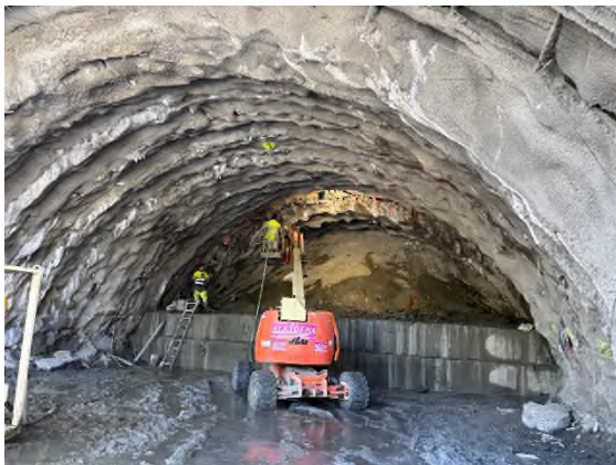
Foto nº5: Trabajos estabilización boca este.
