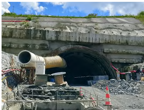
Foto nº4: Emboquille de túnel boca oeste
