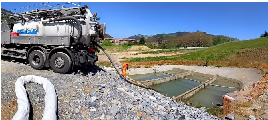
Foto nº33: Limpieza en la balsa del DS
