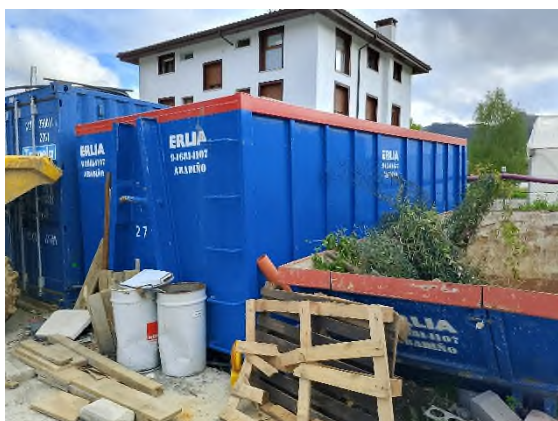
Foto nº51: Contenedores de RNPs habilitados en la zona casetas de obra Markina.
