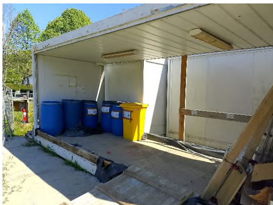
Foto nº49: Punto limpio tras la gestión en las casetas de Markina
