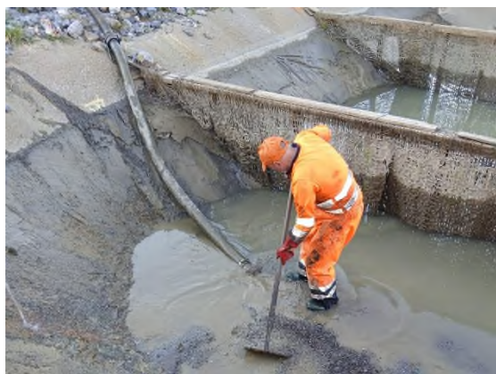
Foto nº34: Operario realizando limpieza de la balsa.
