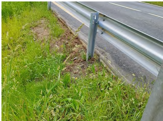
Foto nº61: Bordillo instalado en MC3
