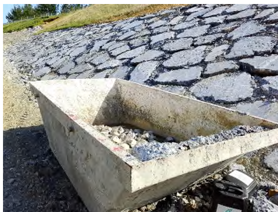
Foto nº40: Limpieza de canaletas en el eje-19.
