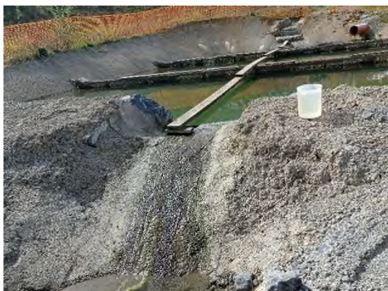
Foto nº20: Zona de vertido de la balsa del DS
