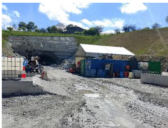
Foto nº42: Instalaciones auxiliares S4
