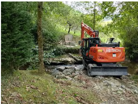
Foto nº41: Retirada de la caseta
