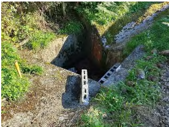
Foto nº30: Desvíos en las cunetas hacia la obra de drenaje.
