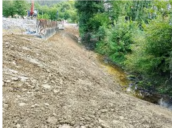
Foto nº18: Vista del cauce del arroyo tras la colocación de la alineación de rocas.
