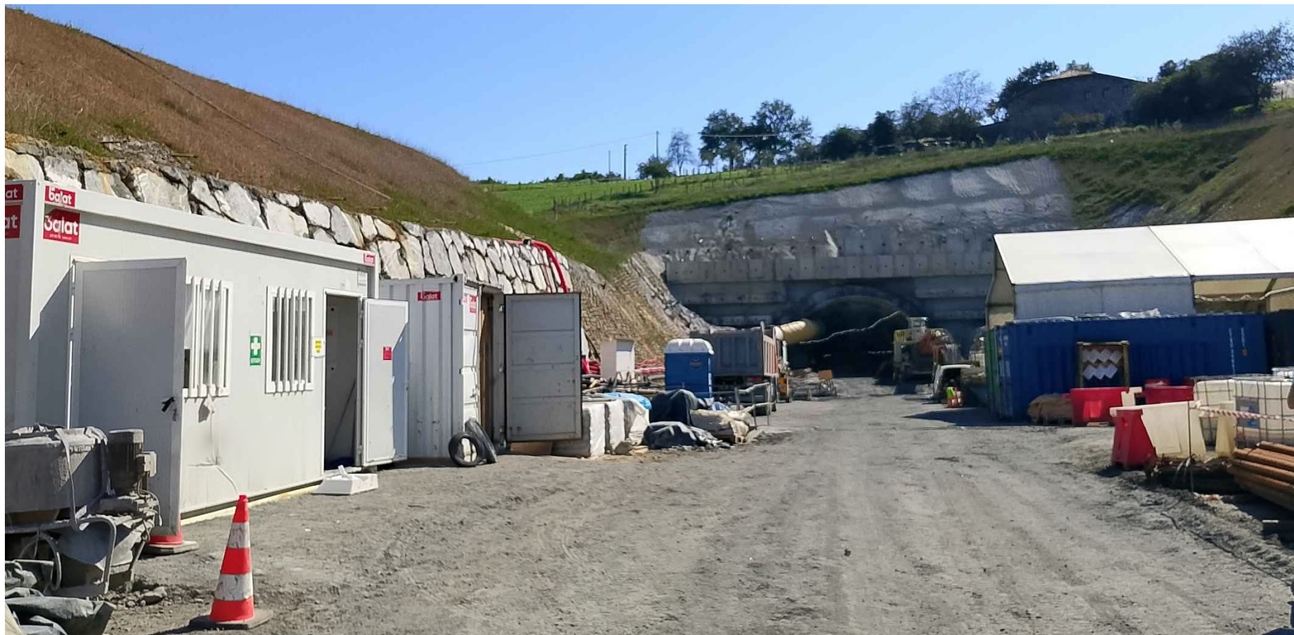
EMBOQUILLE TUNEL MARKINA Y ZONA AUXILIAR S4
