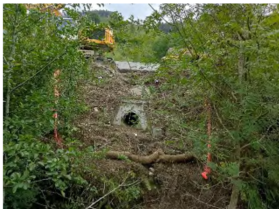
Foto nº33: Barrera de biorrollos acondicionada a la salida de la obra de drenaje.
