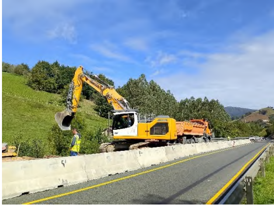
Foto nº28: Excavación en MC2
