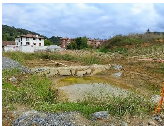
Foto nº4: Balsa de decantación eje-19
