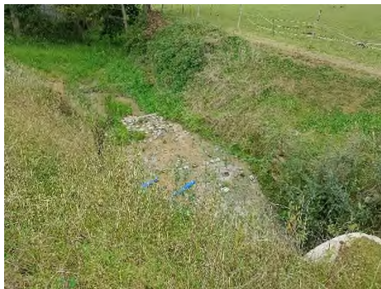
Foto nº2: Desagüe de la ODTC-04
