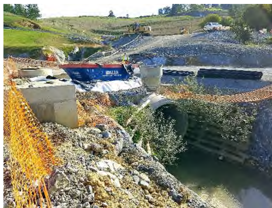
Foto nº10: Limpieza de canaletas en Markina
