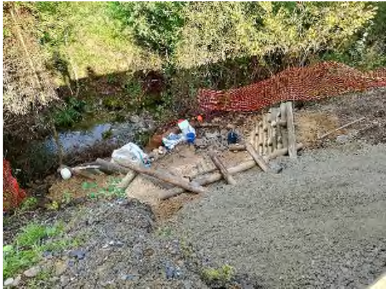
Foto nº39: Instalación de troncos para Krainer
