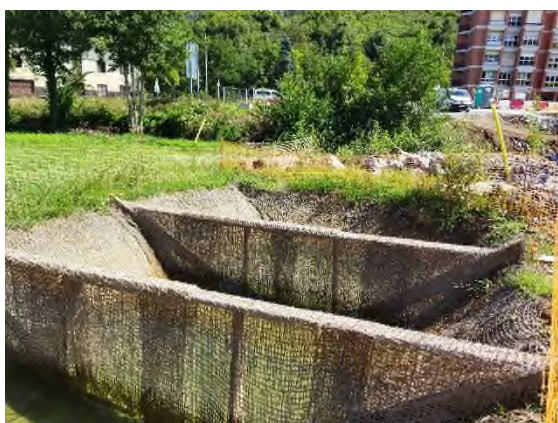
Foto nº3: Balsa decantación Etxebarria
