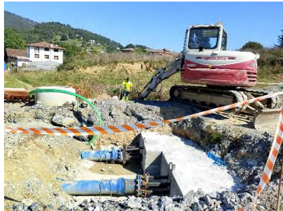
Foto nº6: Desvío abastecimiento Markina
