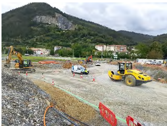
Foto nº1: Eje-2 regularización y explanada
