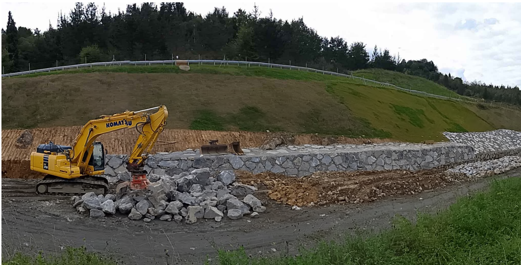
EJE 21-MARKINA, MURO DE ESCOLLERA
