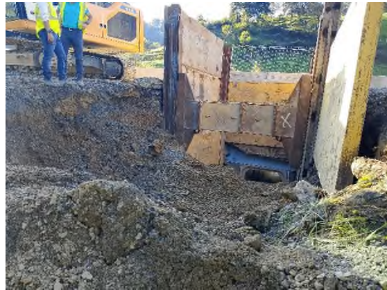
Foto nº29: Colocación de marcos en MC2
