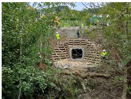
Foto nº34: Biorrollos a la salida del marco previo al río.
