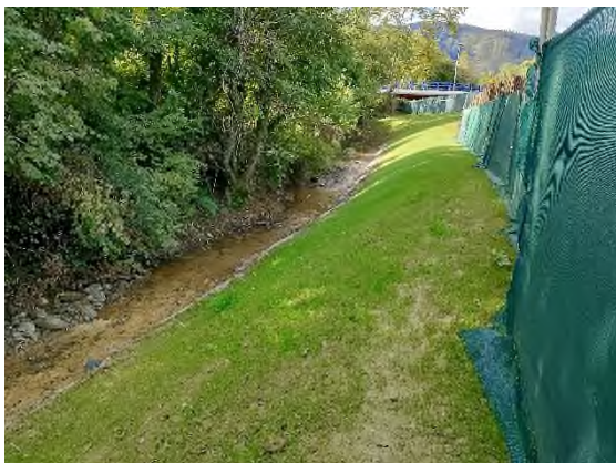
Foto nº21: Hidrosiembra y estaquillado
