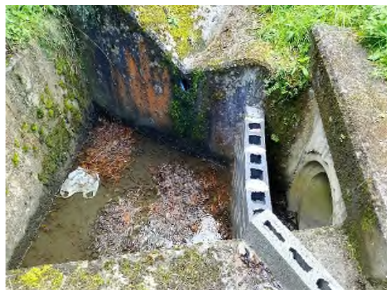
Foto nº31: Balsa en la obra de drenaje
