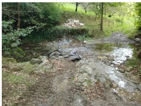
Foto nº44: Retirada de la zona del cauce.
