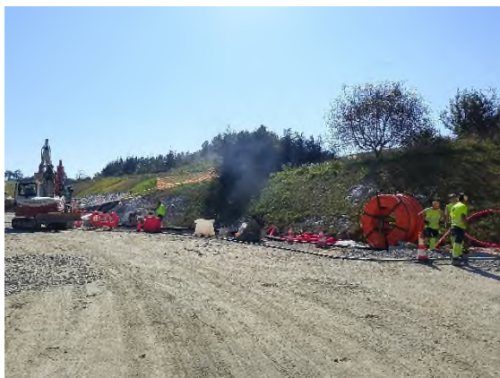
Foto nº7: Eje 2: arquetas y canalizaciones servicios
