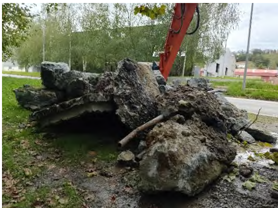
Foto nº43: Hormigón retirado del cauce
