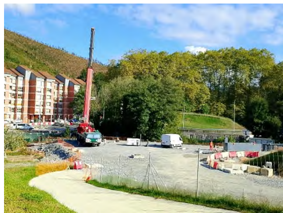
Foto nº8: Estribo 3: Recepción de vigas y premontaje.
