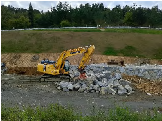
Foto nº5: Muro escollera eje-21
