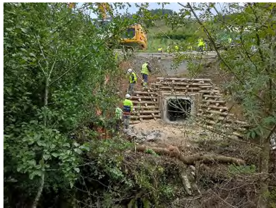
Foto nº40: Labores de instalación de Krainer y extendido de TV
