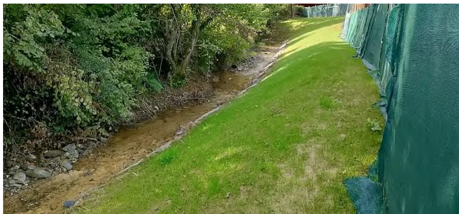
Foto nº24: Hidrosiembra y estaquillado
