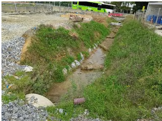
Foto nº11: Biorrollos en ODTC-02
