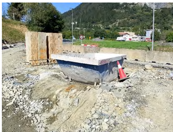
Foto nº9: Limpieza de canaletas en Markina
