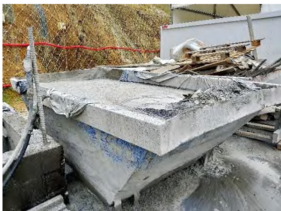
Foto nº8: Limpieza de canaletas en S4
