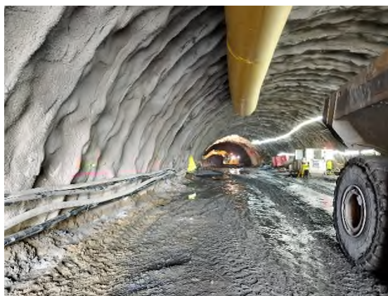
Foto nº2: Excavación en mina del tunel
