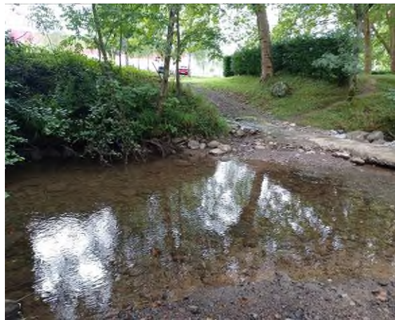
Franja transversal de hormigón en el cauce
