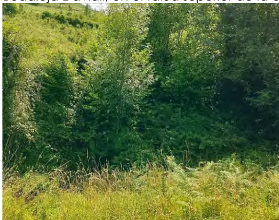
Fresno sobre la estructura de hormigón, aguas arriba
