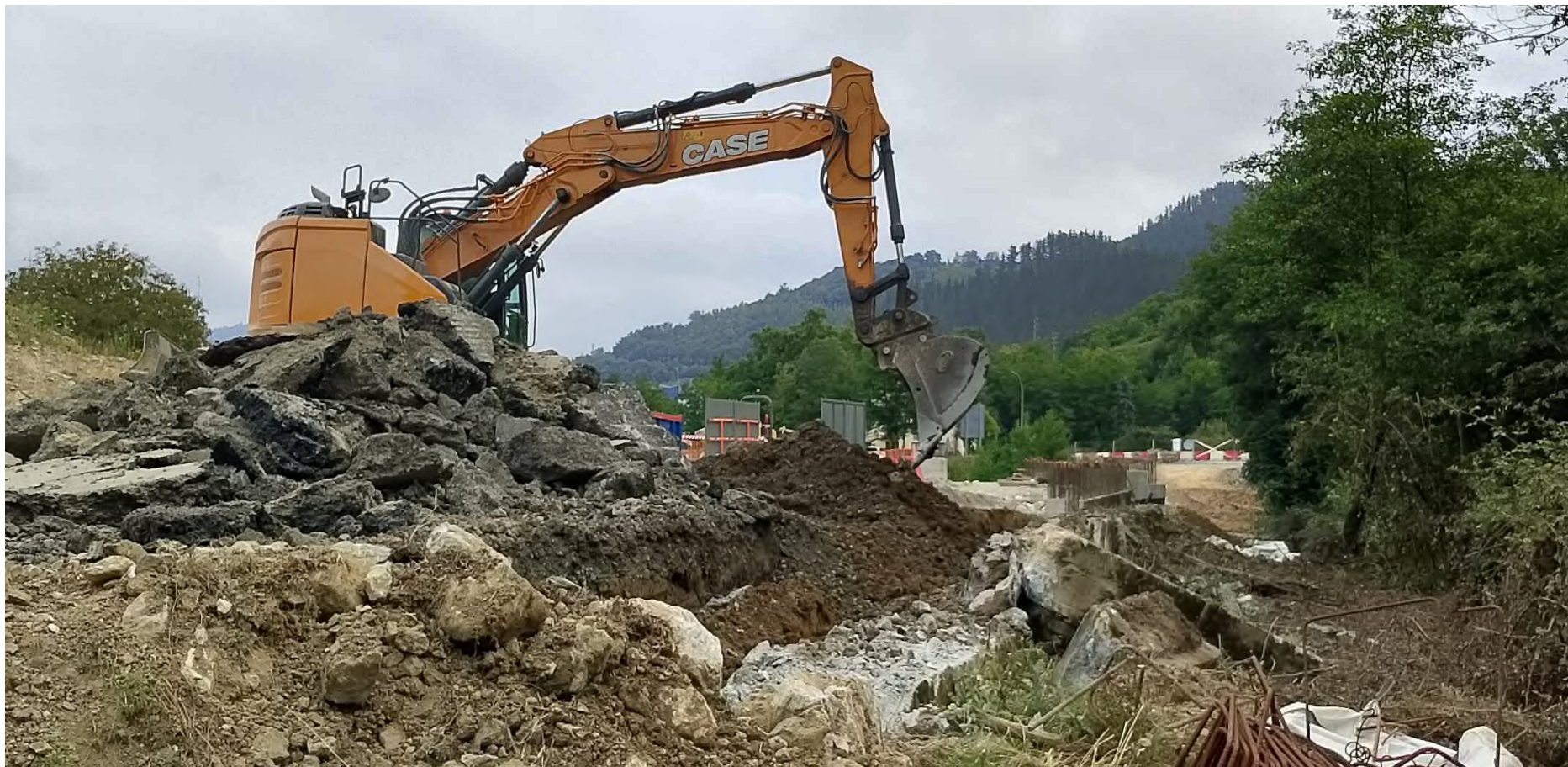
RETIRADA MURO JUNTO AL ARROYO MUNIBERREKA
