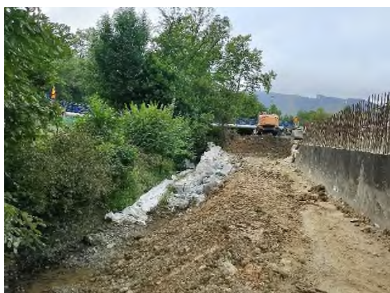
Foto nº20: Geotextiles en el arroyo Muniberreka
