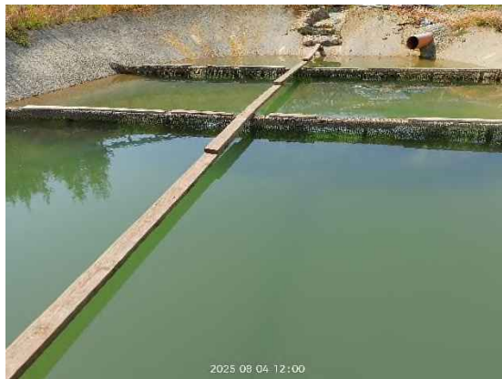
Foto nº3: Balsa de decantación del DS
