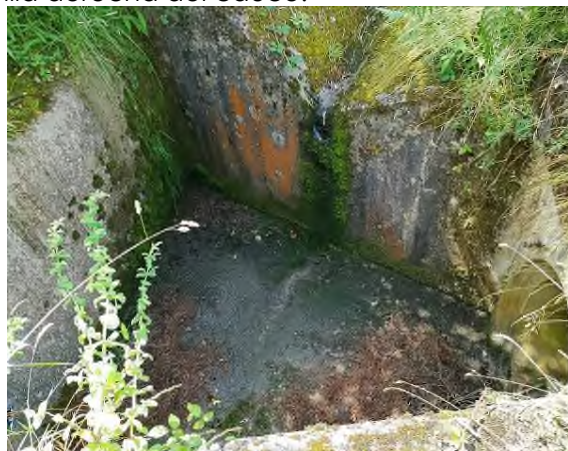
Estructura de hormigón a demoler aguas arriba
