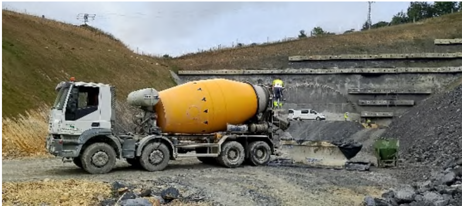
Foto nº9: Limpieza de canaletas en Etxebarria
