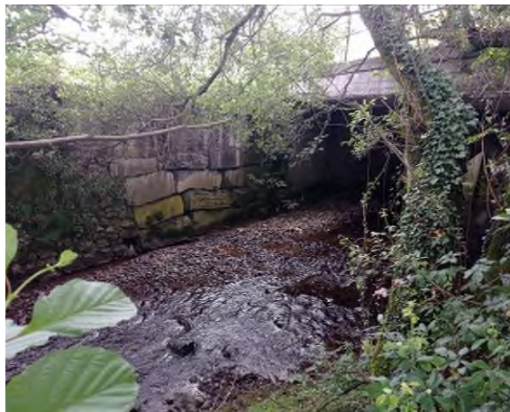
Detalle del cauce y puente aguas arriba
