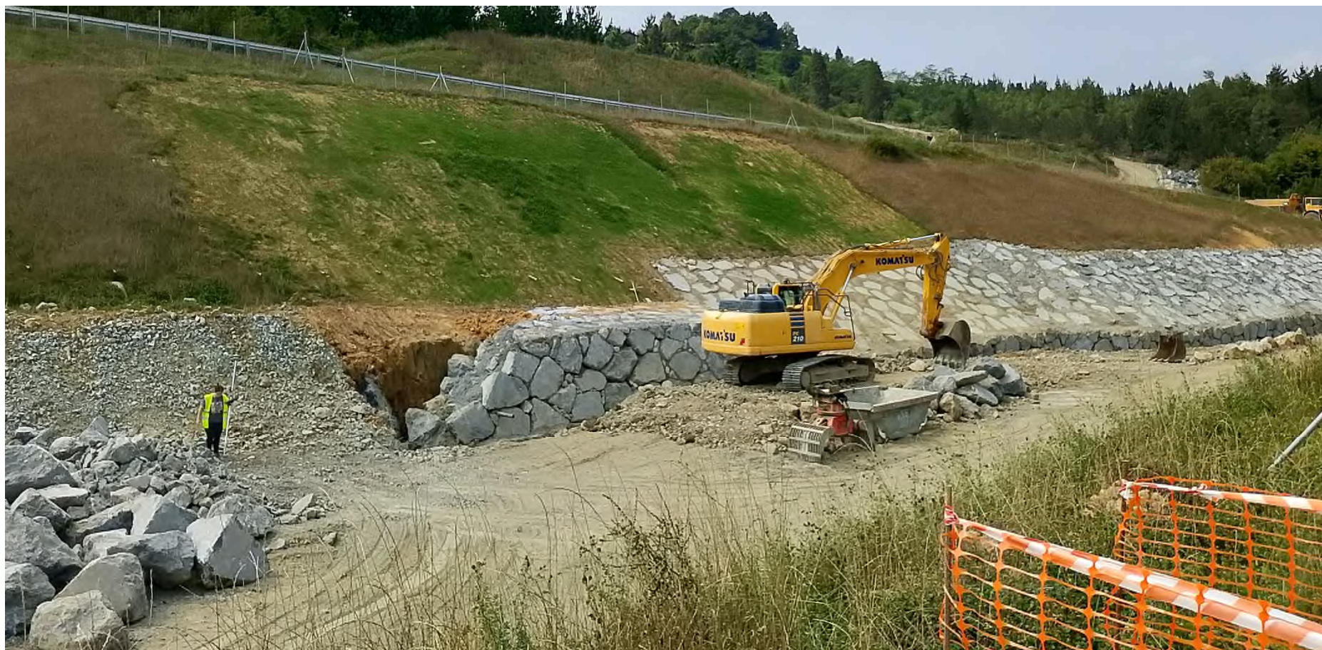
EJE 21-MARKINA, MURO DE ESCOLLERA
