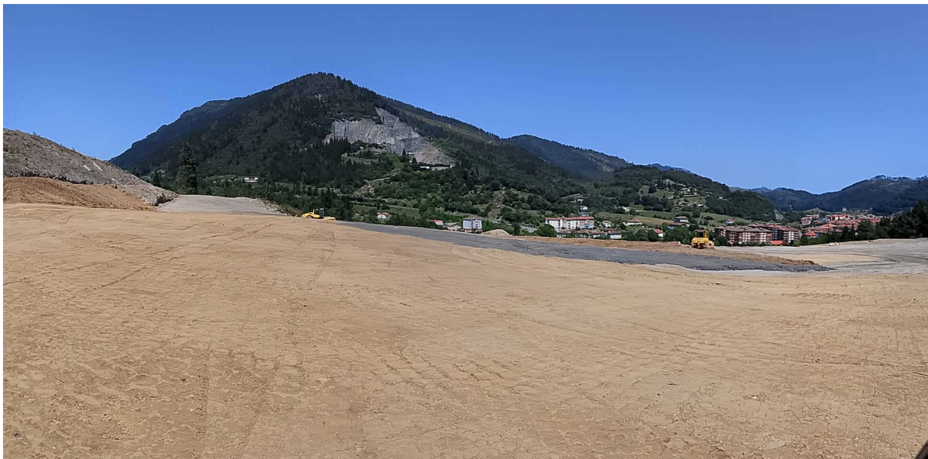
EXPLANADA DEPOSITO DE SOBRANTES
