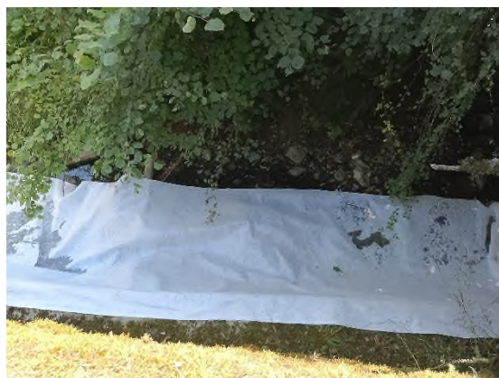
Foto nº19: Detalle del geotextil habilitado
