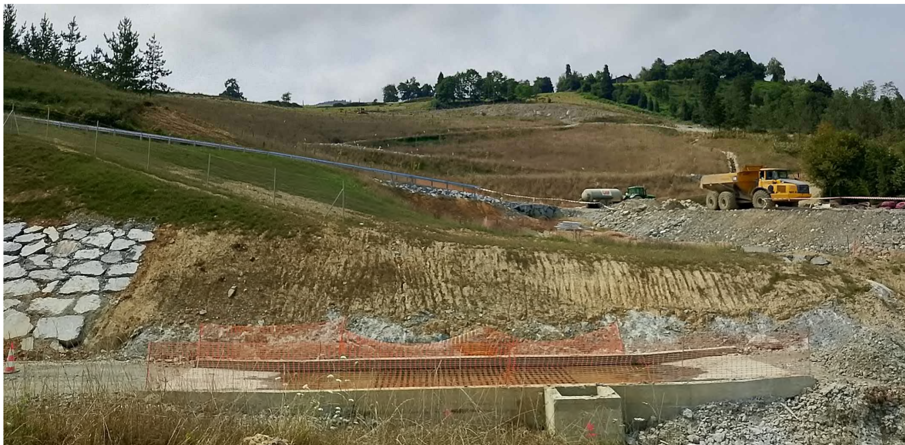
PASO CANADIENSE EN EL EJE 21 DESTINO DEPOSITO DE SOBRANTES
