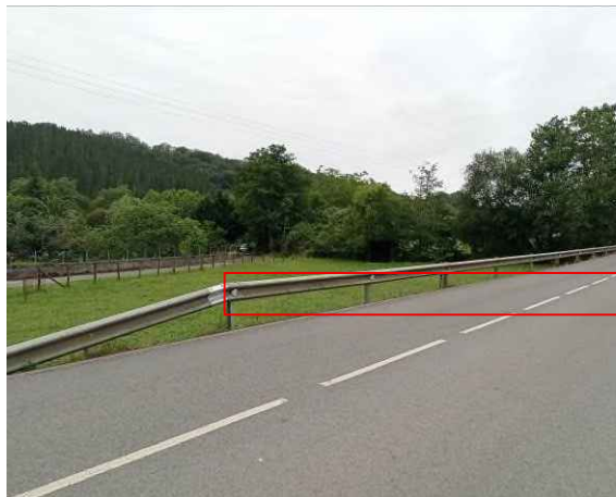
Paso seco bajo la carretera
