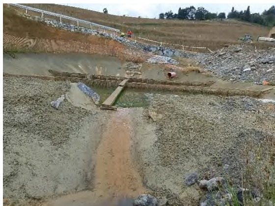
Foto nº22: Balsa de decantación del DS
