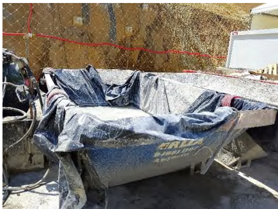
Foto nº7: Limpieza de canaletas en S4
