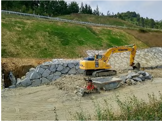
Foto nº3: Muro escollera eje-21
