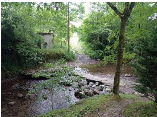
Estructura del antiguo aprovechamiento de aguas
