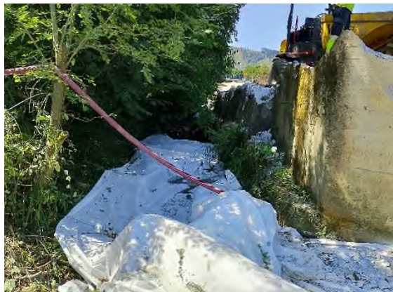
Foto nº16: Geotextiles en el arroyo Muniberreka
