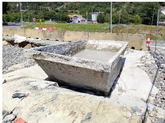
Foto nº8: Limpieza de canaletas en Markina
