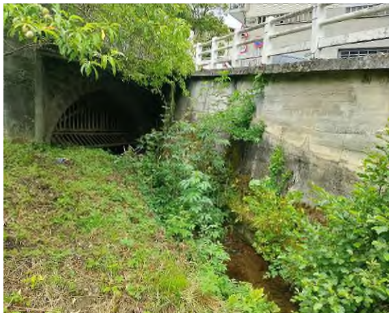
Vista general de la estructura y el cauce
