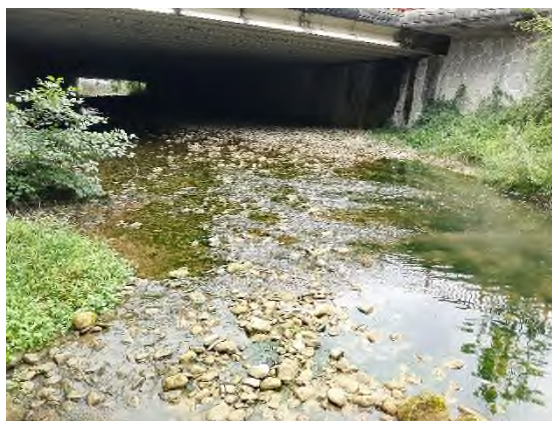
Foto nº10: Aguas abajo Artibai
