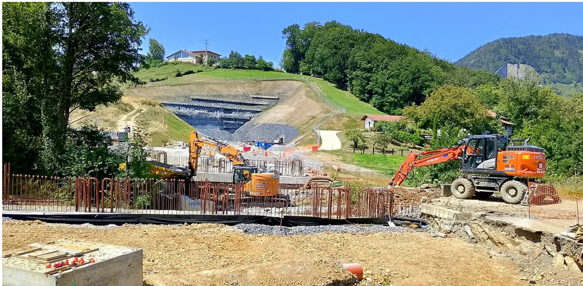
VISTA GENERAL ZONA DE ETXEBARRIA
