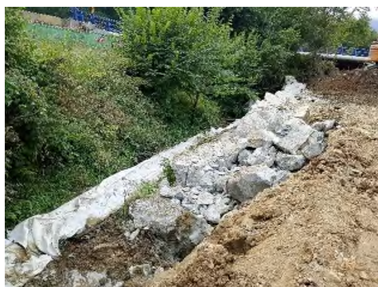
Foto nº21: Derribo muro anexo al arroyo Muniberreka
