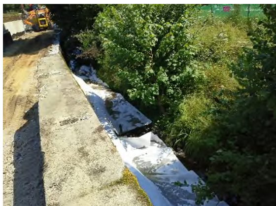
Foto nº18: Geotextiles en el arroyo Muniberreka
