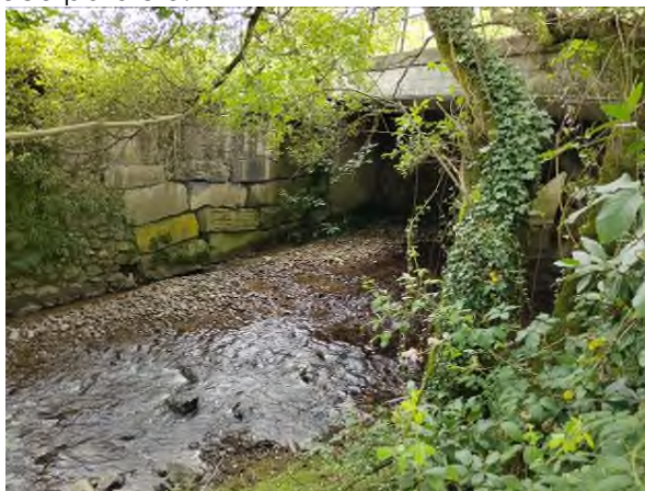
Puente en el P.K. 52+070
