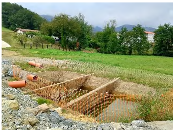
Foto nº1: Balsa decantación Etxebarria
