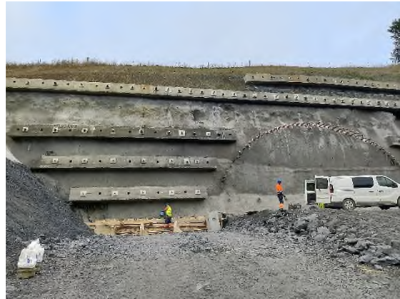
Foto nº6: Anclajes y viga de atado nivel-7
