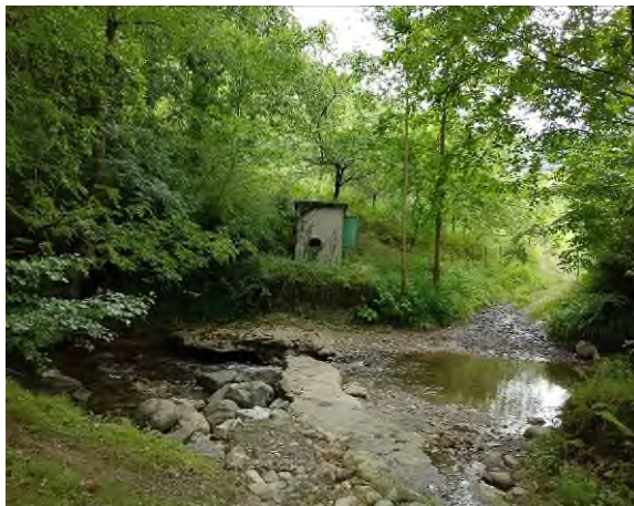
Vista general de la estructura de aprovechamiento de aguas
