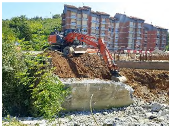
Foto nº1: Excavación eje-3 Etxebarria
