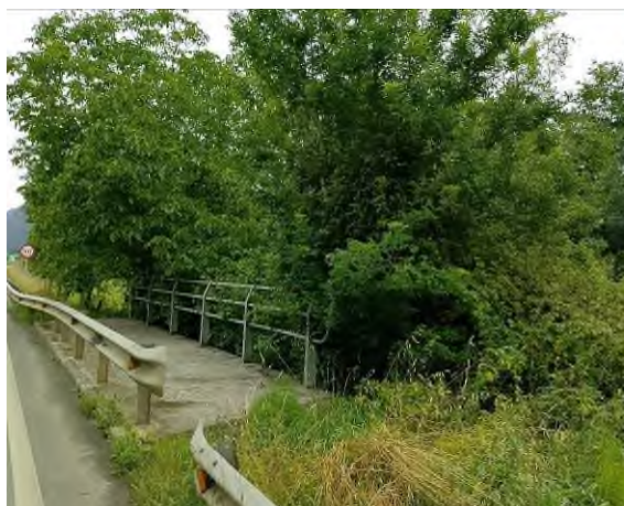
Vegetación aguas abajo del puente
