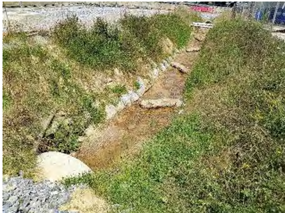
Foto nº10: Biorrollos en ODTC-02
