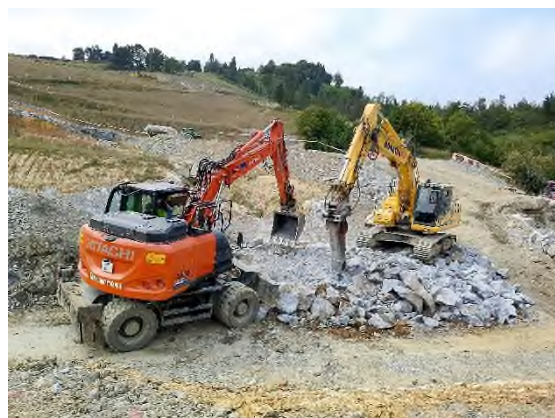
Foto nº2: Excavación Eje-21 Markina
