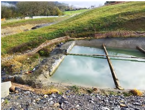
Foto nº22: Balsa de decantación del DS
