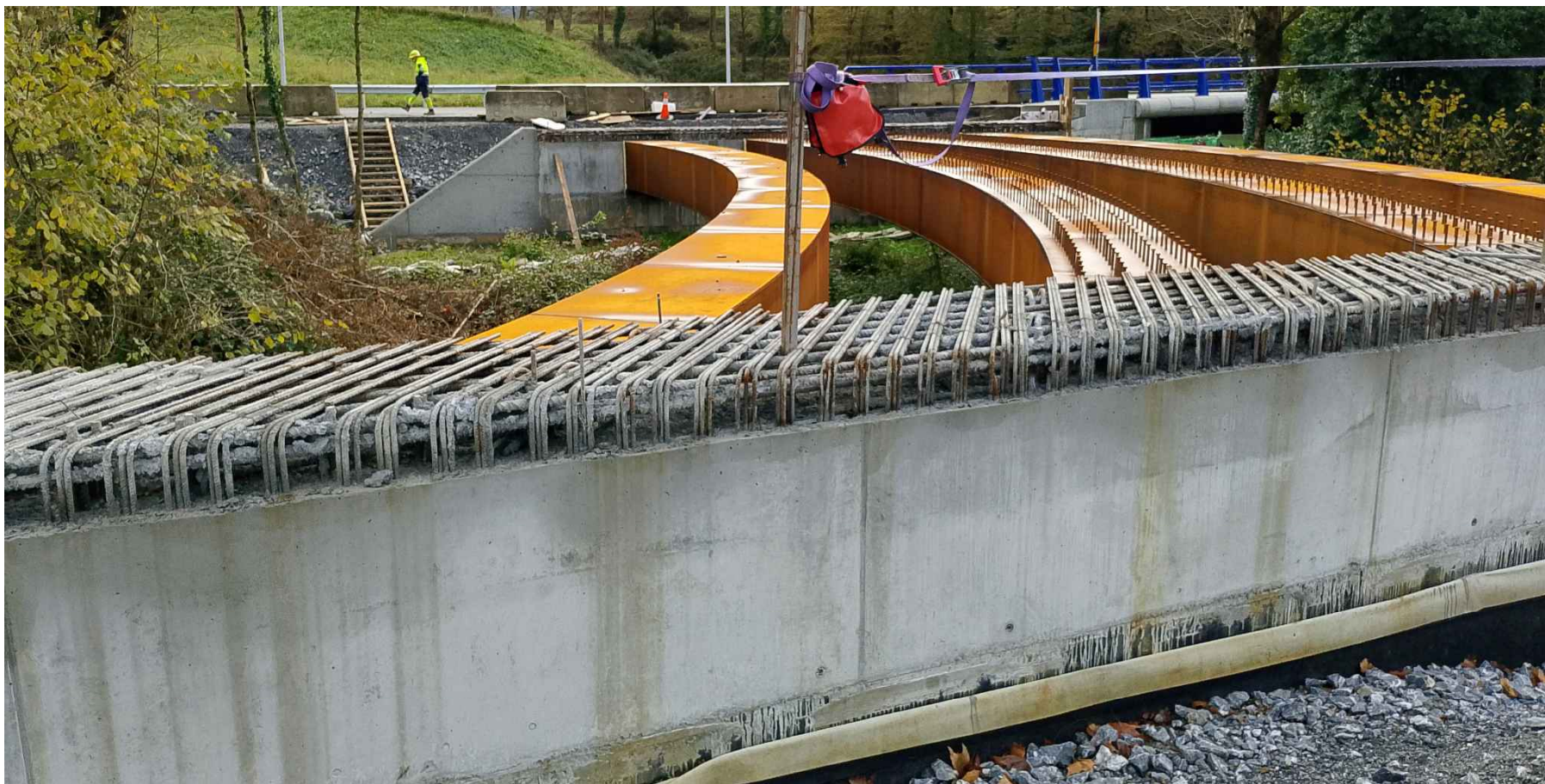
HORMIGONADO ESTRUCTURA-2 ETXEBERRIA
