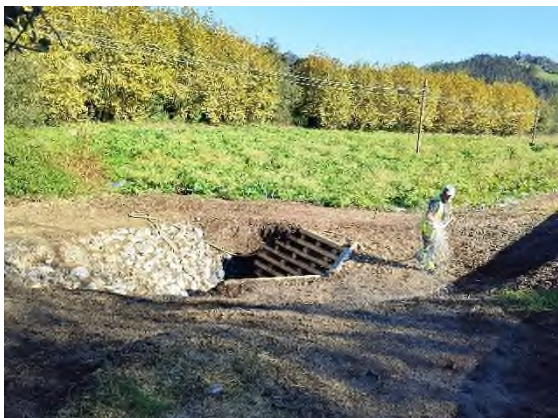
Foto nº28: Hidrosiembra aguas arriba del cajón
