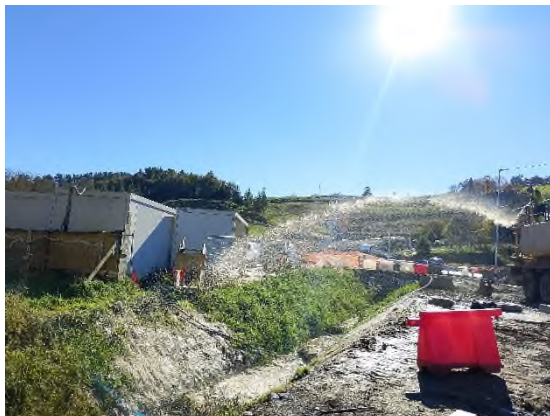
Foto nº21: Hidrosiembra ODT-C2 aguas abajo
