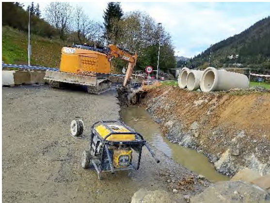
Foto nº1: Eje-19 regularización y explanada
