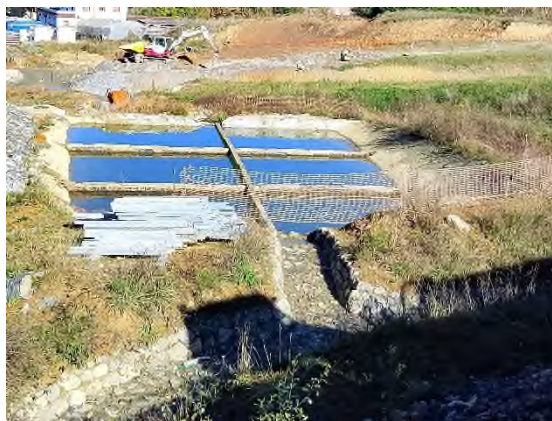
Foto nº3: Balsa de decantación del DS
