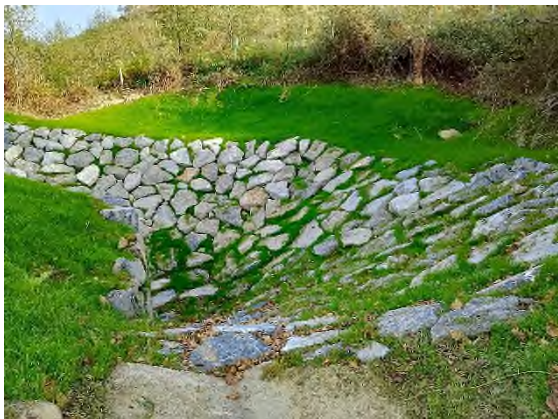
Foto nº26: Reperfilado de la zona aguas arriba
