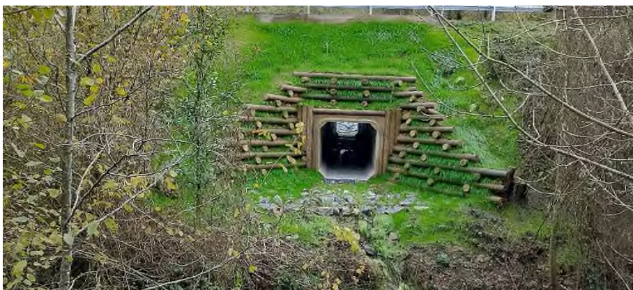
Foto nº25: Vista del krameria ejecutado
