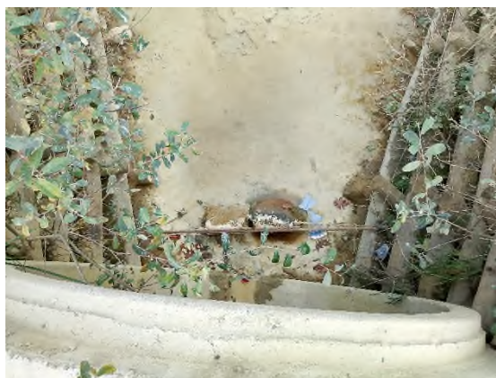
Foto nº11: Floculante a la salida del tubo de la ODTC-02
