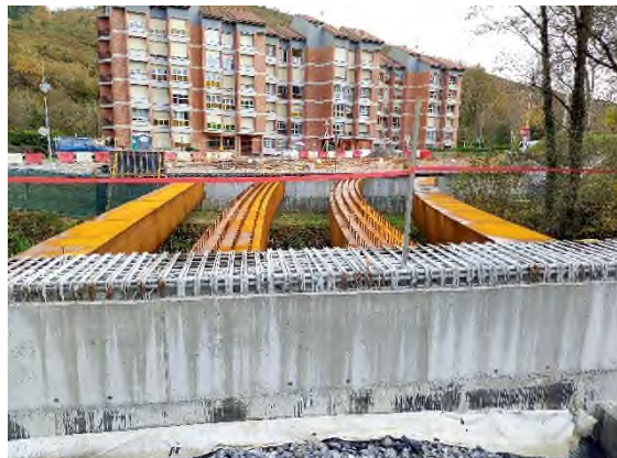
Foto nº6: Trabajos en la estructura-1 de Etxebarria.
