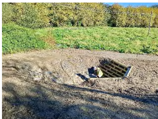
Foto nº29: Hidrosiembra del krainer aguas arriba.
