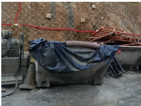
Foto nº6: Limpieza de canaletas en S4
