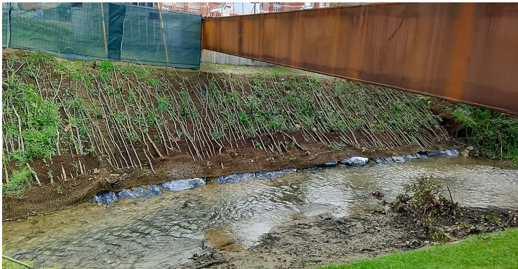
ESTERA DE RAMAJE BAJO LA ESTRUCTURA-3 DE ETXEBARRIA
