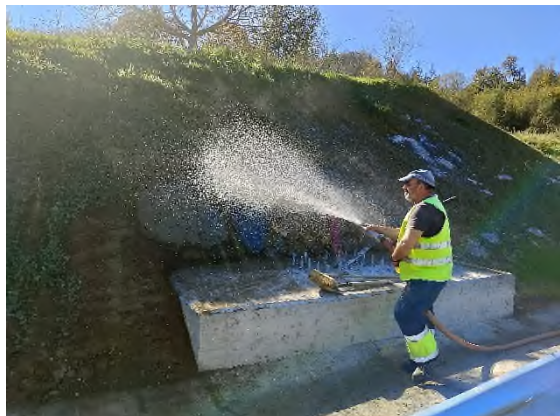
Foto nº20: Hidrosiembra ODT-C2 margen izquierda talud
