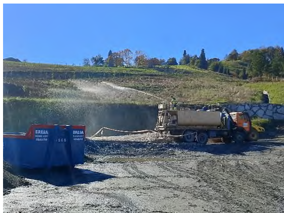
Foto nº18: Hidrosiembra entre eje 24 y pie DPS
