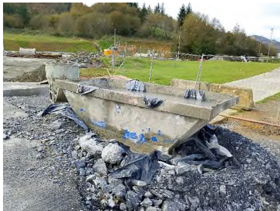
Foto nº9: Limpieza de canaletas en Markina eje-2
