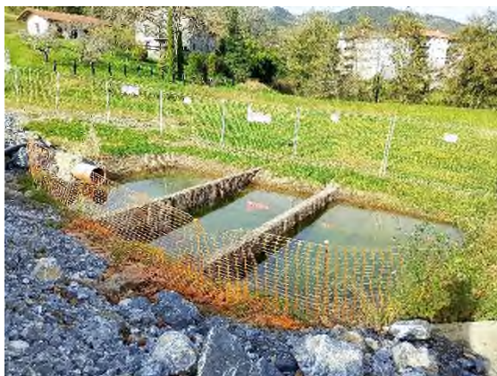
Foto nº2: Balsa decantación Etxebarria
