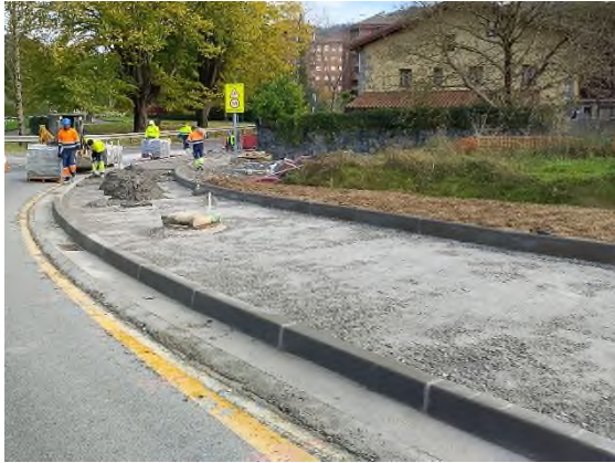
Foto nº7: Eje 19: bordillo y rigolas
