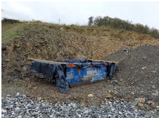
Foto nº8: Limpieza de canaletas en Etxebarria
