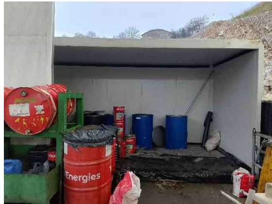
Foto nº15: Acopio de RPs en el punto limpio del S4 de Markina
