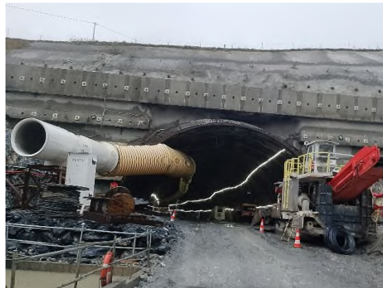
Foto nº2: Excavación en mina del túnel boca oeste.
