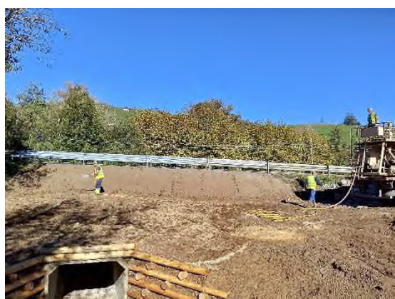
Foto nº31: Hidrosiembra de la zona aguas abajo del cajón.
