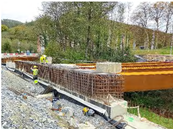
Foto nº5: Trabajos en la estructura-2 de Etxebarria
