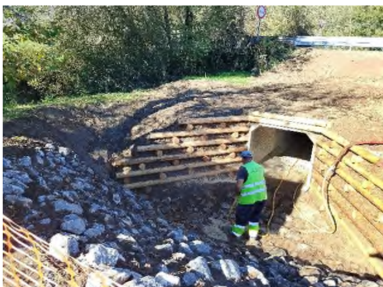
Foto nº30: Hidrosiembra del krainer aguas abajo
