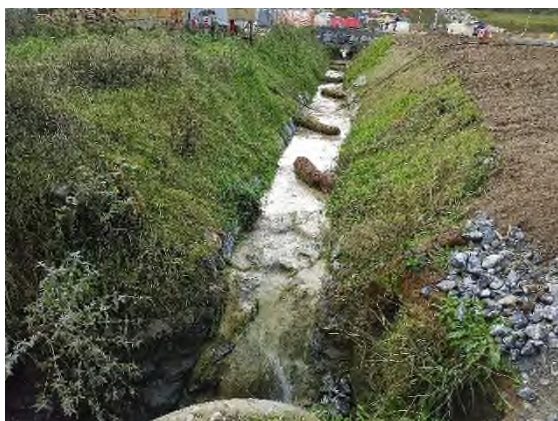
Foto nº10: Biorrollos en ODTC-02
