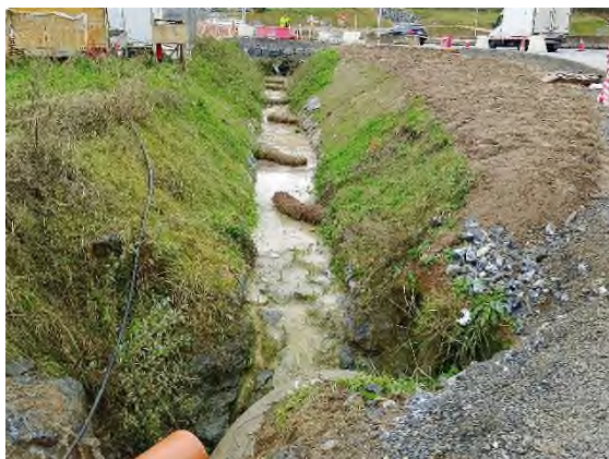
Foto nº14: Biorrollos en ODTC-02
