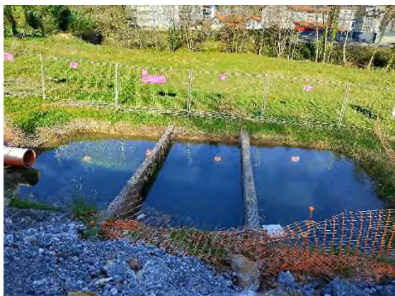
Foto nº3: Balsa decantación Etxebarria
