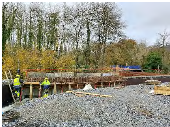
Foto nº1: Estructura-3, encofrado muro acompañamiento.
