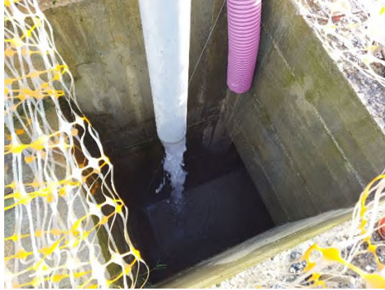
Foto nº12: Vertido de la depuradora
