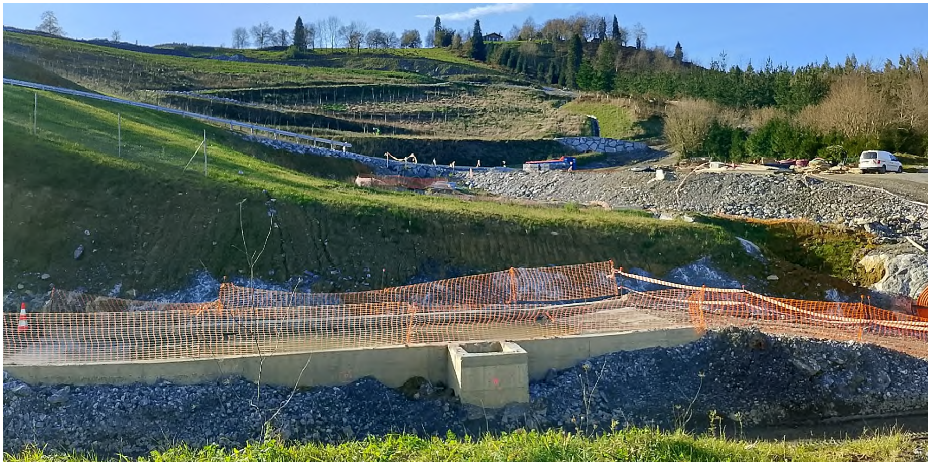
PASO CANADIENSE Y DEPOSITO DE SOBRANTES DE MARKINA
