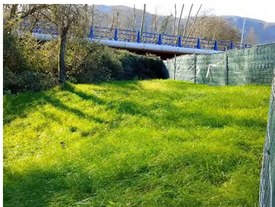
Foto nº20: Malla opaca en la zona de la E-1
