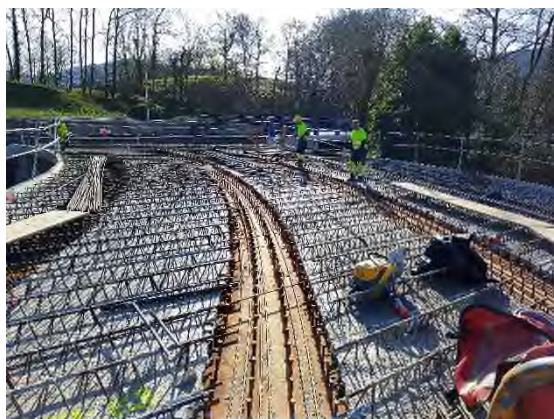
Foto nº2: Estructura 2: ferrallado
