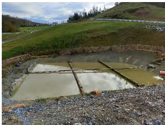
Foto nº4: Balsa de decantación del DS
