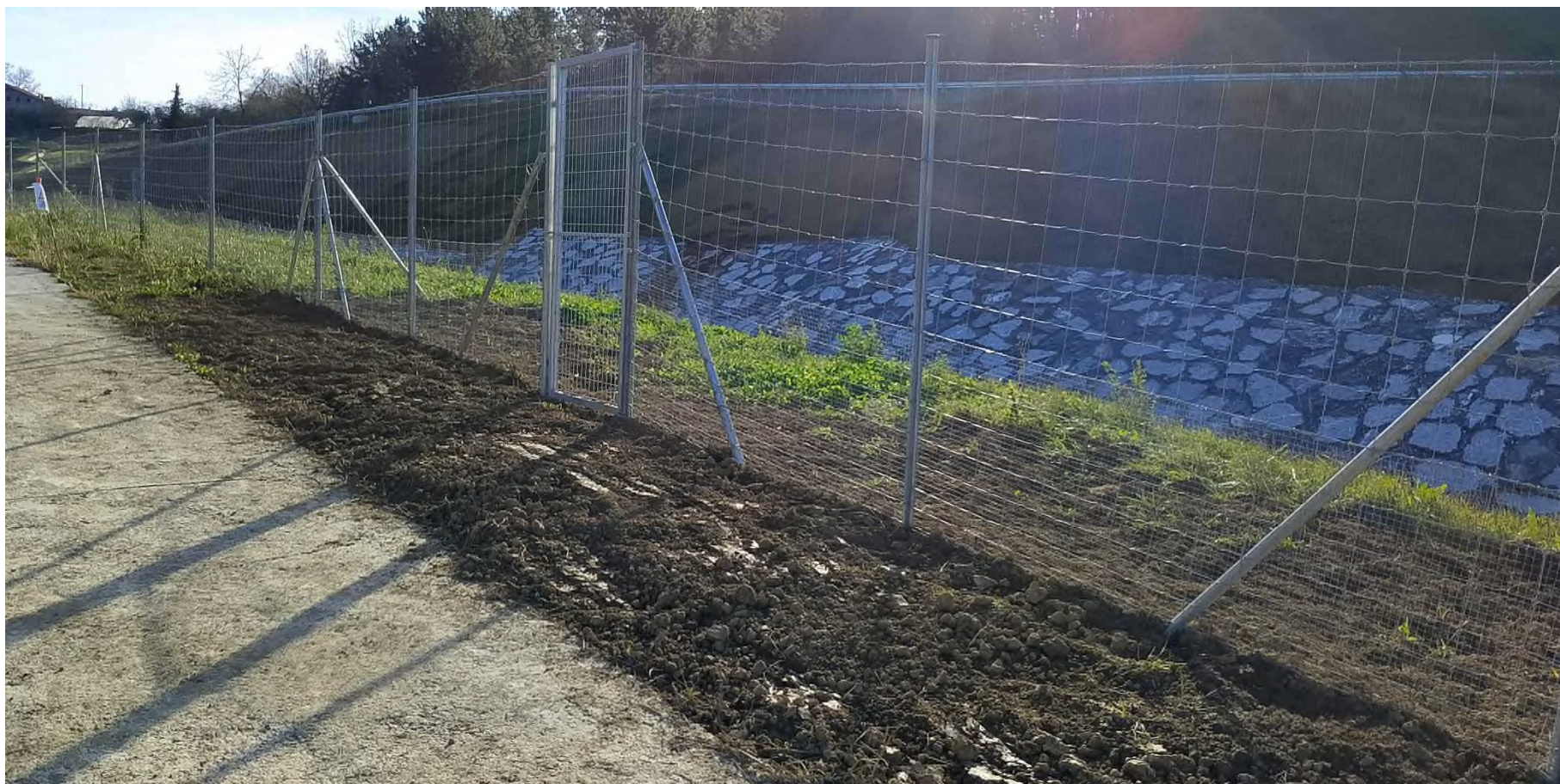
CERRAMIENTO E INSTALACIÓN DE PUERTAS
