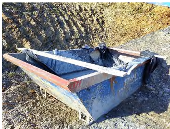
Limpieza de canaletas en Etxebarria
