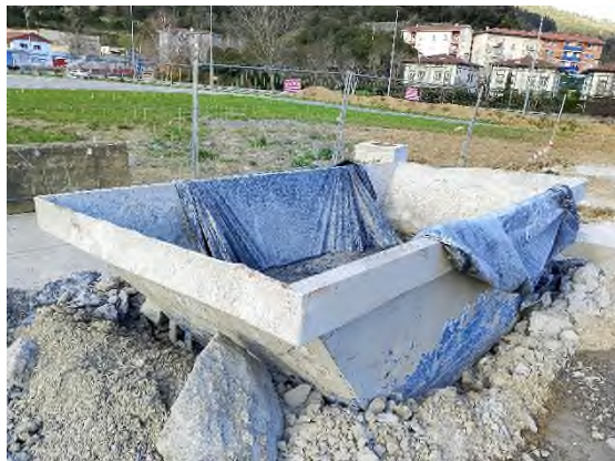
Foto nº8: Limpieza de canaletas en Markina eje-2
