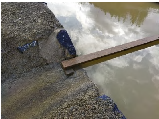
Foto nº13: Zona de vertido de la balsa del DS
