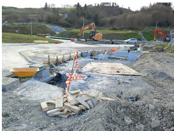
Foto nº4: Eje 2: recrecido de la plataforma, arquetas.
