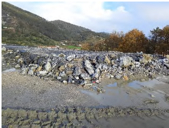
Foto nº24: Material extendido en el vaso del DS
