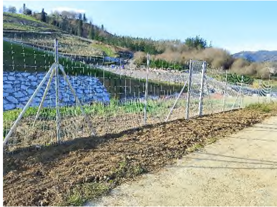
Foto nº6: Cerramiento, instalación de puertas
