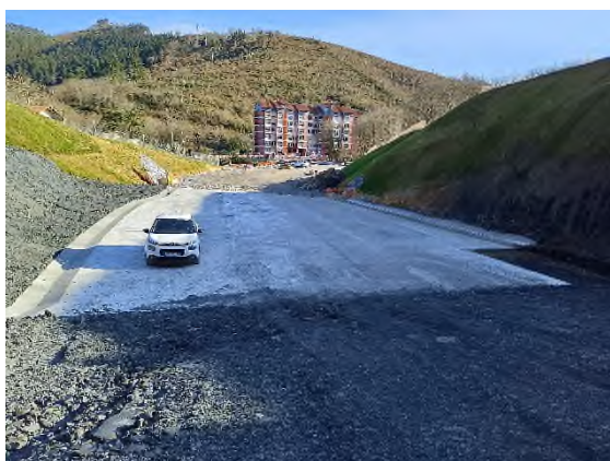
Foto nº9: Plataforma de hormigón S4
