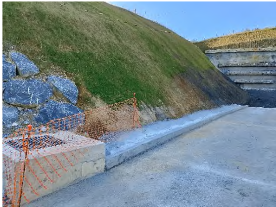
Foto nº11: Detalle cuneta sobreelevada.
