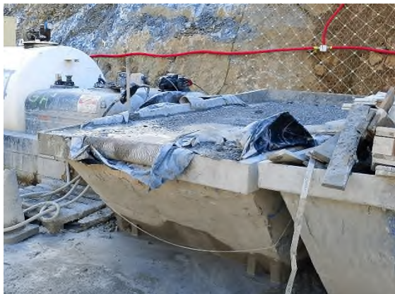
Foto nº7: Limpieza de canaletas en S4
