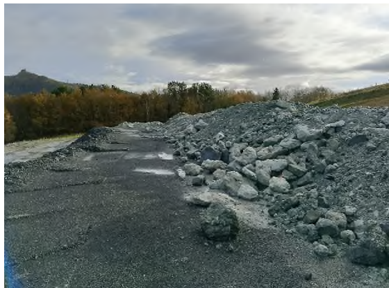
Foto nº23: Material acopiado para su extendido en el DS
