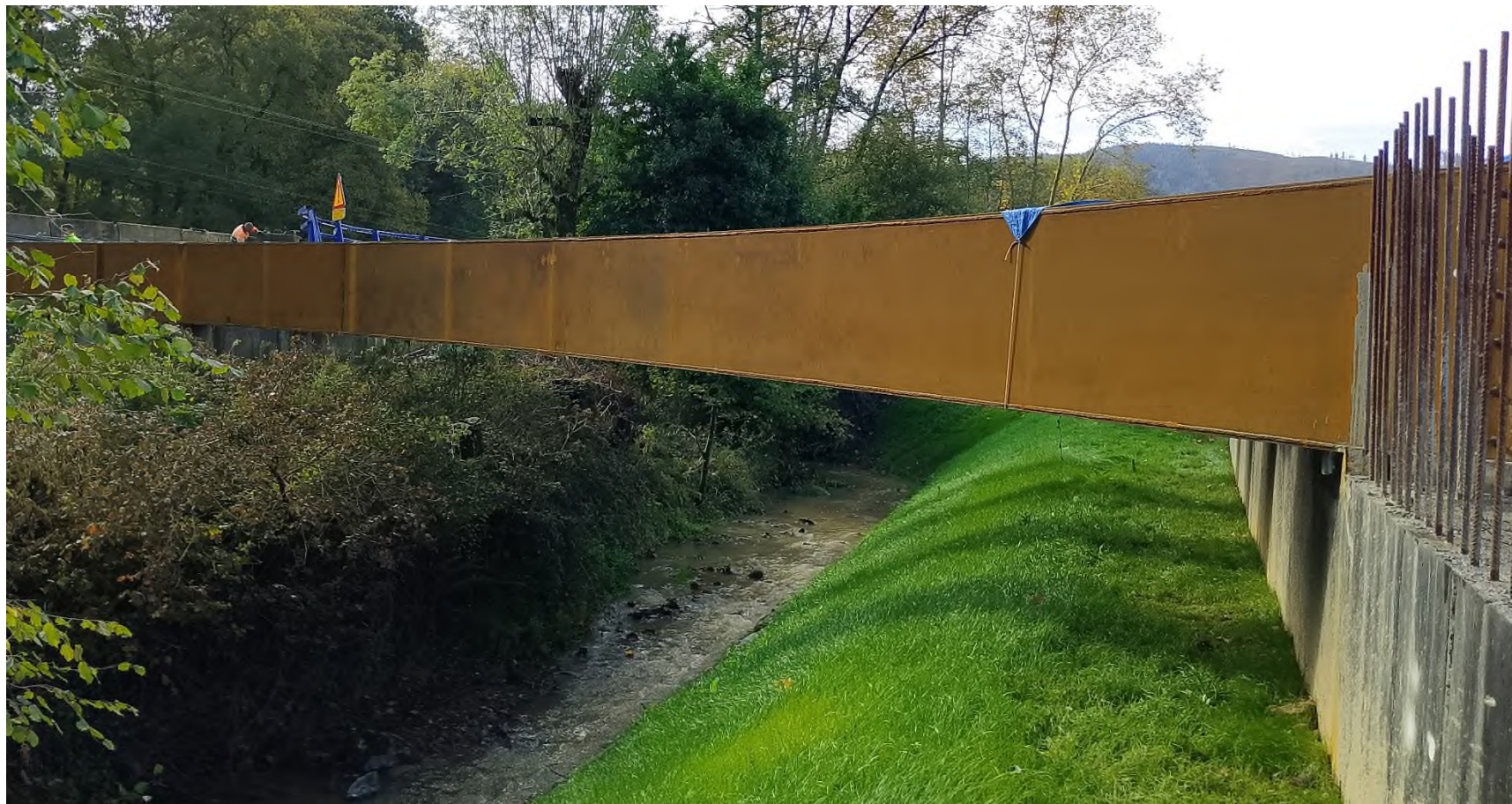
MONTAJE ESTRUCTURA-2 ETXEBERRIA
