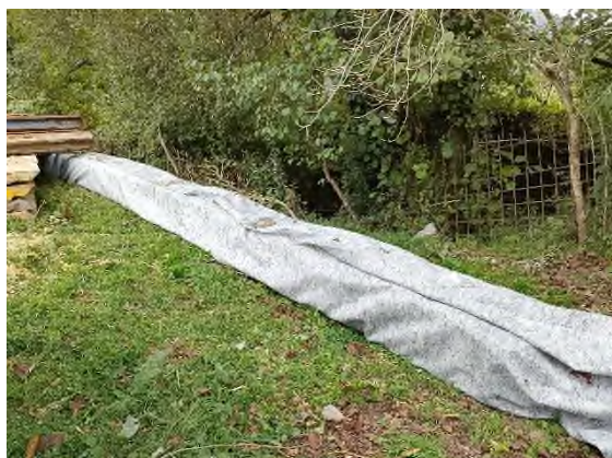
Foto nº38: Barrera de retención habilitada aguas abajo del ámbito de actuación.
