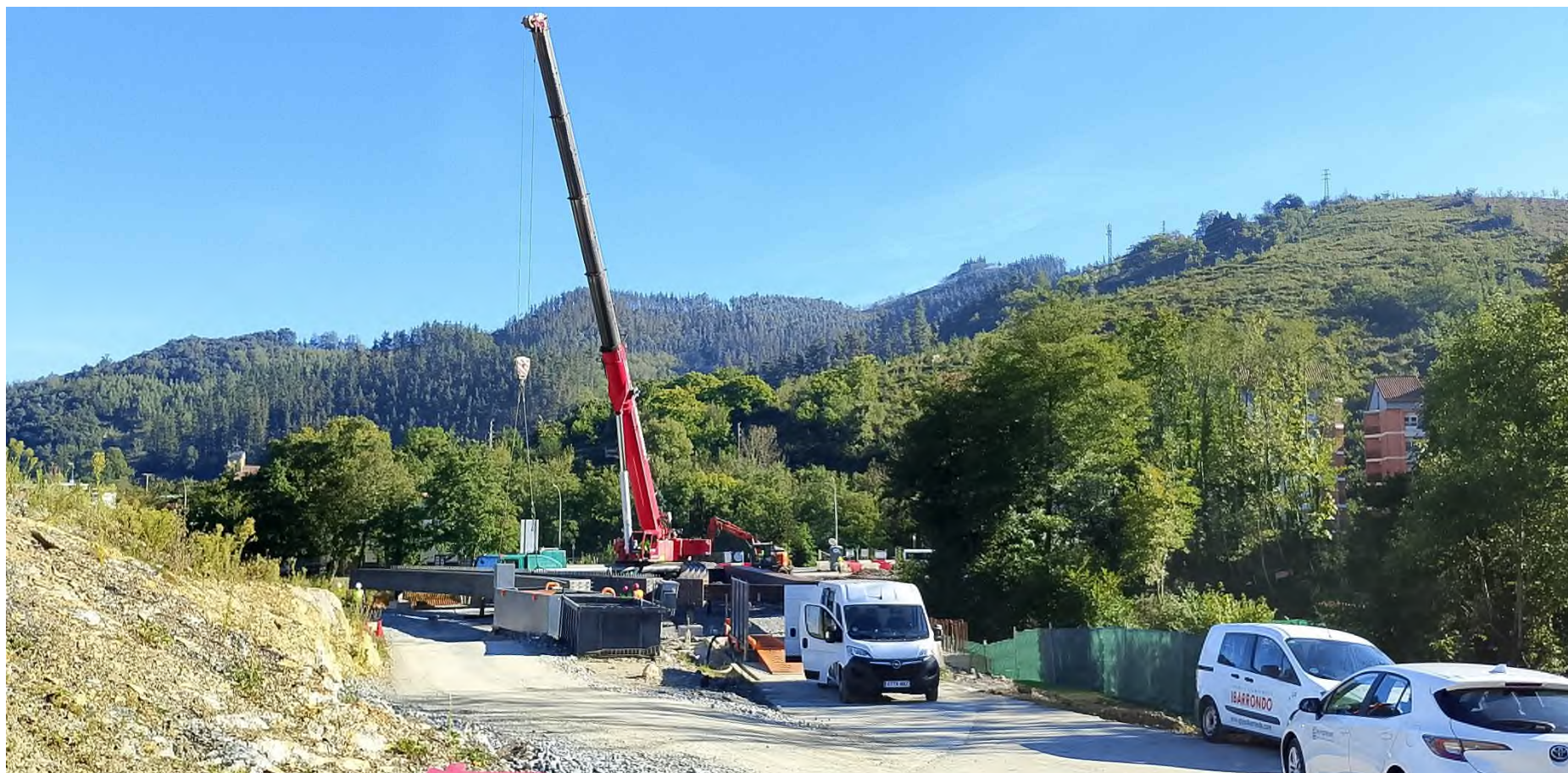
VISTA GENERAL MONTAJE DE VIGAS ZONA DE ETXEBARRIA
