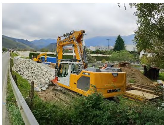
Foto nº37: Instalación de marcos.
