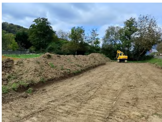
Foto nº36: Movimiento de tierras en MC-3.
