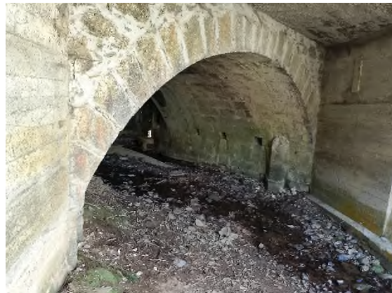
Foto nº47: Vista final tras la retirada de la estructura.
