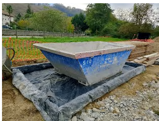
Foto nº39: punto de limpieza de canaletas habilitado.
