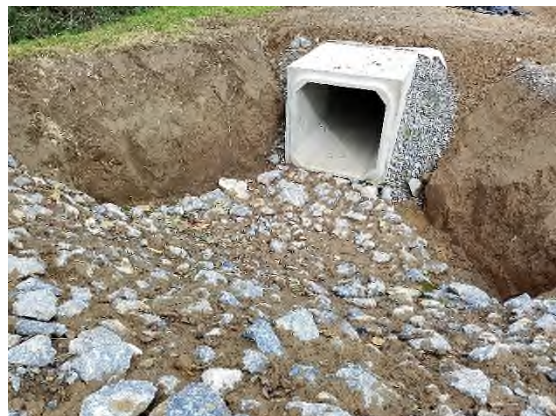
Foto nº43: Encachado de piedra en tierra aguas abajo.
