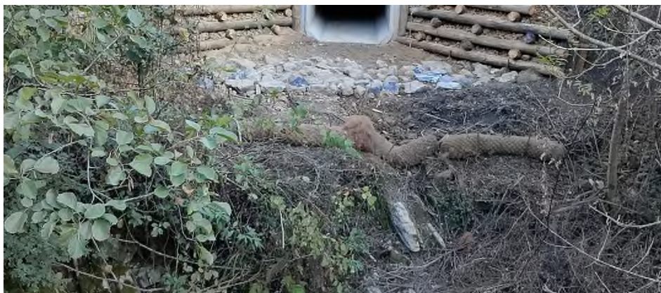
Foto nº28: Barrera de biorrollos acondicionada a la salida de la obra de drenaje.
