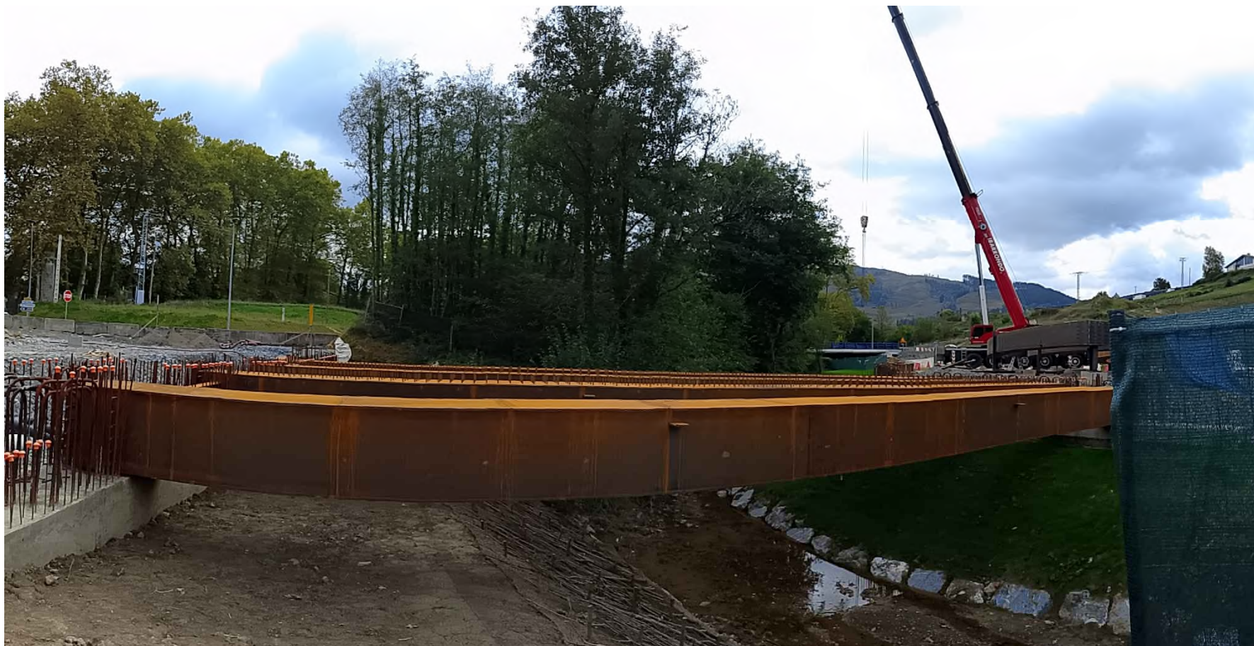
MONTAJE ESTRUCTURA-3 ETXEBERRIA
