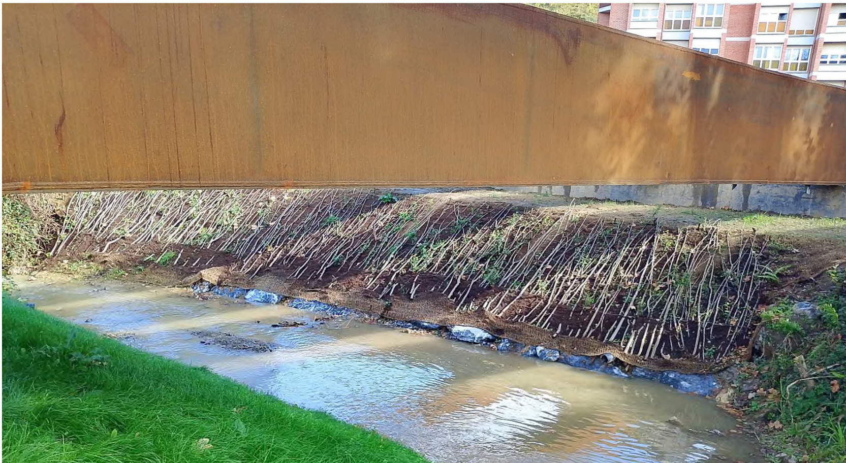
ESTERA DE RAMAJE EN EL ARROYO MUNIBERREKA BAJO LA ESTRUCTURA-3
