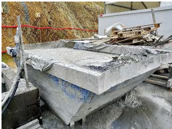
Foto nº5: Limpieza de canaletas en S4
