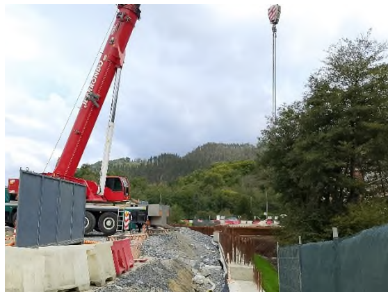
Foto nº6: Montaje de vigas E3
