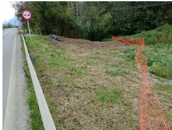
Foto nº41: Balizado aguas arriba.
