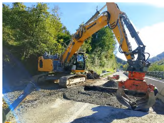
Foto nº23: Retirada de la capa de asfalto
