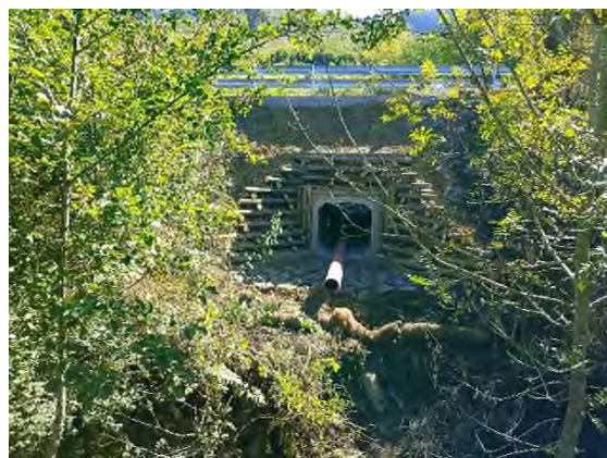
Foto nº27: Tubo para evitar el paso de agua en la zona de obra
