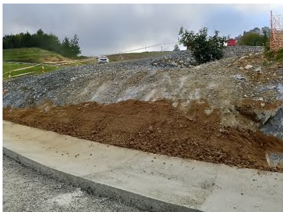
Foto nº3: Extensión TV talud eje 2
