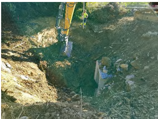
Foto nº24: Reperfilado de la zona aguas arriba
