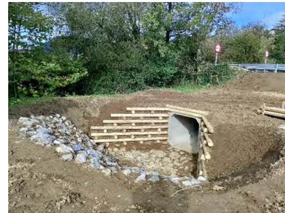
Foto nº45: Muro Kraimer aguas abajo.
