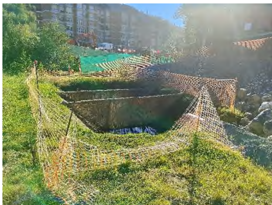
Foto nº1: Balsa decantación Etxebarria
