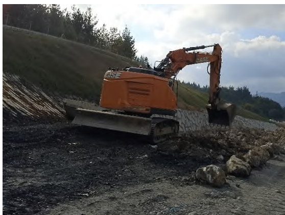
Foto nº1: Eje-21 regularización y explanada
