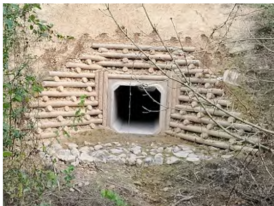
Foto nº32: Encachado de piedra en tierra aguas abajo.
