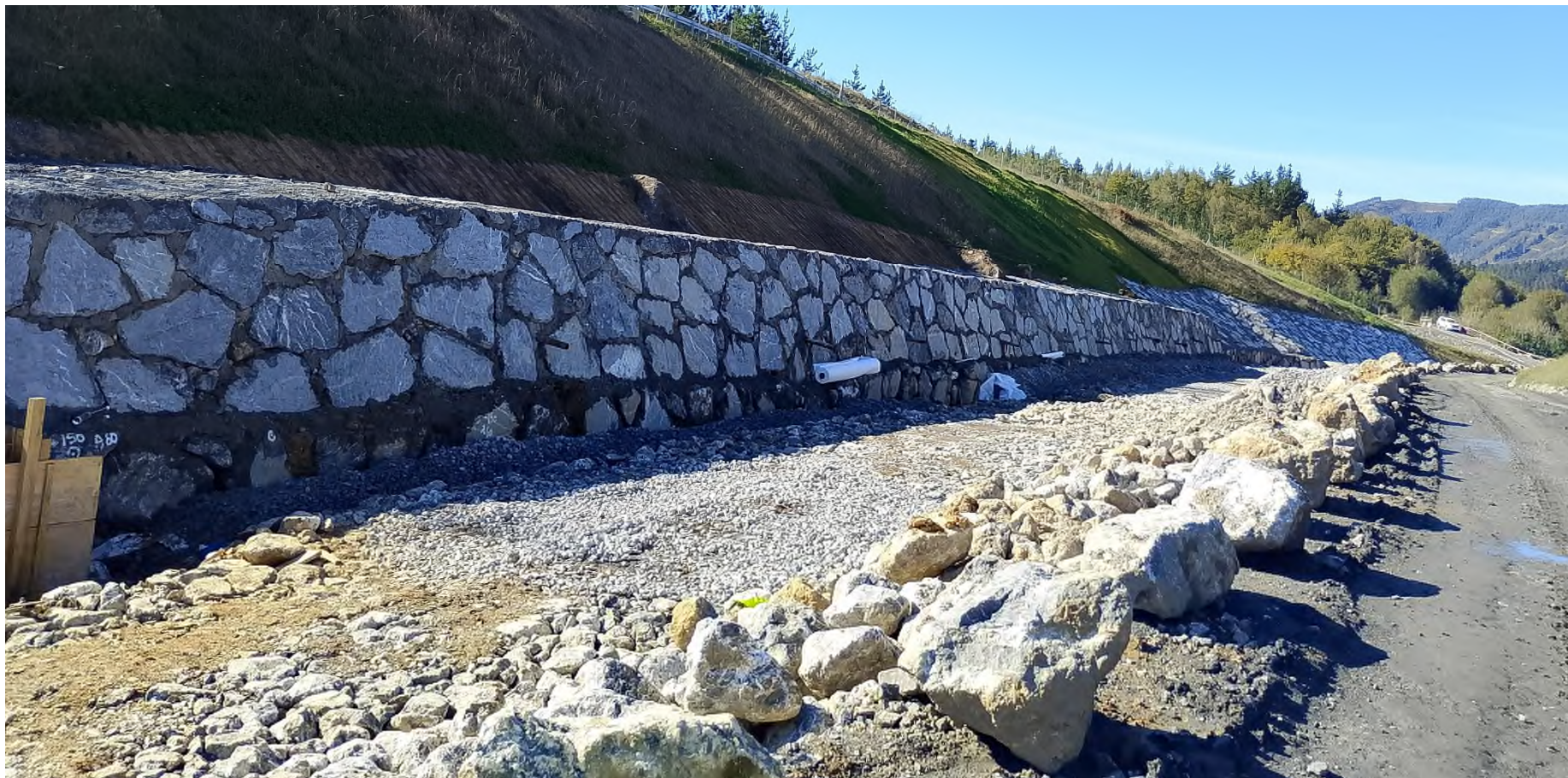
EJE 21-MARKINA, MURO DE ESCOLLERA
