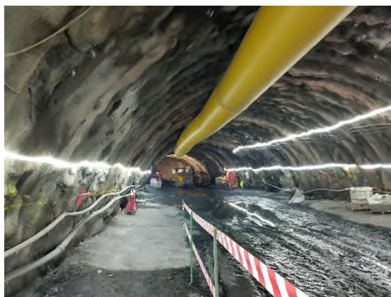
Foto nº2: Excavación en mina del tunel
