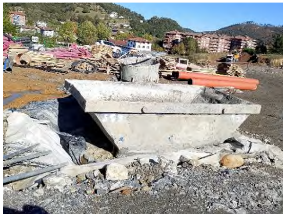
Foto nº6: Limpieza de canaletas en Markina
