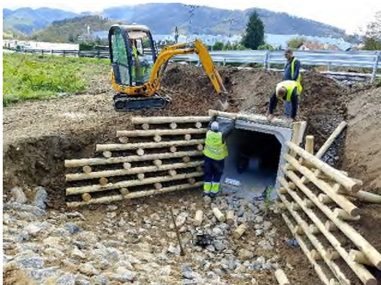
Foto nº44: Instalación de muro Kraimer.
