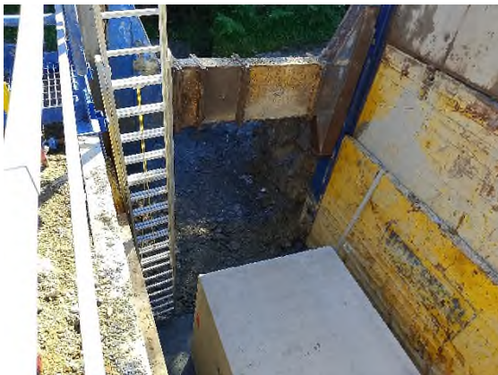
Foto nº22: Instalación de marcos en MC2
