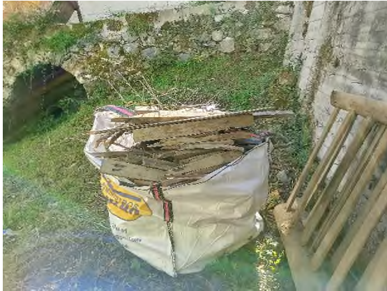
Foto nº46: Acopio de residuos derivados de la retirada de la estructura
