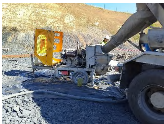
Foto nº8: Zona gunitadora túnel Etxebarria
