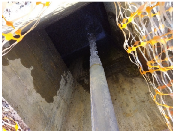
Foto nº20: Vertido de la depuradora
