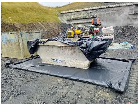
Foto nº7: Zona auxiliar de inyección para el emboquille de Etxebarria
