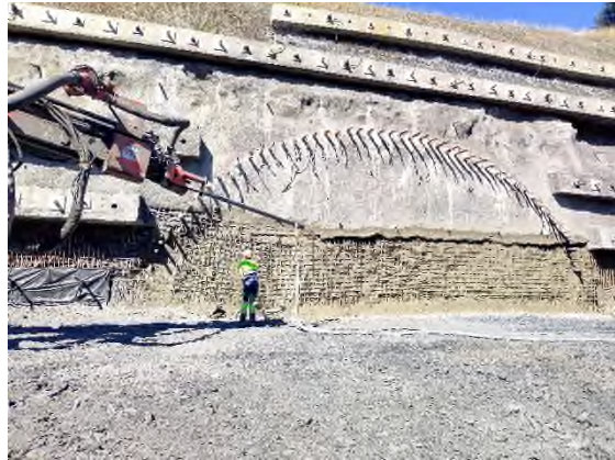
Foto nº4: Gunitado emboquille tunel Etxebarria
