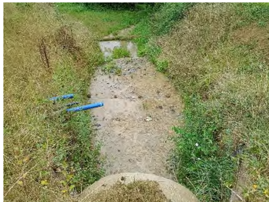
Foto nº26: Barreras habilitadas en ODT-04
