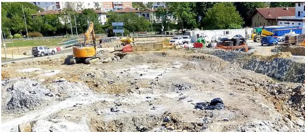
Foto nº25: Preparación de la zona del eje-2 para voladura
