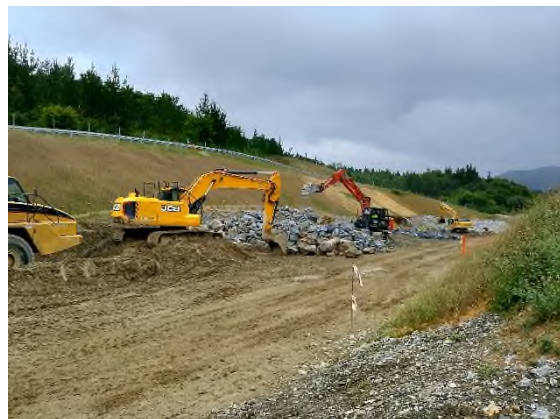
Foto nº2: Excavación Eje-21 Markina
