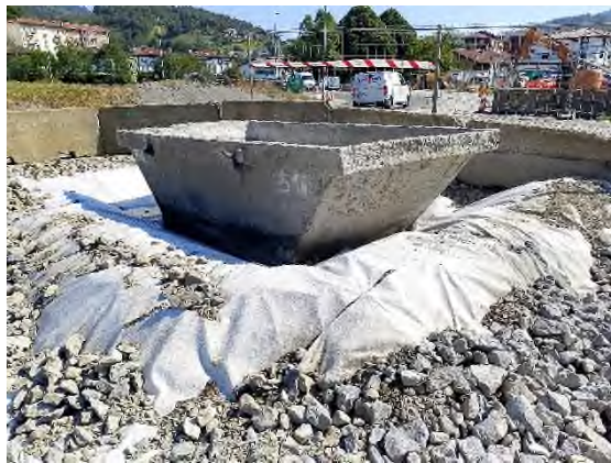
Foto nº6: Limpieza de canaletas en Markina
