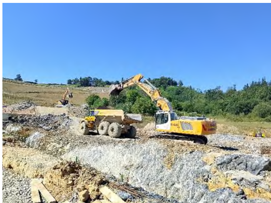
Foto nº1: Excavación eje-2 Markina
