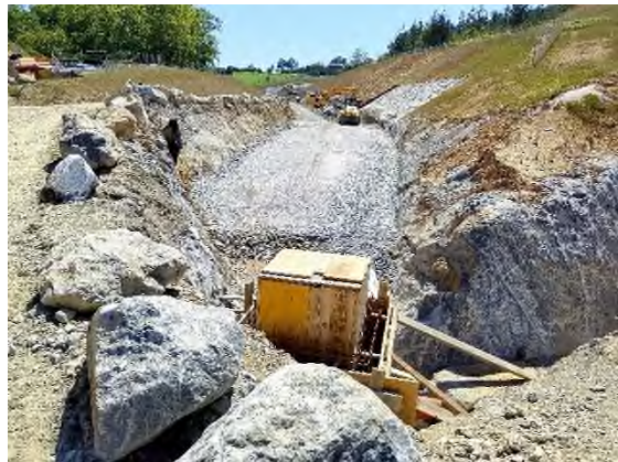
Foto nº6: Eje 21: colector y arquetas. Markina
