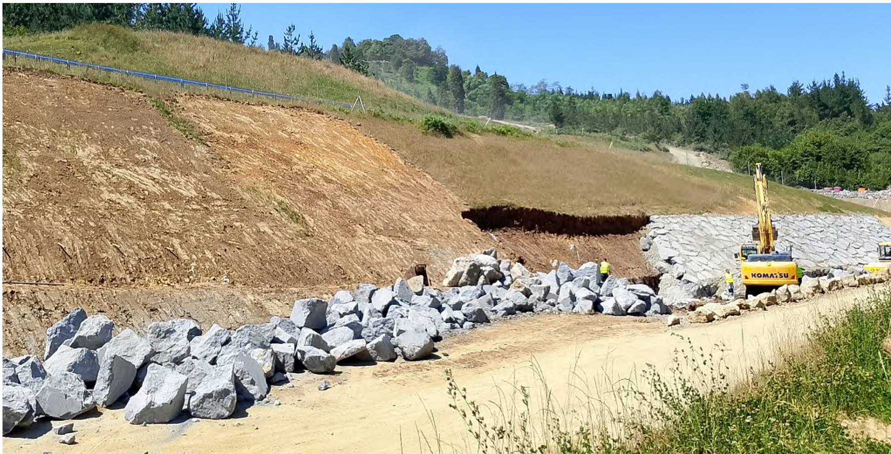
EJE 21, RETIRADA DE TIERRA VEGETAL DE TALUD Y PIEL Y MURO DE ESCOLLERA
