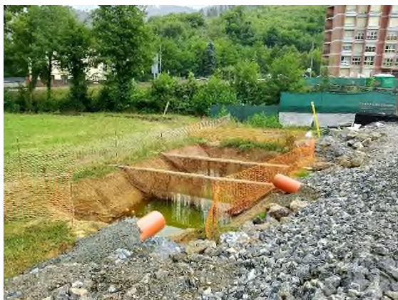
Foto nº1: Balsa decantación Etxebarria
