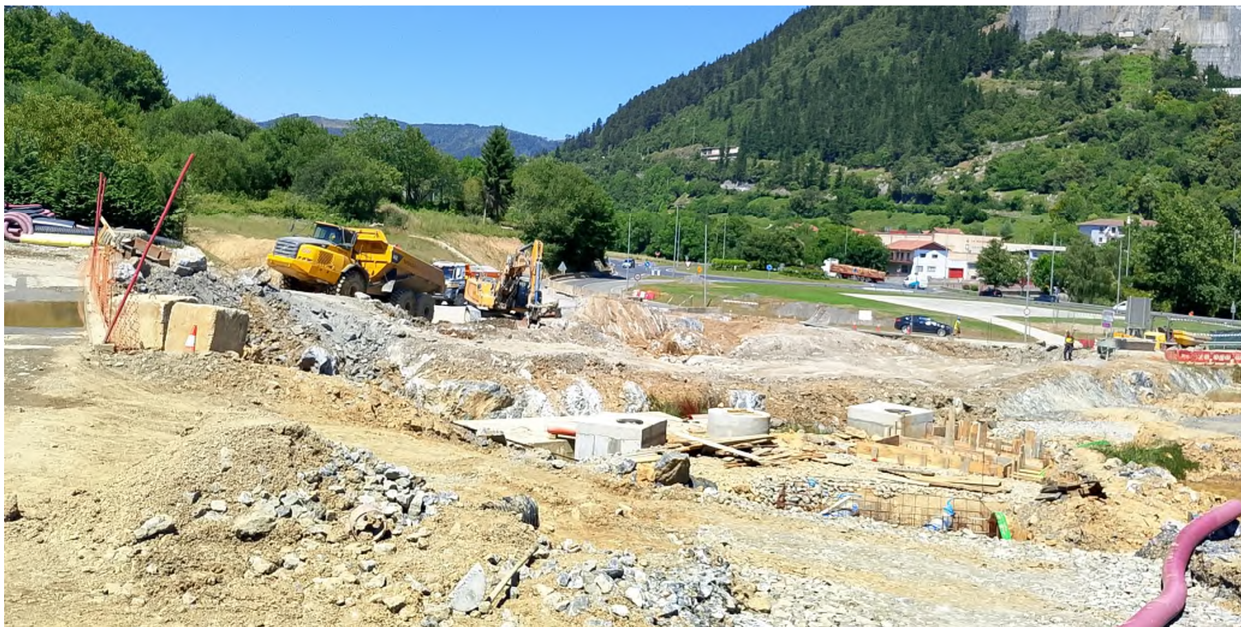
EJE 2-RETIRADA LAVARRUEDAS Y EXCAVACIÓN
