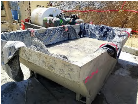
Foto nº5: Limpieza de canaletas en S-4
