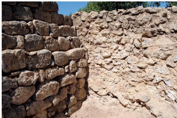
Figura 5. Imagen de la torre de ampliación.
