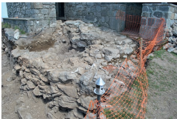
Figura 3. Cimentación de la cara interna de la torre del castillo. Se observa la ausencia de piezas externas.
