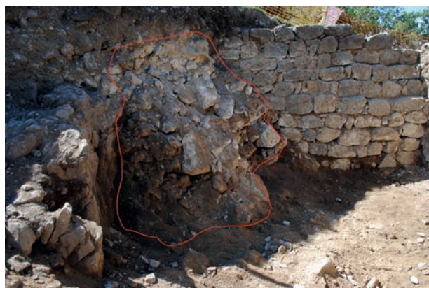
Figura 4. Imagen del relleno de derribo de la muralla.
