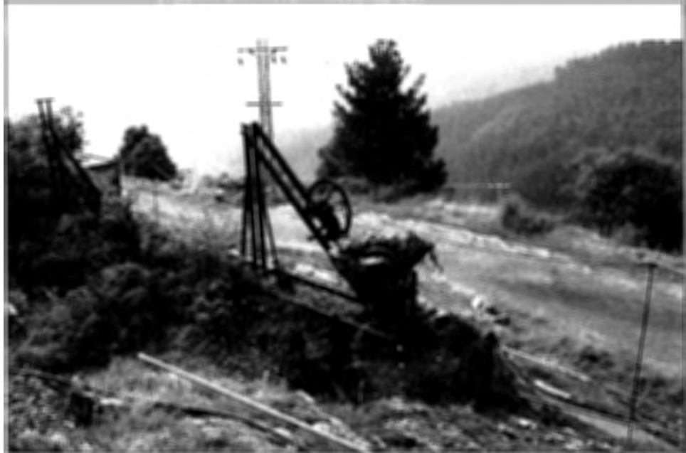
Foto 3: Carro tensor del cable helicoidal (Cantera Marnemar, Lekoiz Goikoa- Aulestia)
