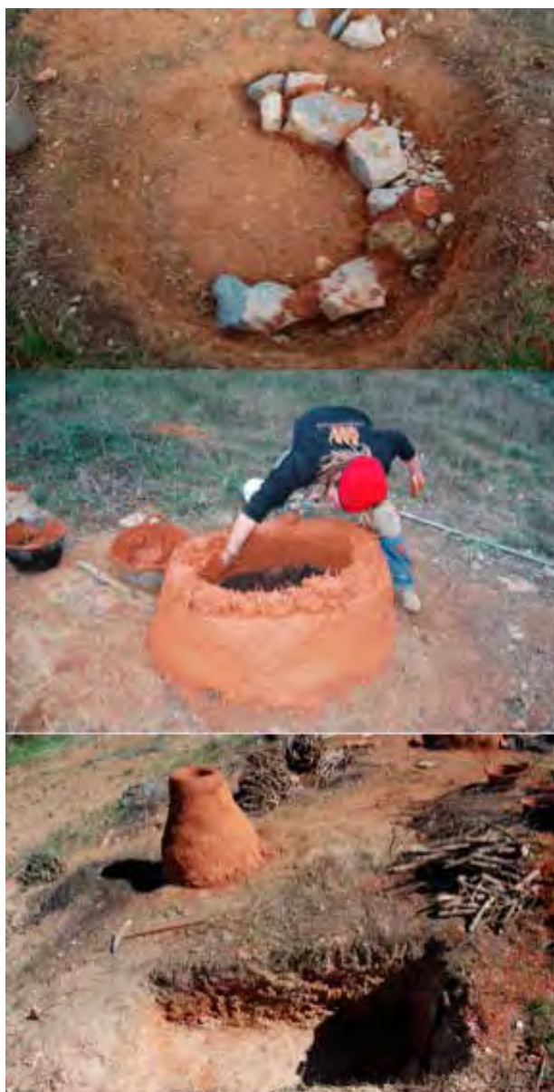
Figura 2. Secuencia constructiva del horno PRELU
