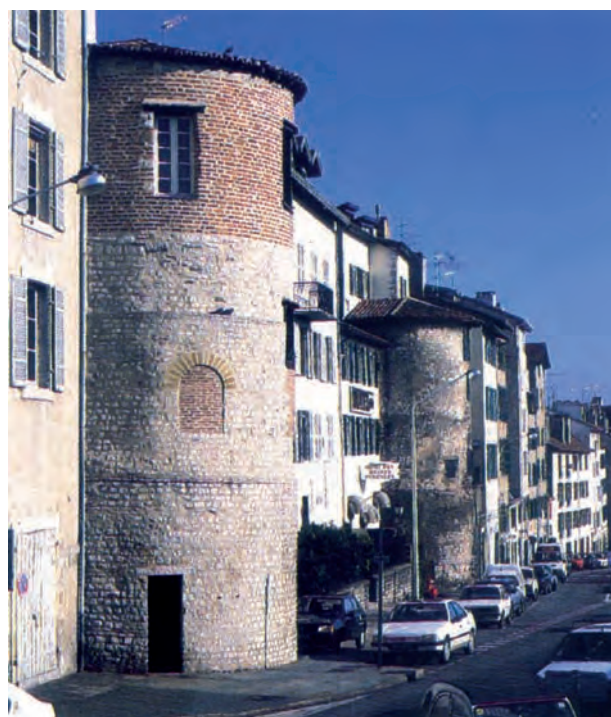
Figura 2.11. Bayona. Muralla tardo- antigua. En primer plano la torre de Deux-Sœurs, en segundo plano la torre du Bourreau (extraído de Maurin et al. 1992) (Autor P. Bardou).
