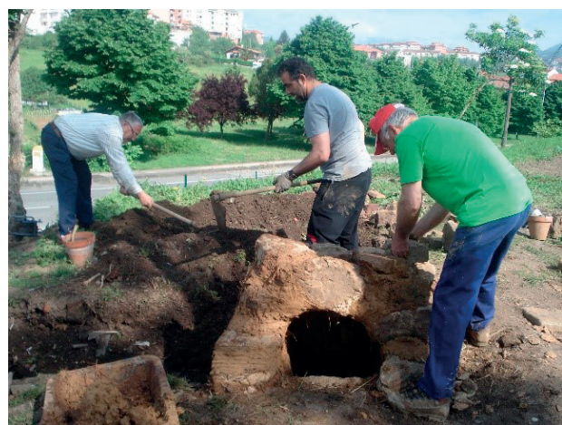
Figura 107. "Taller de arqueología experimental del hierro" en el Museo de la Minería del País Vasco. Izda. Construcción del espacio del taller (en primer plano el agujero de carga y descarga del horno sobre la "rampa" interior). Dcha. Horno de reducción. Abajo se ve el agujero practicado en el fondo del crisol y a la izquierda la forma rectangular donde embocaría la tobera y el fuelle.
