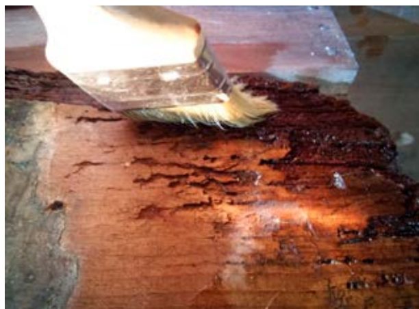
Figura 1. Aplicando consolidante.
