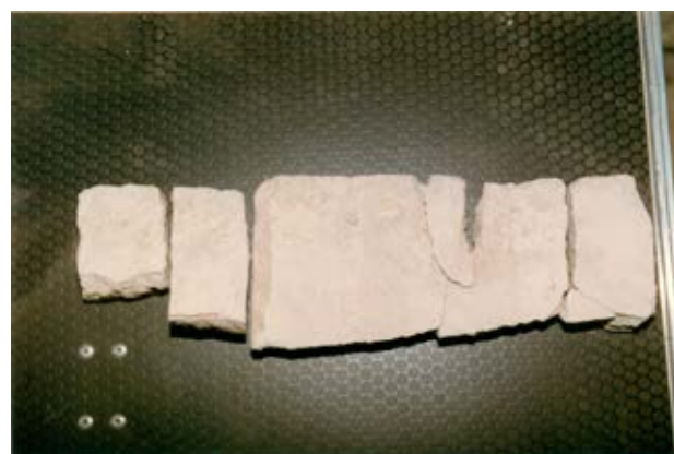
Figura 6. Donde había piezas reventadas, se desmontaron, se saneó el muro y se volvieron a montar.
