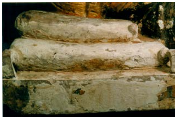
Figura 7. El aparejo de yeso es de gran espesor y se aplicó en varias capas.
