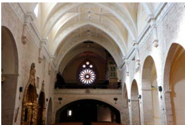
Figura 4. Nave hacia el oeste.
