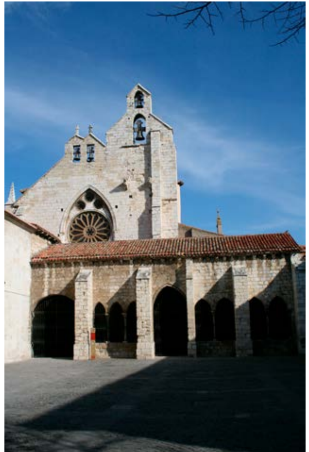
Figura 3. Exterior de la iglesia de S. Francisco en la actualidad.
