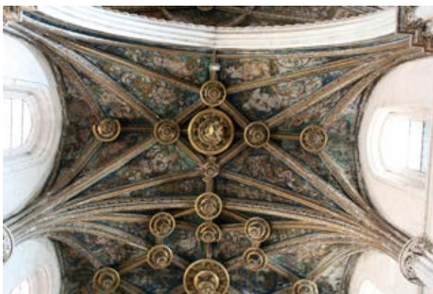
Figura 19. Bóvedas de la capilla mayor.
