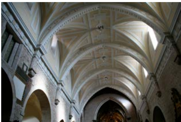
Figura 2. Bóvedas de la nave.
