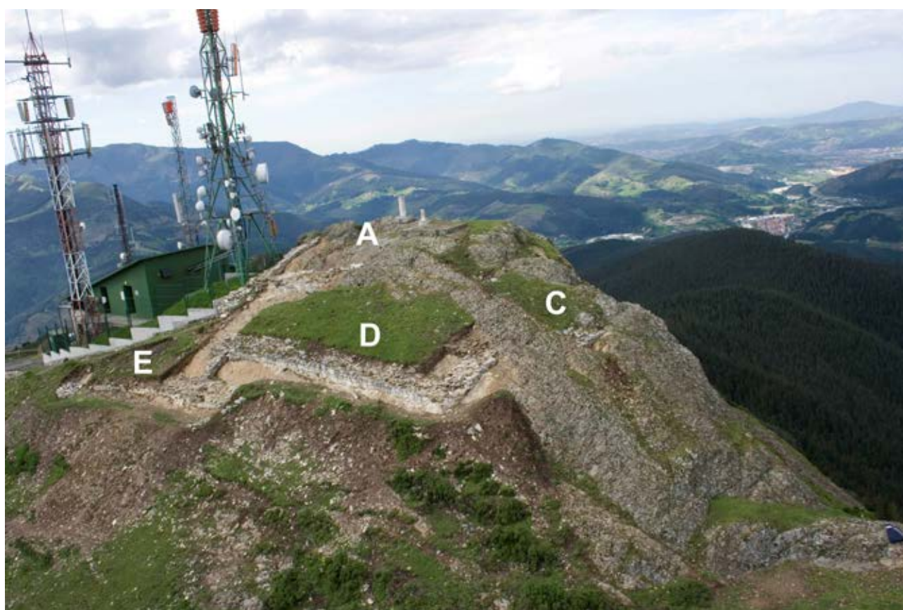
Figura 1. Vista general de la cumbre de Untzueta, con la ubicación de las diversas estructuras mencionadas en el texto. No se recoge el aljibe (B) por encontrarse desaparecido bajo el complejo de antenas de telefonía.
