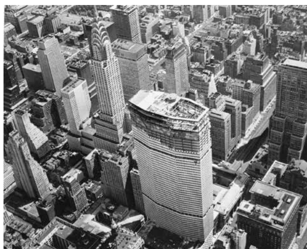
Figura 85. Edificio Chrysler. Nueva York (AMB-BUA, Fondo LGN, autor Associated Press Photo).
