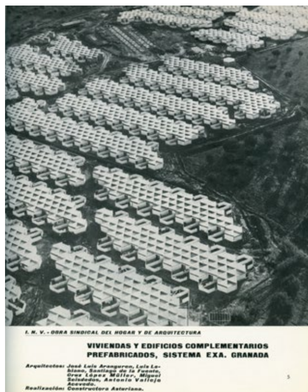
Figura 66. Viviendas prefabricadas sistema EXA ( Hogar y Arquitectura 61, 1965).
