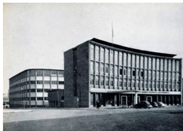
Figura 31. Escuela de Ingenieros de Bilbao (AMB-BUA, Fondo Ayuntamiento de Bilbao).
