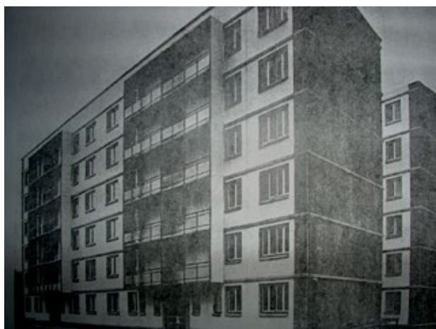
Figura 8. Viviendas prefabricadas en San Salvador del Valle (ECB Viviendas de Vizcaya Memorias 1966).
