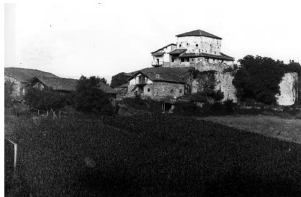
Figura 13. Vista general del Castillo de Butrón en 1870 antes del comienzo de las obras del Marqués de Cubas en 1879. Imagen: Propiedad de Enrique Ordiales Ginés.
