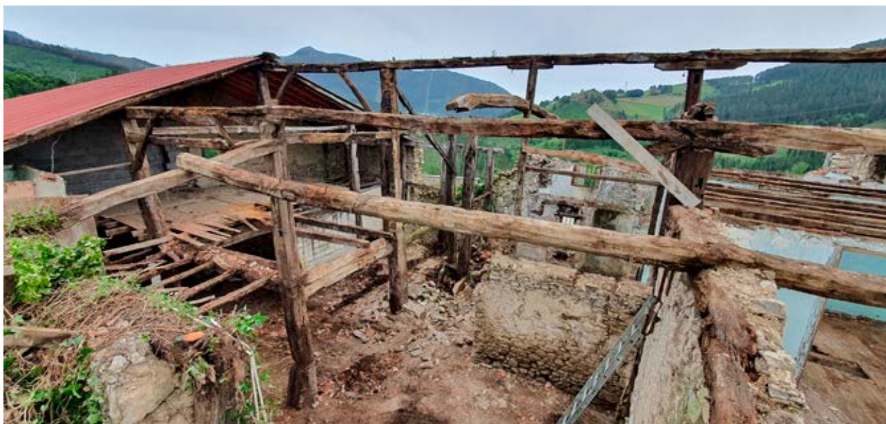
Figura 14. Estructura interior del caserío Elorriaga de Ziortza-Bolibar durante su rehabilitación del año 2021. Imagen: Ondare Babesa SL.
