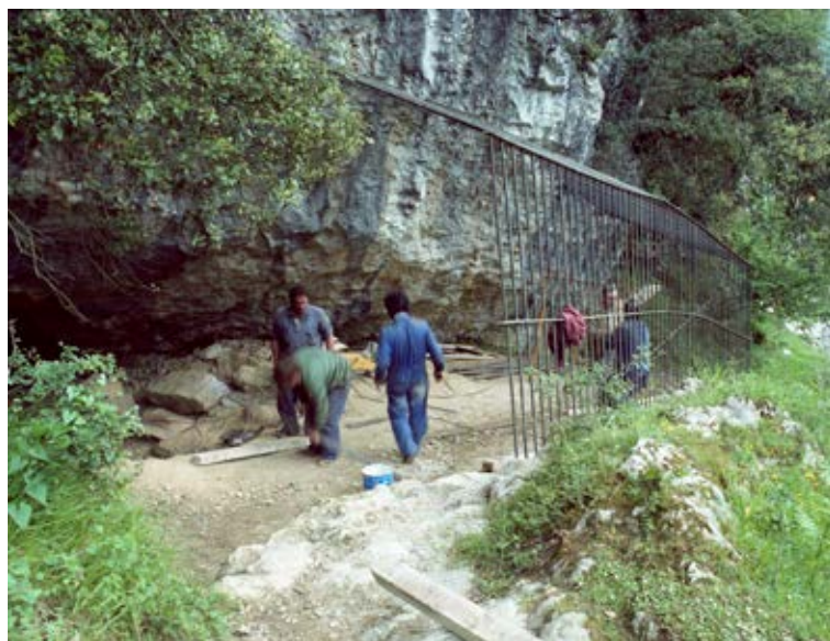
Figura 2. Colocación de la verja de protección en Axló en 1986. Imagen Archivo Arkeologi Museoa (Bilbao).
