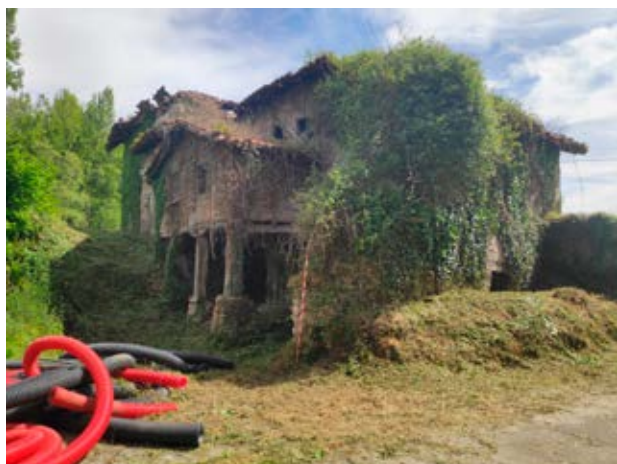
Figura 17. Vista general del molino de Torrelanda (Orozko) construido a finales del siglo XIX sobre la antigua obra hidráulica de la ferrería. Imagen: Ondare Babesa SL.
