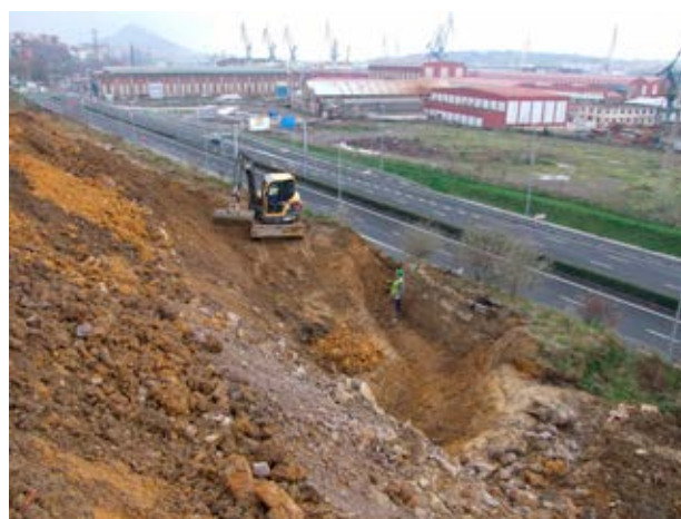
Figura 19. Localización de parte de los elementos defensivos durante la fase III (año 2010) en las excavaciones realizadas en el Convento de San José de la Isla (Sestao). Imagen: Haedera 2000 SL.
