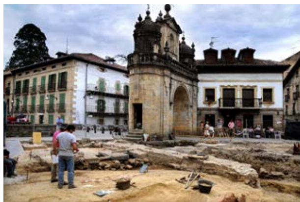
Figura 4. Proceso de excavación de la Plaza de Santa Ana de Durango en 2009. Imagen: Txelu Angoitia.
