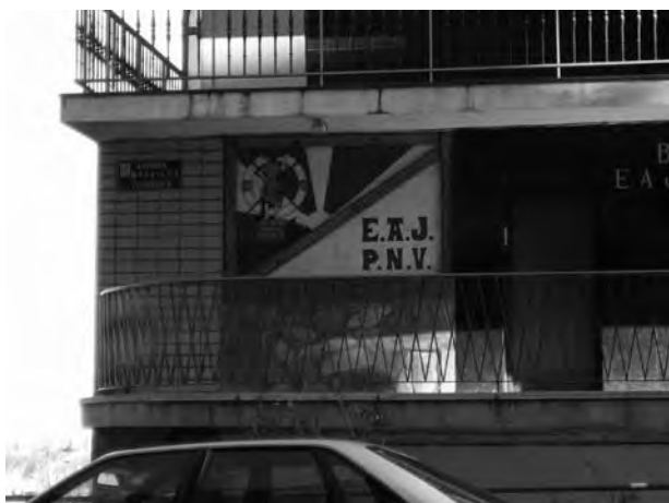
Fig. 13. Fachada del Batzoki (E.A.J.-P.N.V.) de Avenida Murrieta.
