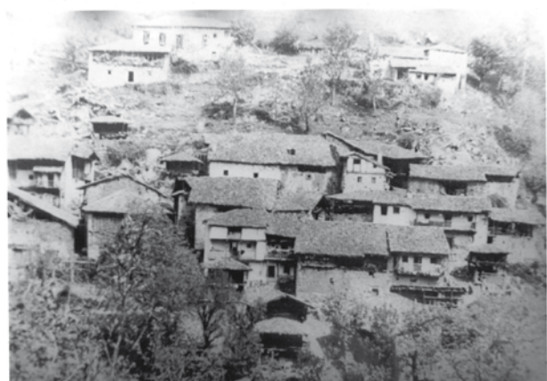
Fig. 73. Las Ilces a mediados del siglo XX. Se observan algunos antiguos hórreos, hoy inexistentes (Santos, 2010).
