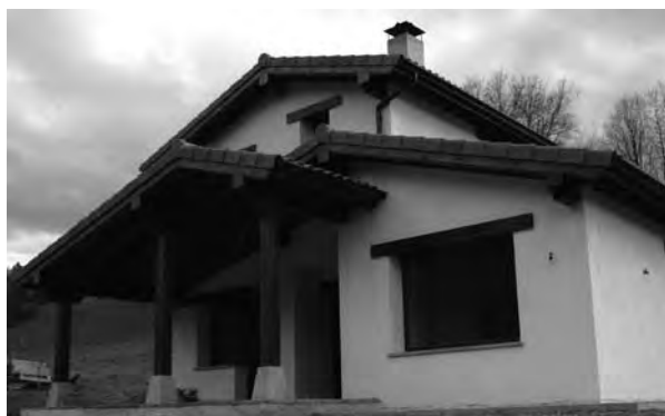
Fig. 8: Casa de nueva construcción
