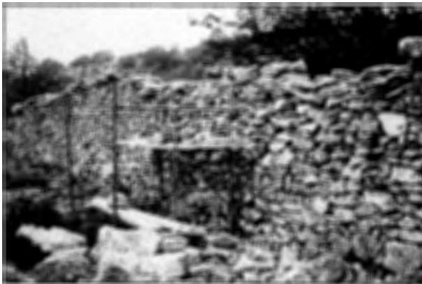
Foto 3 Terminando la reparación de un boquete de la pared de la lobera de Barrón.
