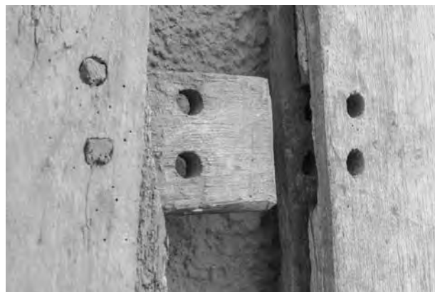
Figura 10. Lengüeta de engarce de dos tablas.
