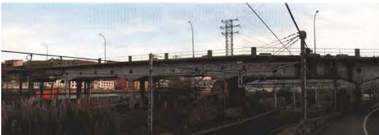
Figura 8. Patrimonio industrial anónimo superviviente en medio de la nada.
