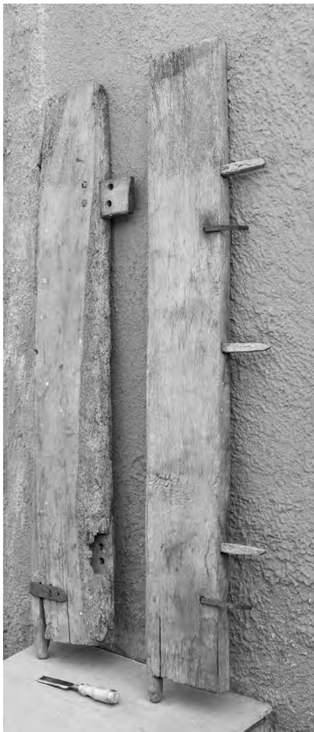
Figura 8. Dos sistemas de engarce de las tablas de dos puertas diferentes. A la derecha, con tornos de madera; a la izquierda, con lengüeta.
