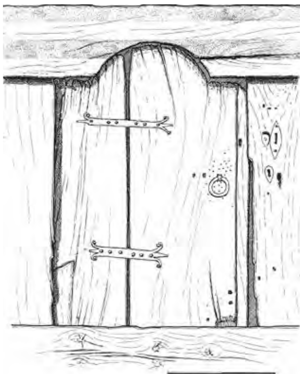
Figura 11. Puerta con refuerzos de hierro en Fíos (Parres).
