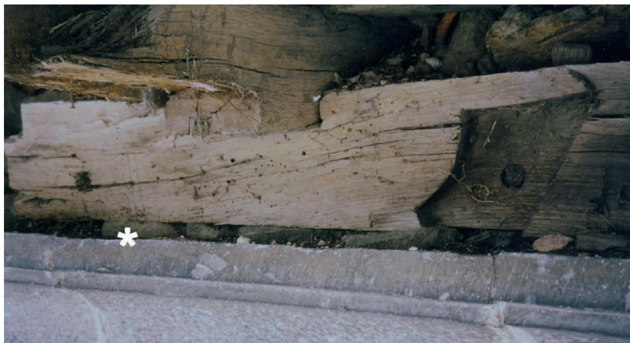
Figura 15. Sur même type de pièce, vestige d'un assemblage à demi-queue d'aronde avec marque d'assemblage (astérisque). Eglise d'Ainhoa
