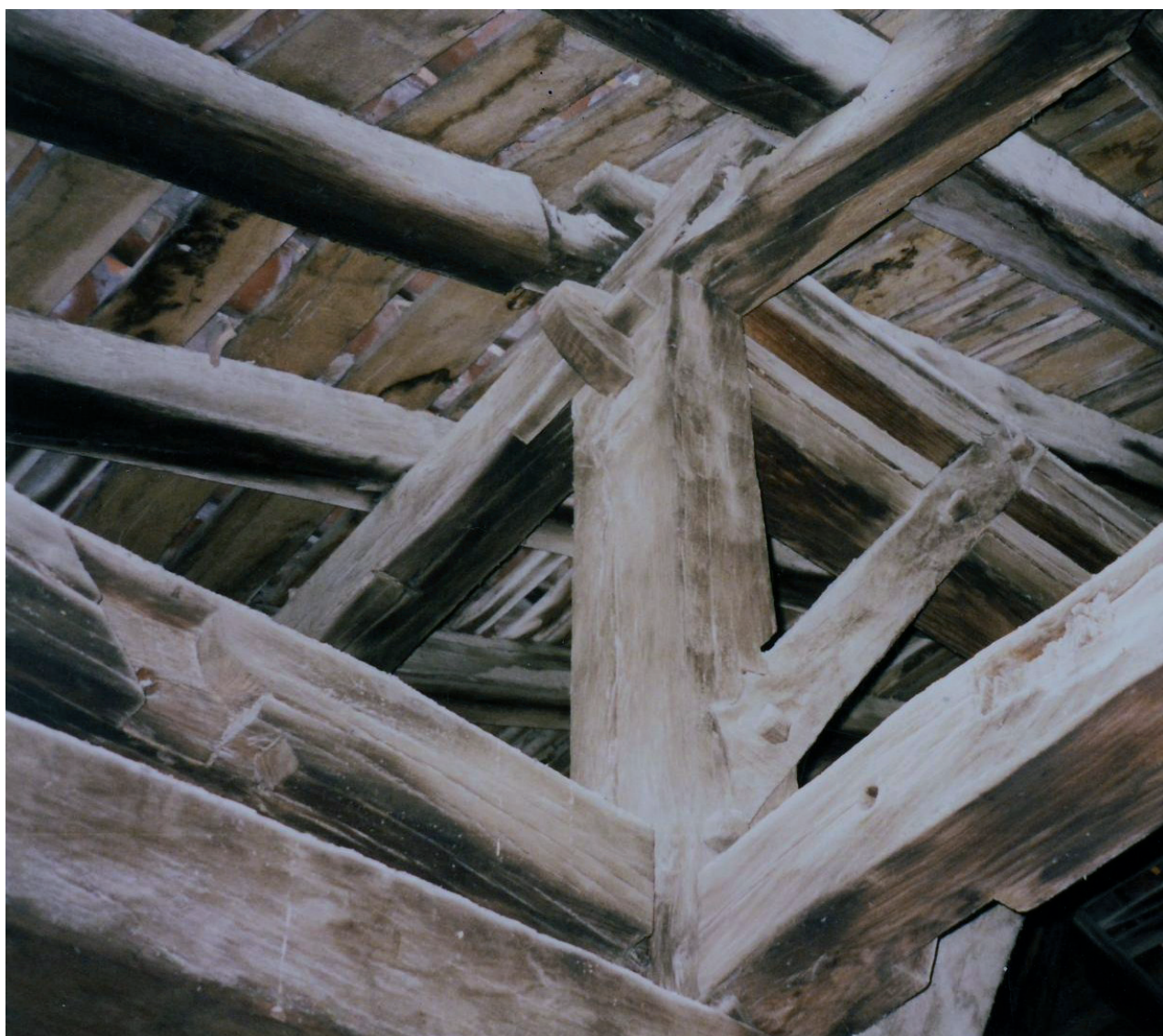
Figura 12. Détail du montage au niveau de l'un des potelets ; les vestiges d'assemblages inusités trahissent le remploi
