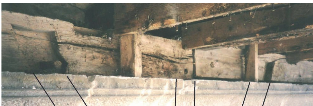
Figura 13. Ancien montage supportant les extrémités des chevrons dans le château en bois. Depuis la reprise du bâtiment (au XVII e siècle) ce montage joue un rôle de sablière. Les traces de son assemblage ancien sont bien visibles et aisément restituables (dessin)
