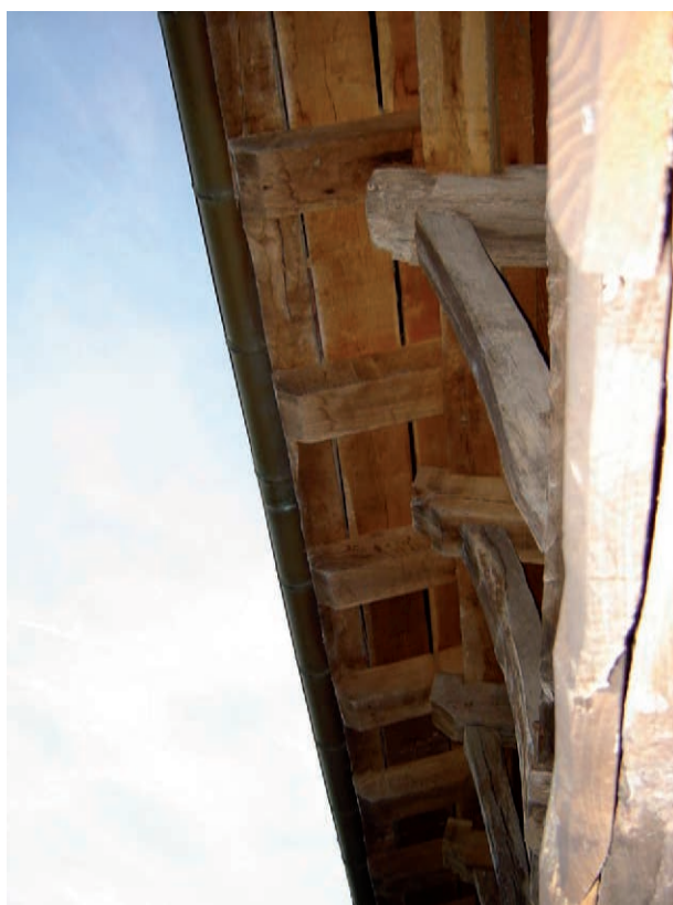
Figura 17. Abouts des chevrons avec ou non leurs aisseliers, dans de la charpente de toit médiévale (16 : église d'Ainhoa, 17 : jauregi du Baztan)
