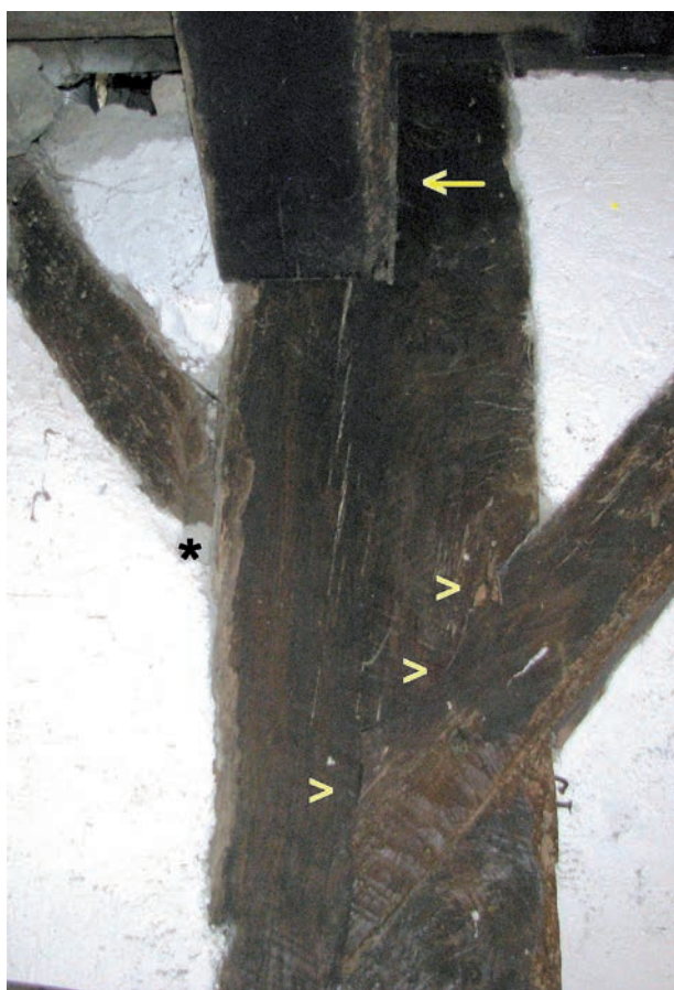
Figura 5. Poteau avec abouts de 2 liens : 1) à gauche, un pigeâtre (soutenant l'ancien encorbellement) assemblé en tenon-mortaise ; 2) à droite, classique assemblage à demi-queue d'aronde (noter le cran suivi des deux courbes) ; la flèche montre une poutre assemblée latéralement (ce qui est classique)
