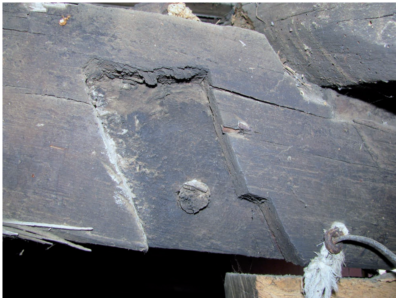
Figura 4. Encoche (ozka) de l'assemblage en demi-queue d'aronde
