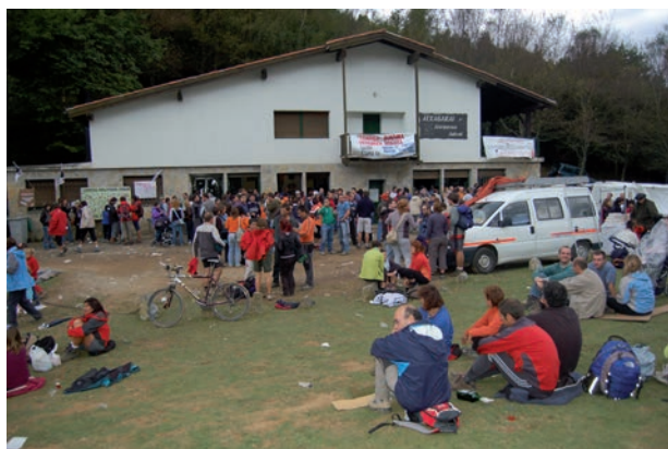
Figura 6. Atxagarai Aterpetxea , reformado y ampliado con una segunda planta (2006)
