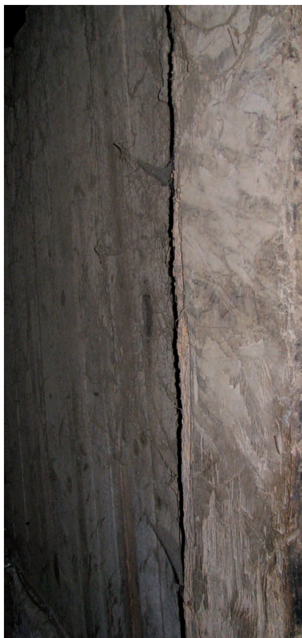
Figura 6. Poteau équarri à la hache (à gauche) suivi d'une cloison de planches (grenier de maison de bois longs)
