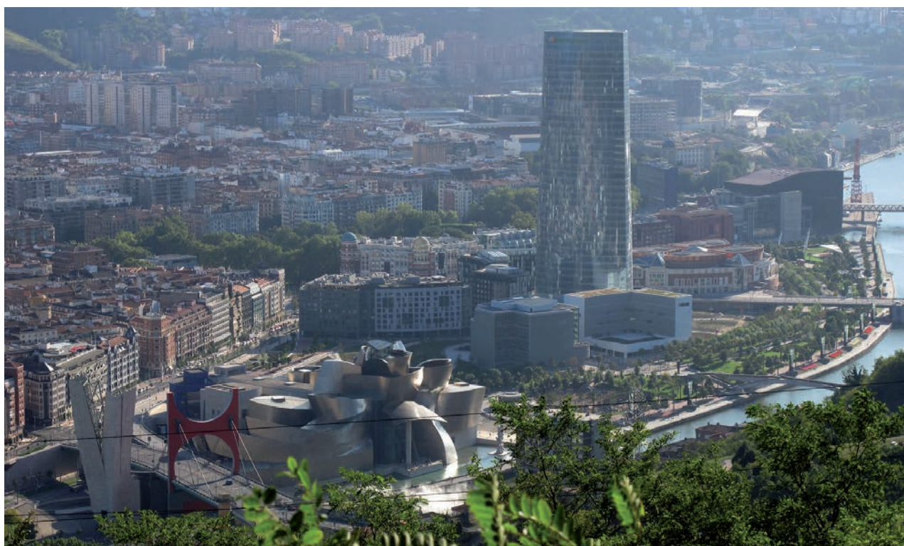
Figura 4. “Torre Iberdrola” en el frente fluvial de Abandoibarra (foto 2011, I. V.).
