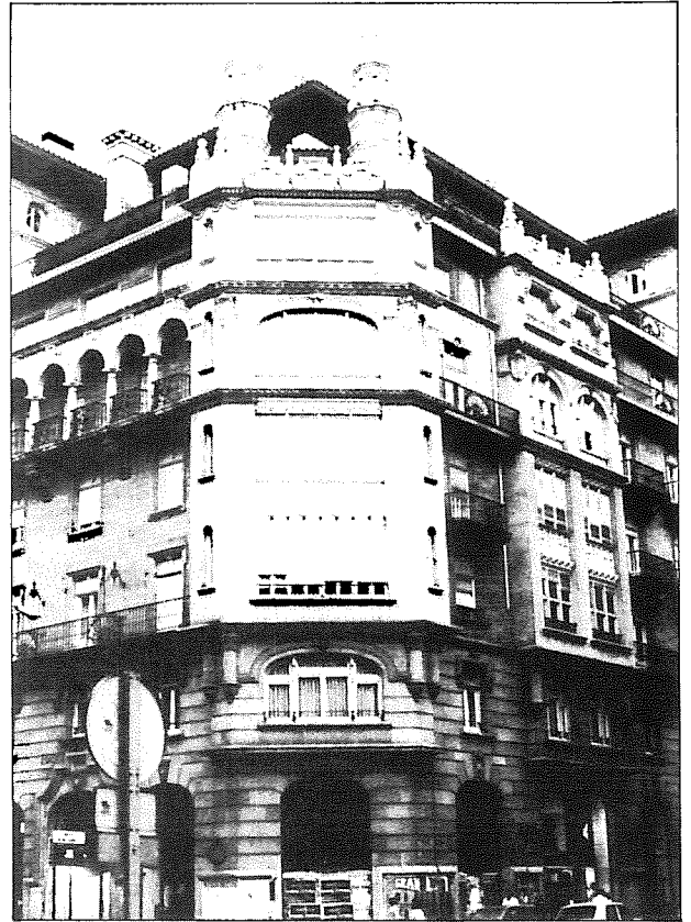
Fotografías n.ºs. 24, 25 y 26. Detalles del Edificio Sota. (Estado actual).
