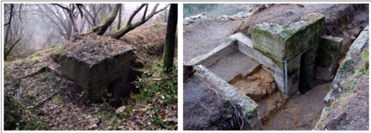
Figura 25. Eperlanda I. Antes de comenzar los trabajos de limpieza y seguimiento arqueológico y una vez finalizados. Se observa claramente el trabajo inacabado del suelo y escalones (Fotos I. Libano).
