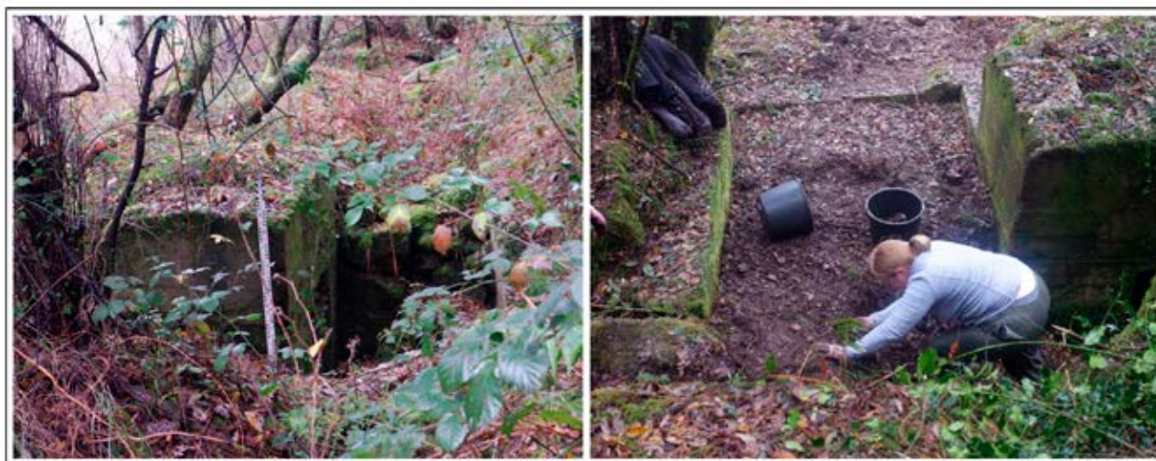
Figura 9. Eperlanda I antes de comenzar la intervención de limpieza (9-12-2019) e inicio de la limpieza de restos orgánicos modernos y restos de hormigón (Fotos I. Libano).
