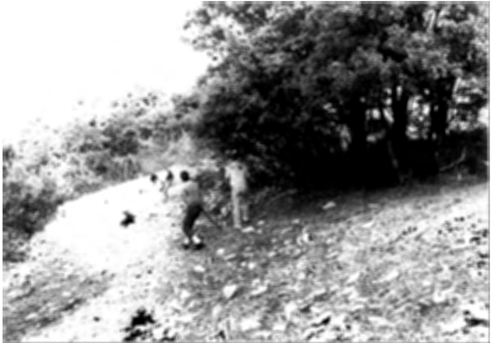
Foto-4: Abundancia de piedras en el derrumbe de la terraza. Tal vez restos de muralla.
