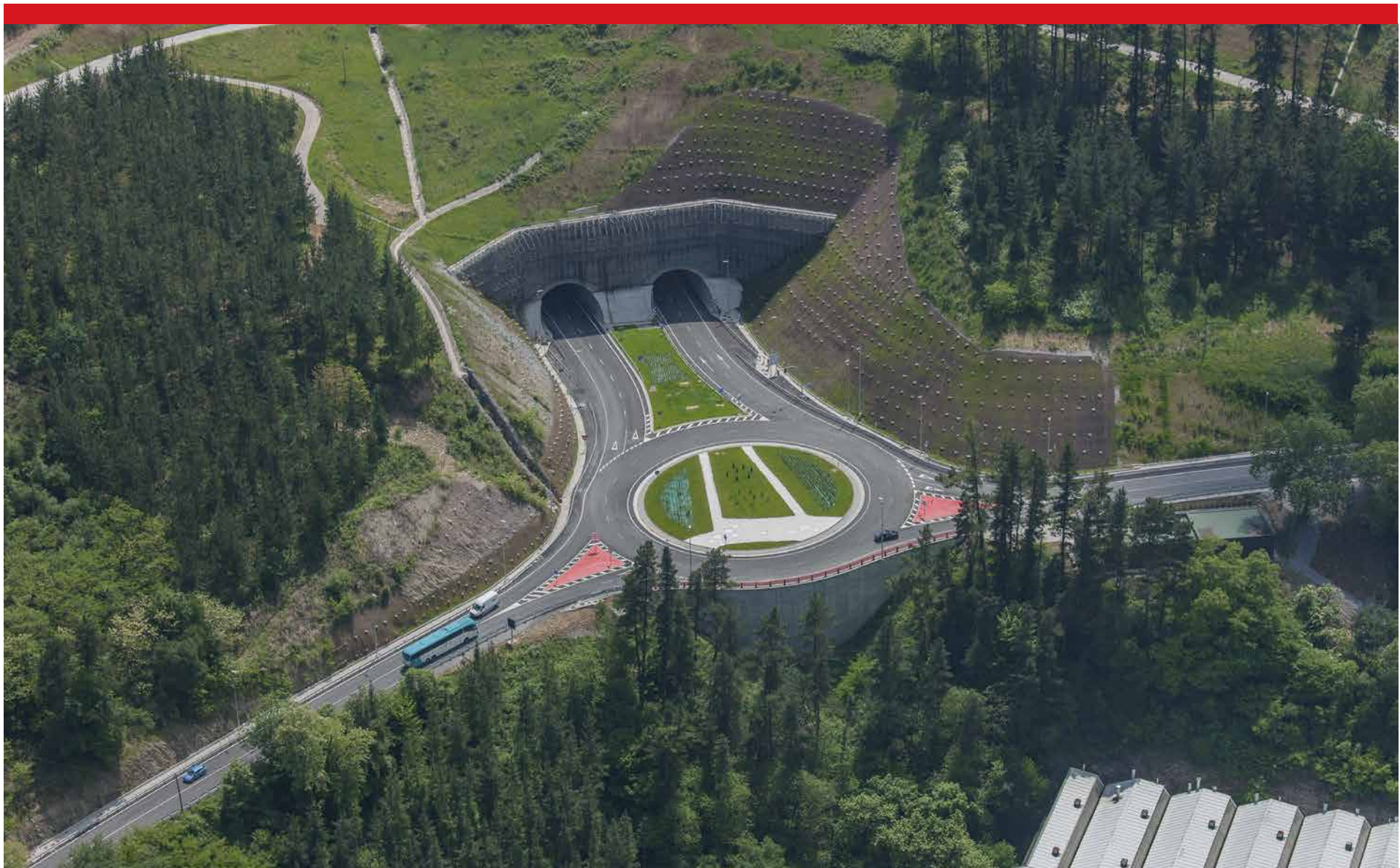
N-634. Acceso norte a los Túneles de Uretamendi.
