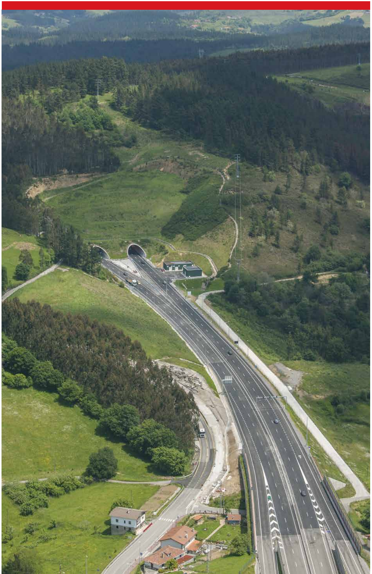
BI-635. Acceso norte a los Túneles de Urdinbide.
