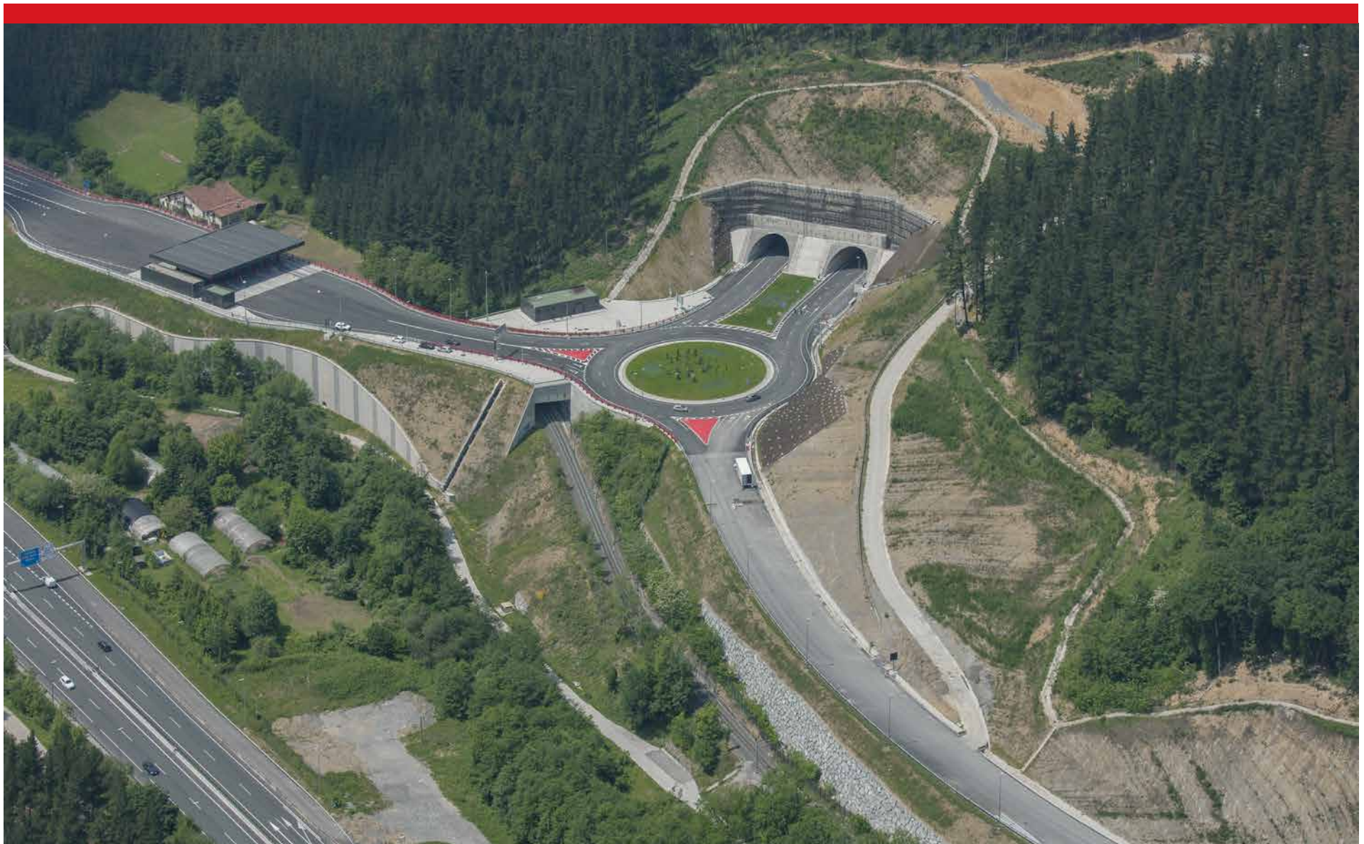
N-634. Acceso sur a los Túneles de Uretamendi.
