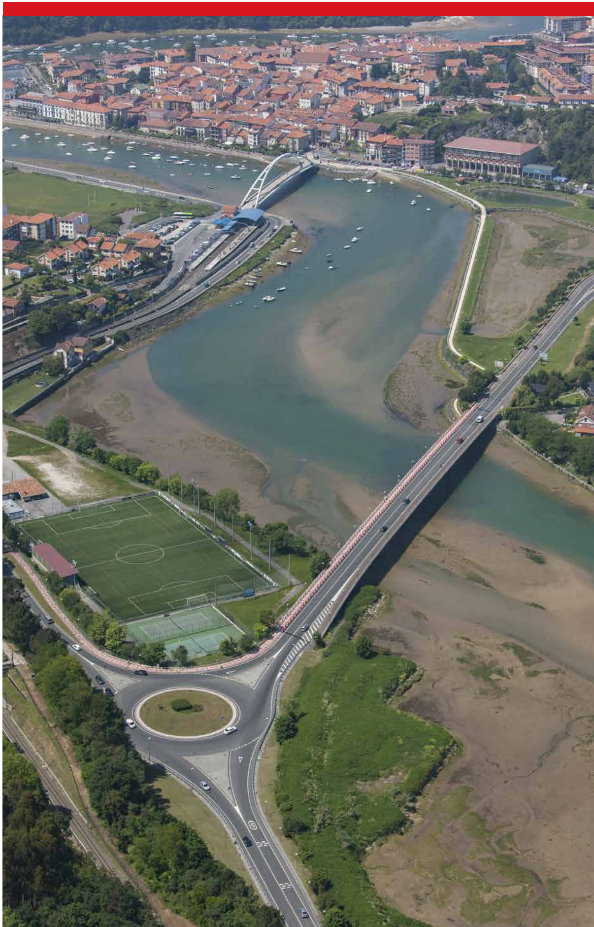
BI-2704. Rotonda de acceso al Puente de Plentzia.
