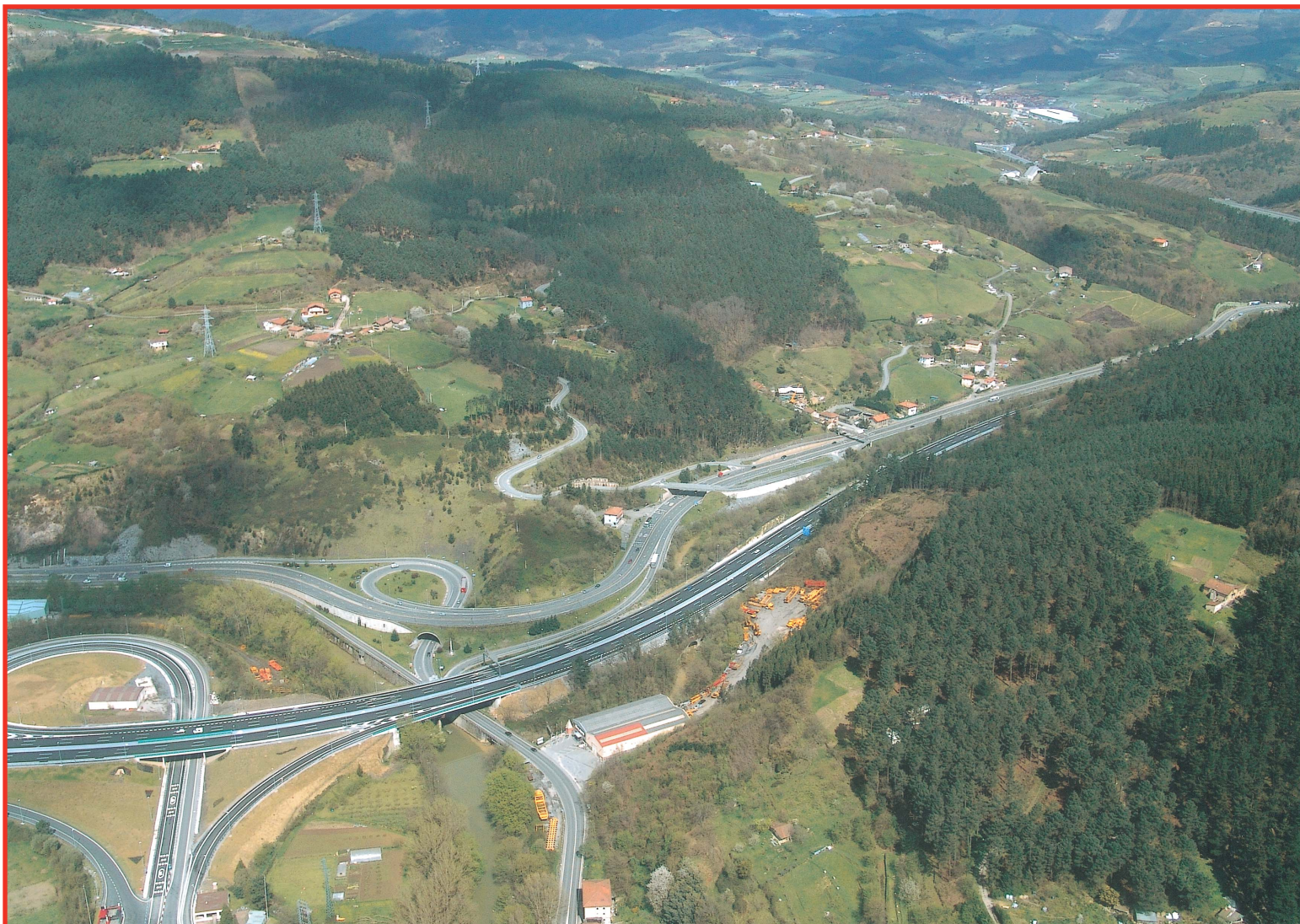
Remodelación del Enlace de El Gallo en la A-8 y ampliación de carriles en el tramo El Gallo-Erletxe.
