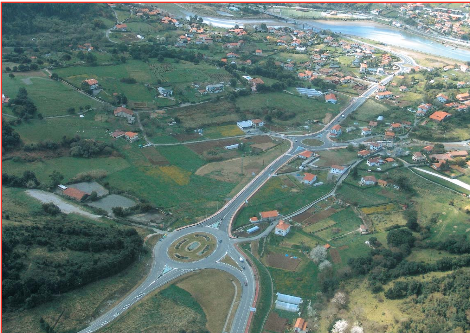
Remodelación del tramo Gandias-Sagastikoetxe en la BI-2120 entre Plentzia y Gorliz.
