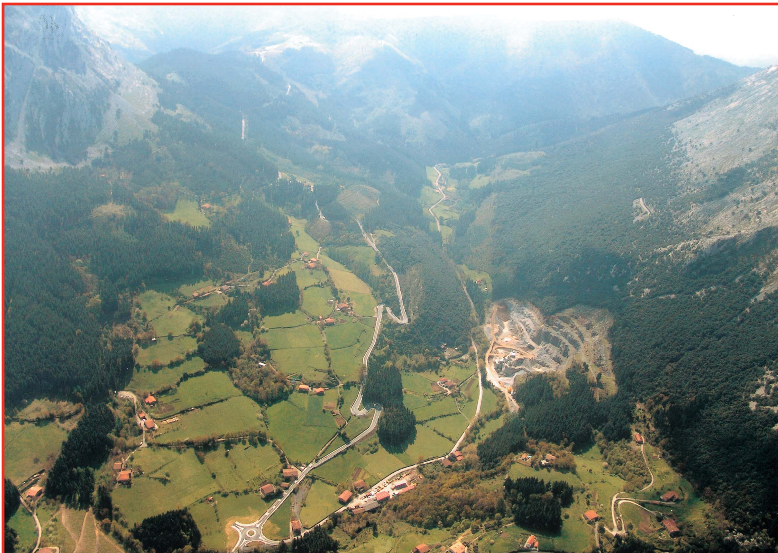
Remodelación de la BI-623 a su paso por el Pto. de Urkiola.
