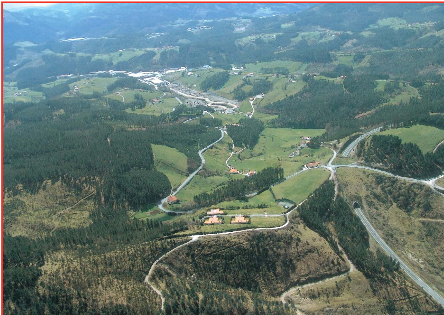
Alto de Trabakua. Remodelación de la BI-2301 hacia Ermua.
