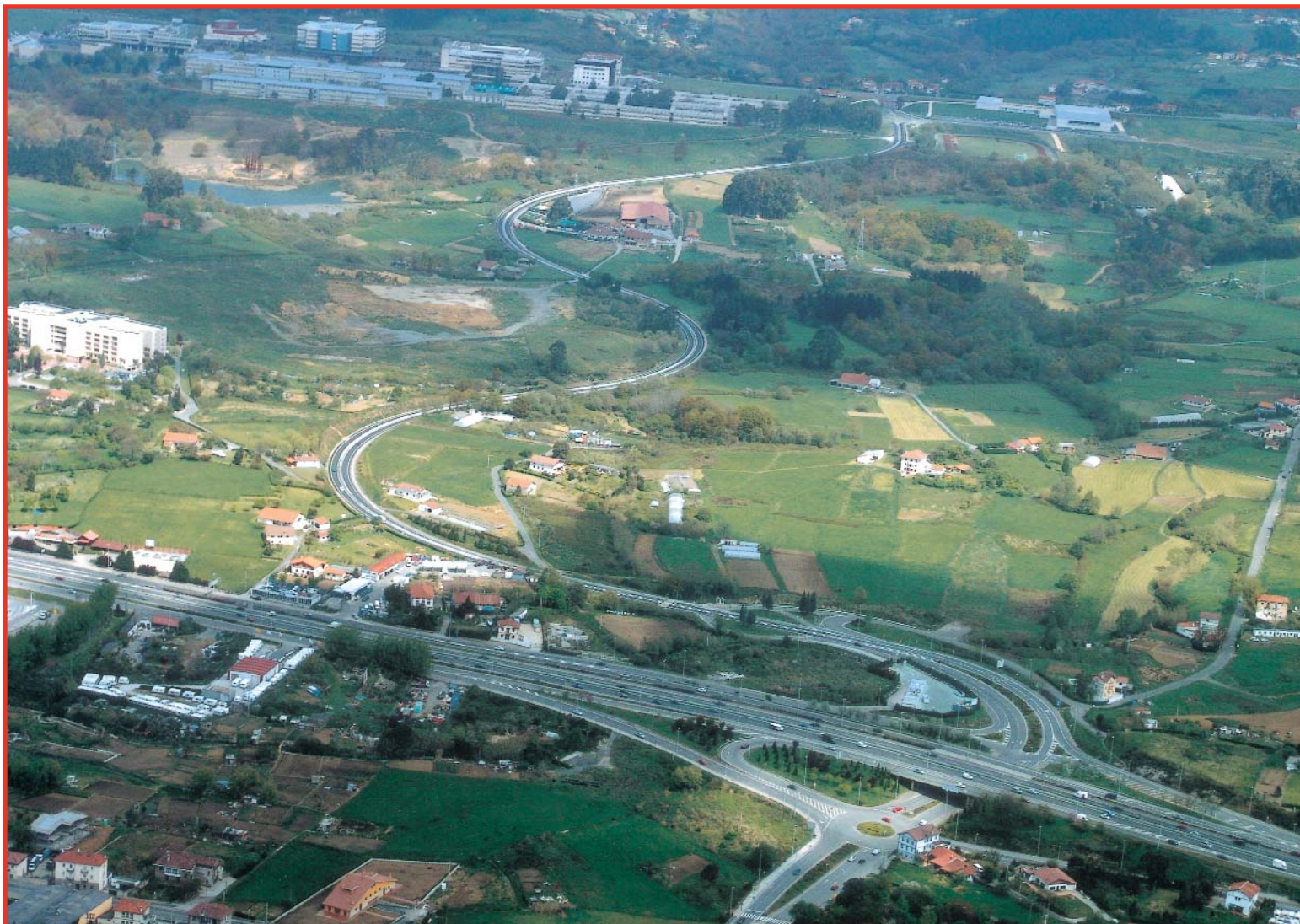
Remodelación de la BI-647. Subida a La Universidad de Leioa desde La Avanzada.
