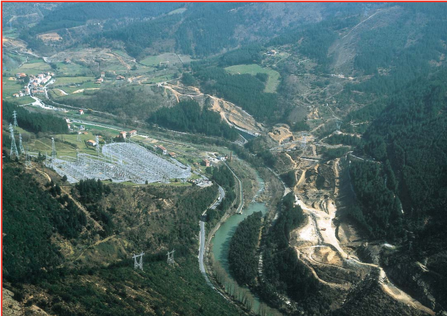
Corredor del Kadagua. Obras tramo Sodupe-Zaramillo.
