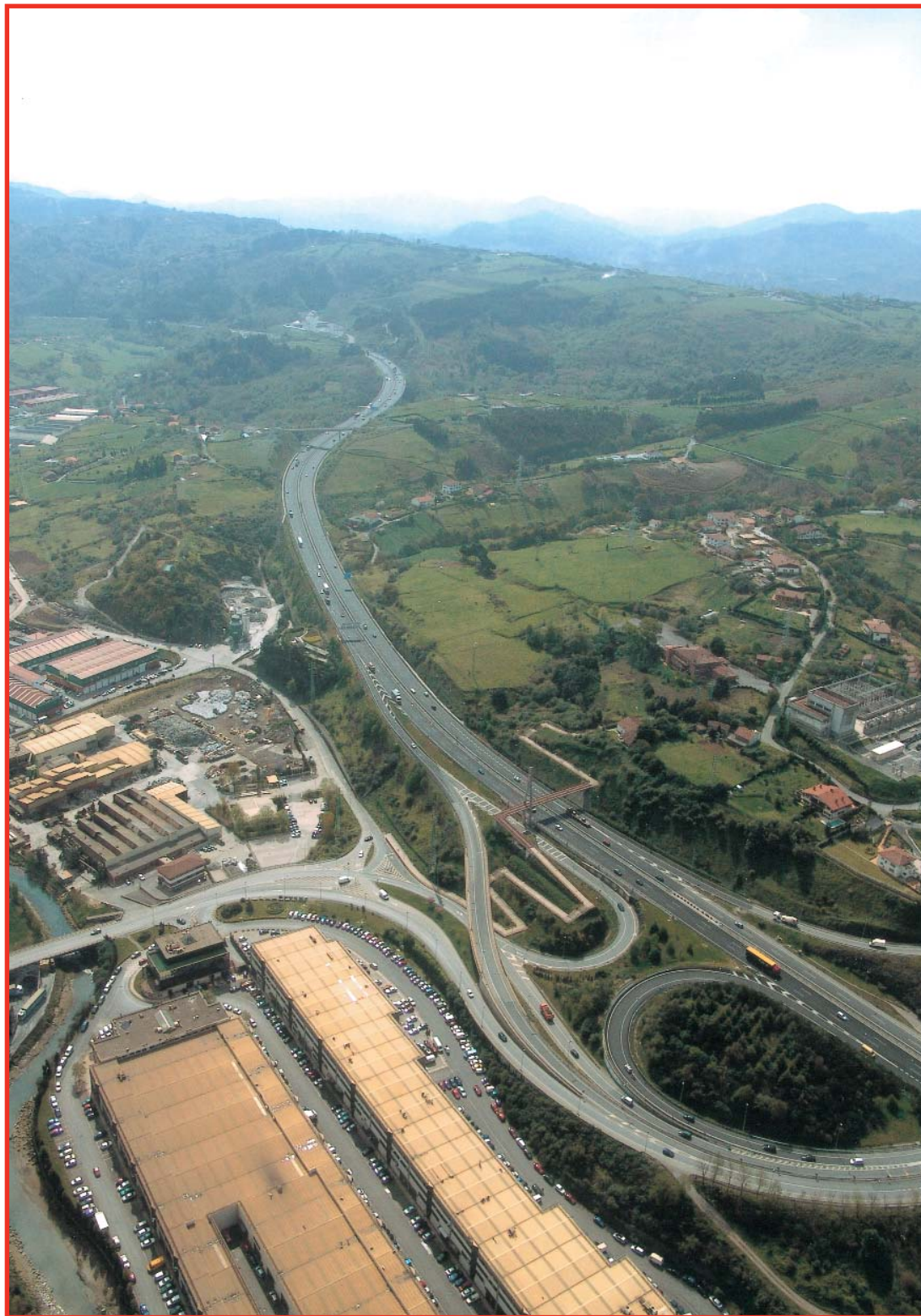
Corredor del Txorierri. Ampliación de carriles en el tramo Enekuri/Asua - Túneles Artxanda.
