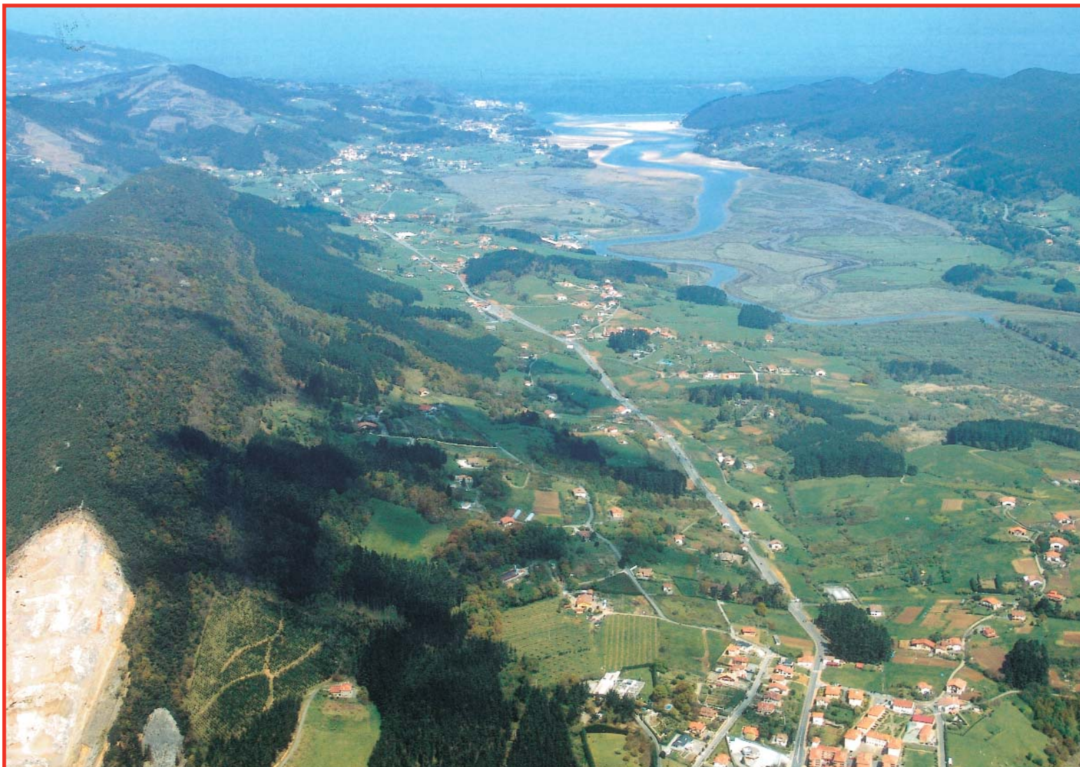
Corredor Gernika-Bermeo. Remodelación de la BI-2235.
