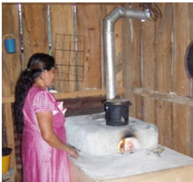
El tubo de lámina facilita la extracción del humo al exterior.
