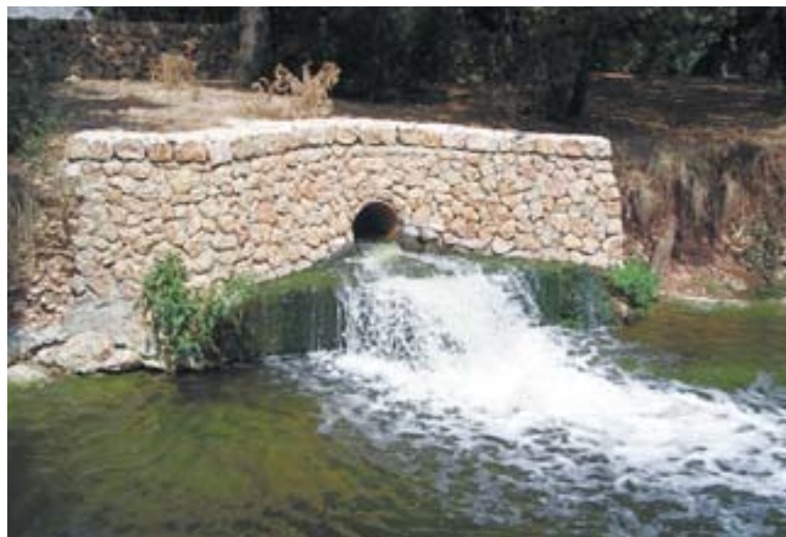
Salida de agua tratada en una planta depuradora.
