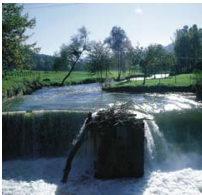
Diques y presas en desuso son obstáculos para la fauna de los ríos.
