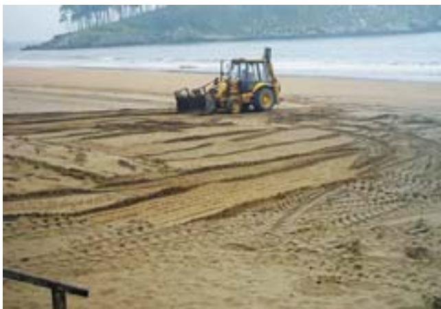
Limpieza previa a la puesta en marcha de la temporada.
