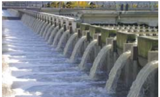
Depuradora de Galindo.
